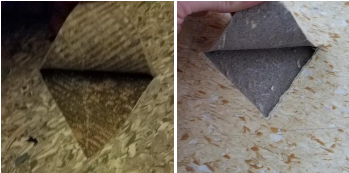
Kuva 41 ja 42. Vasemmalla nuorisotilojen käytävän viiltomittaus (VM16). Oikealla nuorisotilojen pelihuoneen viiltomittaus (VM17).
