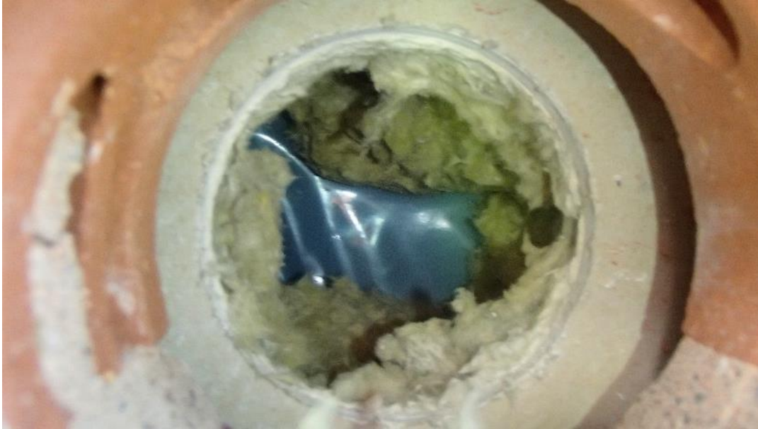
Kuva 10. Rakenneavaus ulkovaipparakenteeseen.
