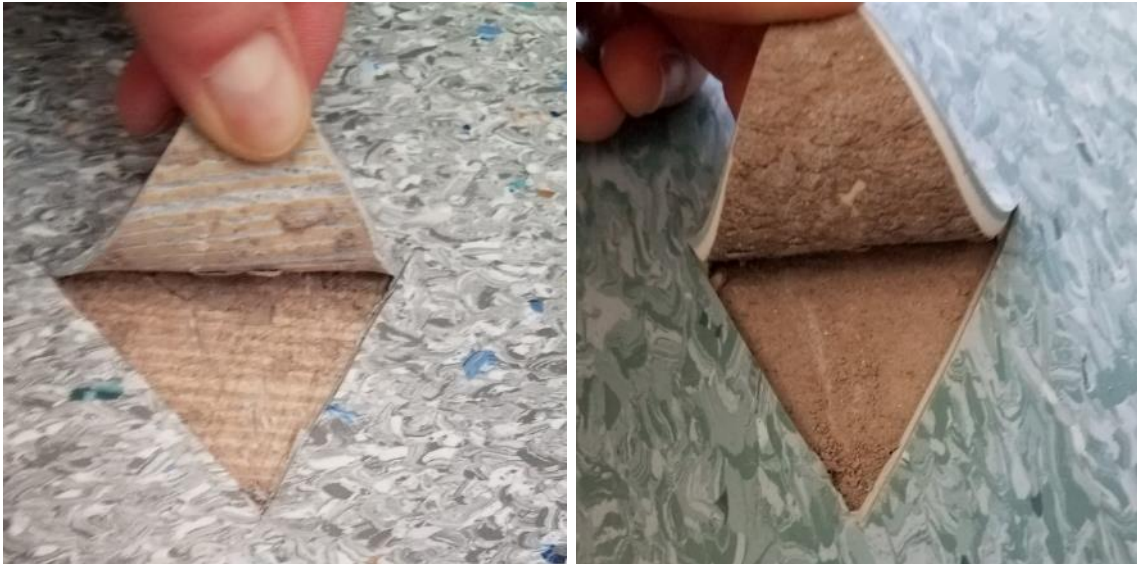
Kuvat 28 ja 29. Liiman kunto maaliskuussa 2019 henkilökunnan taukotilassa (VM1) (vasen kuva) ja Joenjäteissä (VM2) (oikea kuva). Joenjäteissä tasoite on murentunut.
