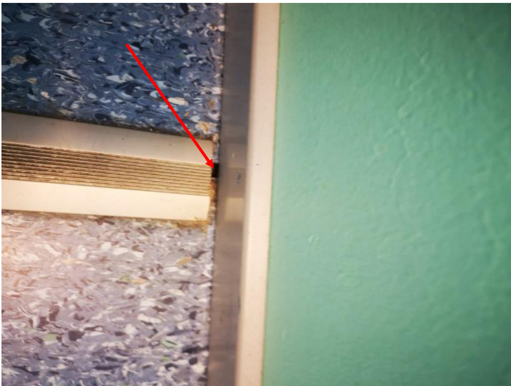
Kuva 20. Lattialaattojen väliset liikuntasaumat ovat saumaamatta elastisella saumamassalla.
