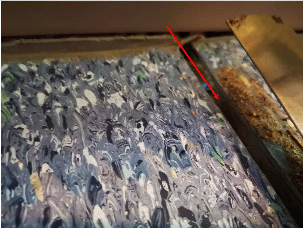
Kuva 19. Lattialaattojen väliset liikuntasaumat ovat saumaamatta elastisella saumamassalla.
