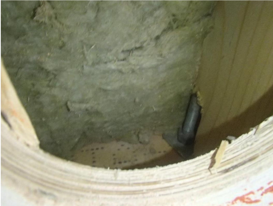
Kuva 7. Rakenneavaus RAK5 luokkahuoneen 4 väliseinärakenteen alaosaan.
