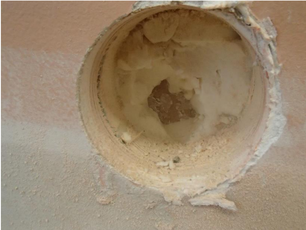
Kuva 4. Rakenneavaus RAK4 luokkahuoneen 4 väliseinärakenteeseen.
