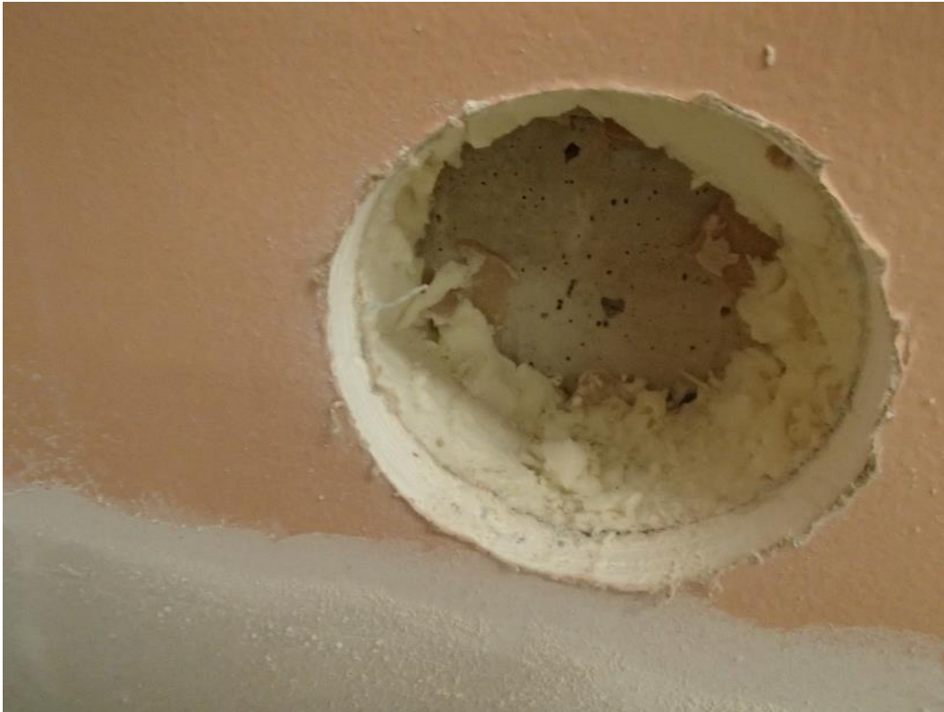
Kuva 2. Rakenneavaus RAK1A luokkahuoneen 4 ulkoseinärakenteeseen (alaosa).
