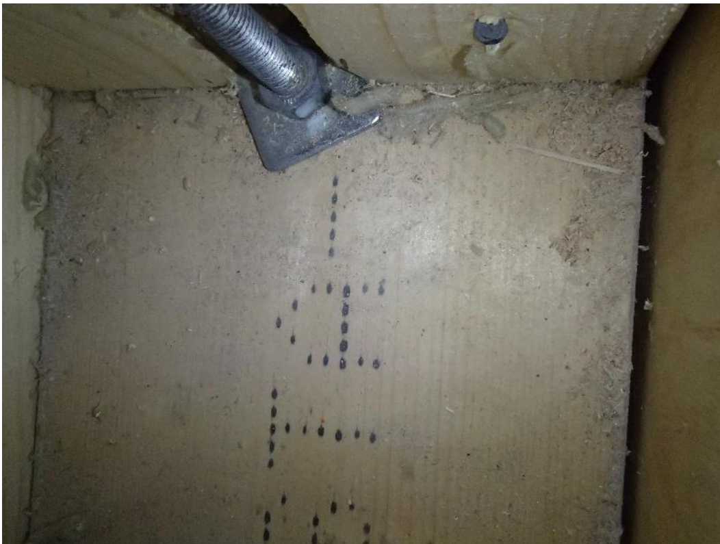
Kuva 8. Rakenneavaus RAK5 luokkahuoneen 4 väliseinärakenteen alaosaan. Rakennusmateriaaleissa ei havaittu vaurioita.
