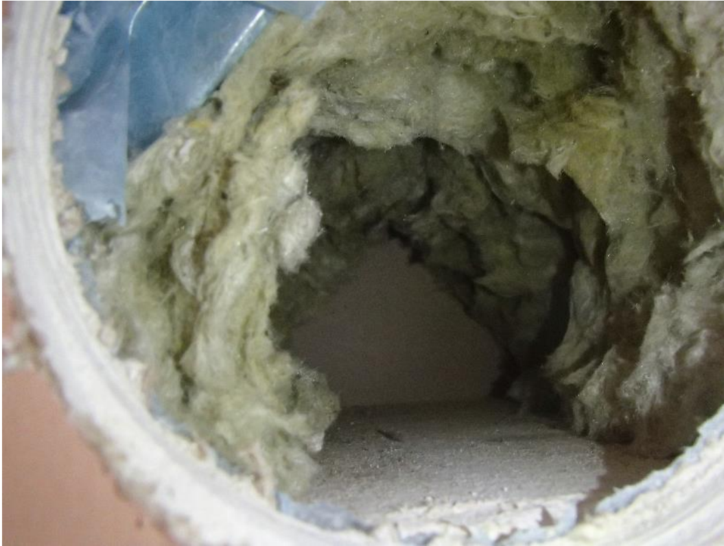
Kuva 5. Rakenneavaus RAK2Y luokkahuoneen 4 ulkovaipparakenteen yläosaan.
