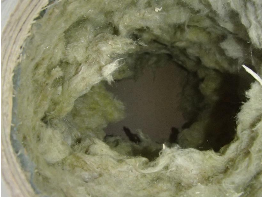
Kuva 6. Rakenneavaus RAK3Y luokkahuoneen 4 väliseinärakenteen yläosaan.
