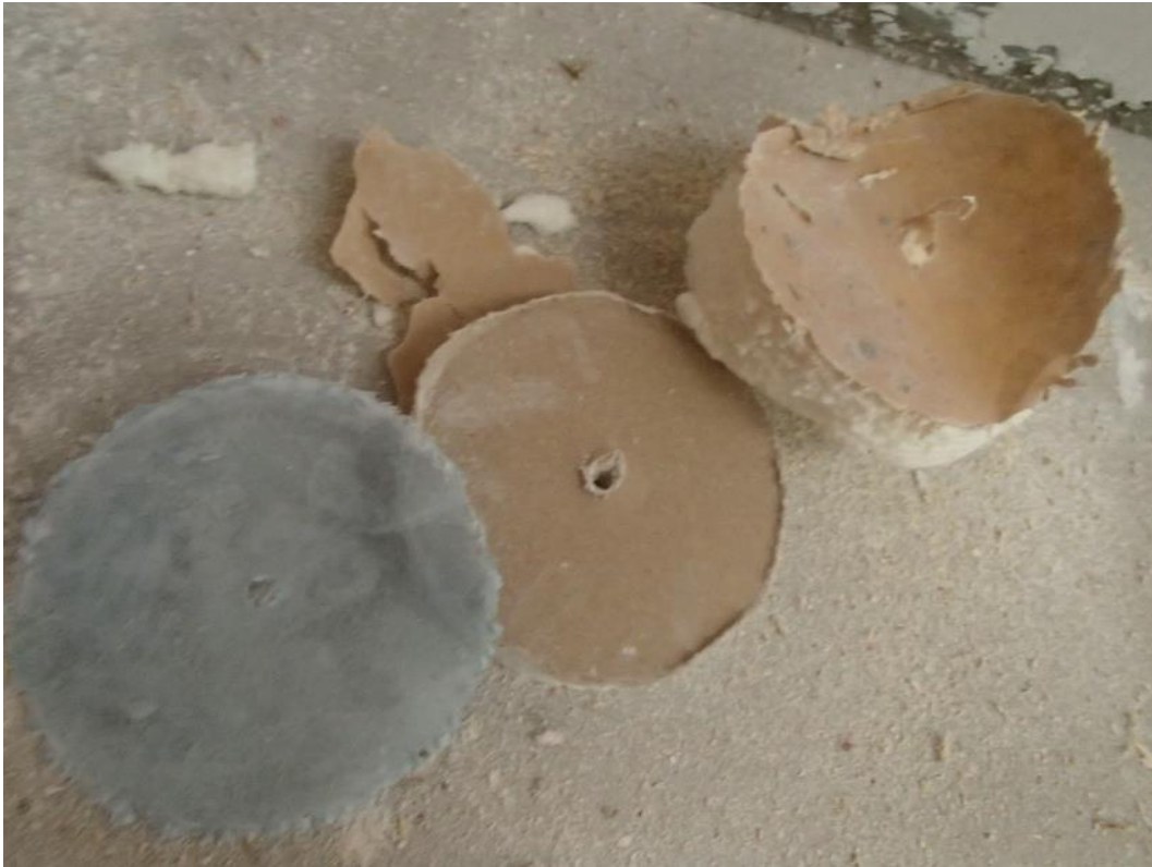
Kuva 3. Luokkahuoneen 4 ulkoseinärakenteen alaosan rakennusmateriaalit.
