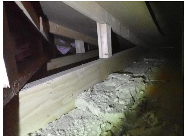
Kuva 17: Yläpohjan levyvillaa, pinnalla ulkoilmasta kantautunutta pölyä.
