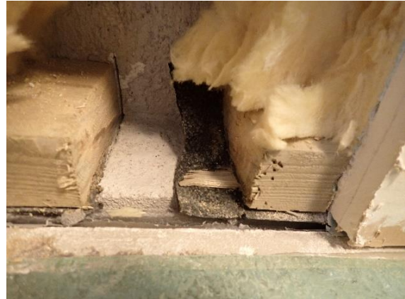
Kuva 13: Ulkoseinän alaosa. Materiaaleissa ei havaittu vaurioon viittaavia jälkiä tai hajuja.
