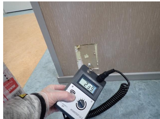
Kuva 7: Käytävän 145 ja wc:n välinen seinä. Seinässä ei ollut kosteuspoikkeamaa.
