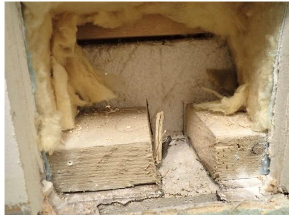
Kuva 9: Ulkoseinän alaosa. Alaohjauspuuna on kestopuuta.
