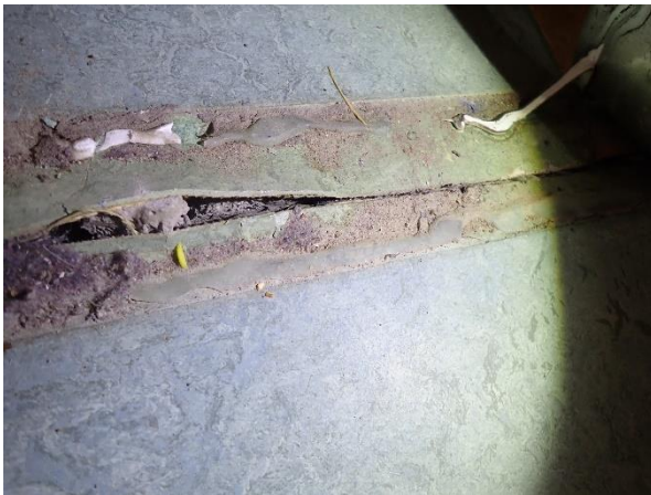
Kuva 5: Liikuntasauvan peitelistan alla pölyä ja likaa.
