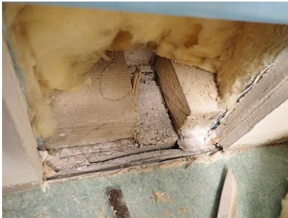
Kuva 8: Ulkoseinän alaosa. Materiaaleissa ei havaittu vauriojälkiä eikä epätavallisia hajuja.
