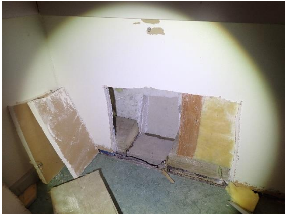
Kuva 12: Ulkoseinän alaosa. Materiaaleissa ei havaittu vaurioon viittaavia jälkiä tai hajuja.
