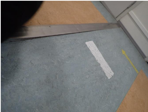
Kuva 3: Käytävän lattiasauman alue, jossa on liikuntasauva.
