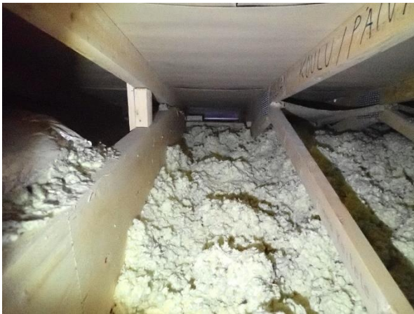
Kuva 16: Yläpohjan puhallusvillaa.
