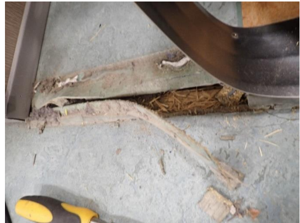
Kuva 4: Lattian liikuntasauvan puulevystä otettiin näyte mikrobitutkimukseen.
