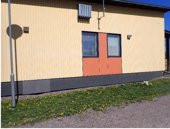
Kuva 8: Ryömintätila tuuletuu sokkelilevyjen alaosasta.
