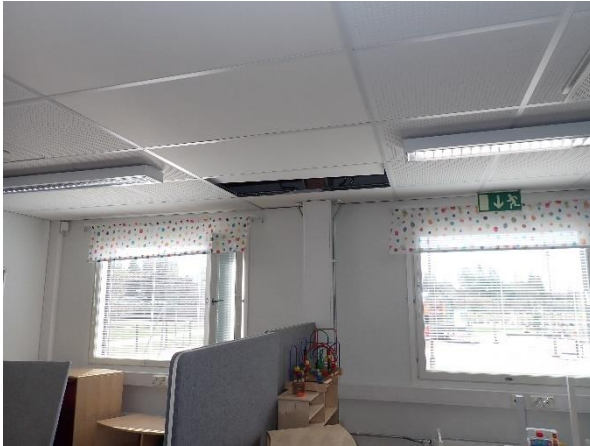
Kuva 19: Ulkoseinien sisäpinnat ovat maalattua kipsilevyä.
