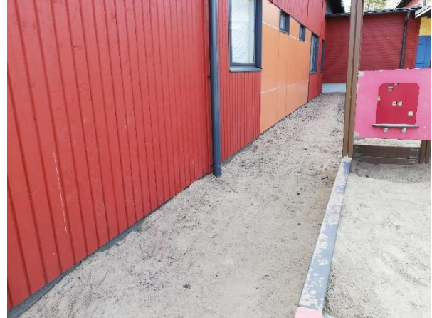
Kuva 9: Paikoin sisäpihalla alapohjan ryömintätilan tuulettuminen on puutteellinen.
