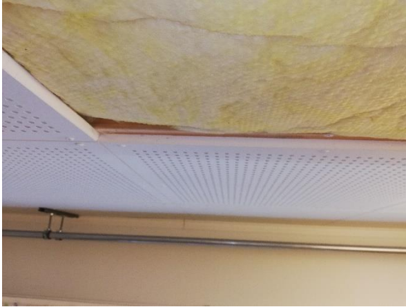
Kuva 34: Katon alaslaskulevyn yläpuolella avoimia villapintoja. Kattolevy on kiinnitetty ruuveilla.
