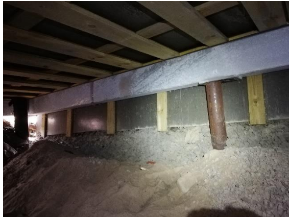
Kuva 12: Tuulettuvan alapohjan ryömintätilaa, ei havaittu kosteusvaurioita.
