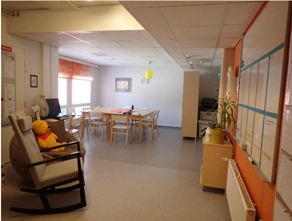
Kuva 38: Uuden ja vanhan rakennuksen rajakohta taukotilassa 109.
