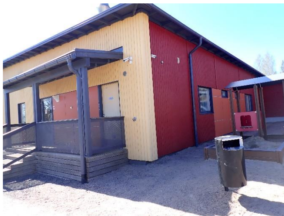
Kuva 3: Sadevedet ohjataan syöksykouruihin sadevesijärjestelmään.
