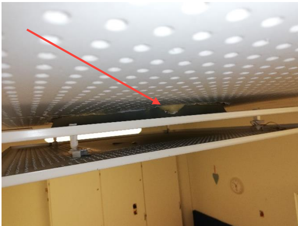
Kuva 36: Kattolevyjen saumoissa näkyvissä mineraalivillaa.
