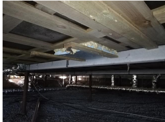
Kuva 13: Tuulettuvan alapohjan ryömintätilaa, ei havaittu kosteusvaurioita.
