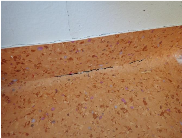
Kuva 5: Tila 119, lattian ja seinän rajakohdassa muovimatto repeytynyt.
