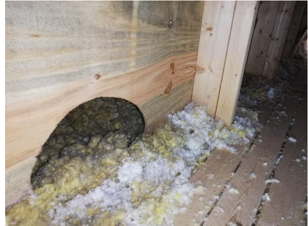
Kuva 25: Yläpohjan matalille osille tehty aukkoja parantamaan tuuletusta.
