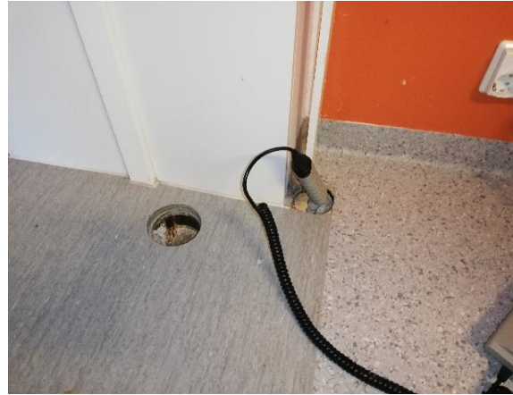
Kuva 11: Uuden ja vanha puolen rajakohdan tarkastus.
