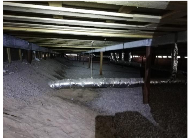
Kuva 6: Ryömintätila oli pääosin siisti.
