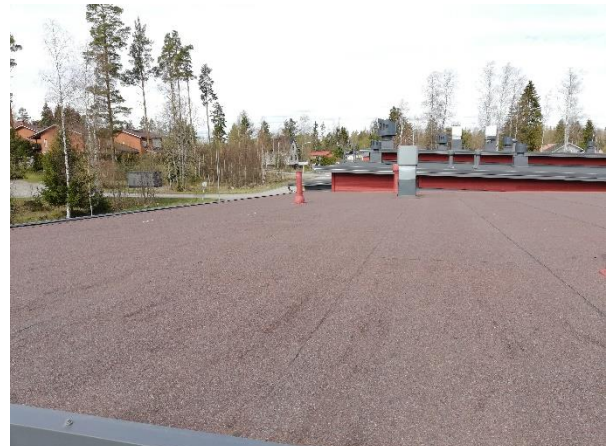
Kuva 27: Kumibitumikermi on hyväkuntoinen.
