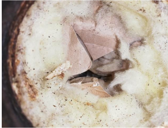
Kuva 10: Tila 134, alapohjan avaus, eristeessä ei vauriojälkiä eikä hajuja.
