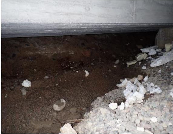
Kuva 1. Koulurakennuksen ryömintätilasta on ilmayhteys päiväkodin puolelle.
