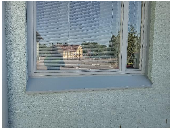
Kuva 4. Ulkopuolisesti ikkunaliittymissä ei havaittu merkittäviä epätiivelyskohtia. Muurauksessa joka 3.sauma jätetty auki tuuletusaukoiksi.
