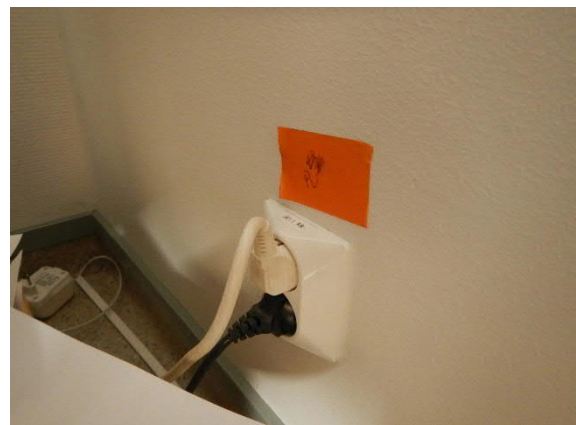
Kuva 22. Pistemäistä vuotoa pistorasian kautta (5).
