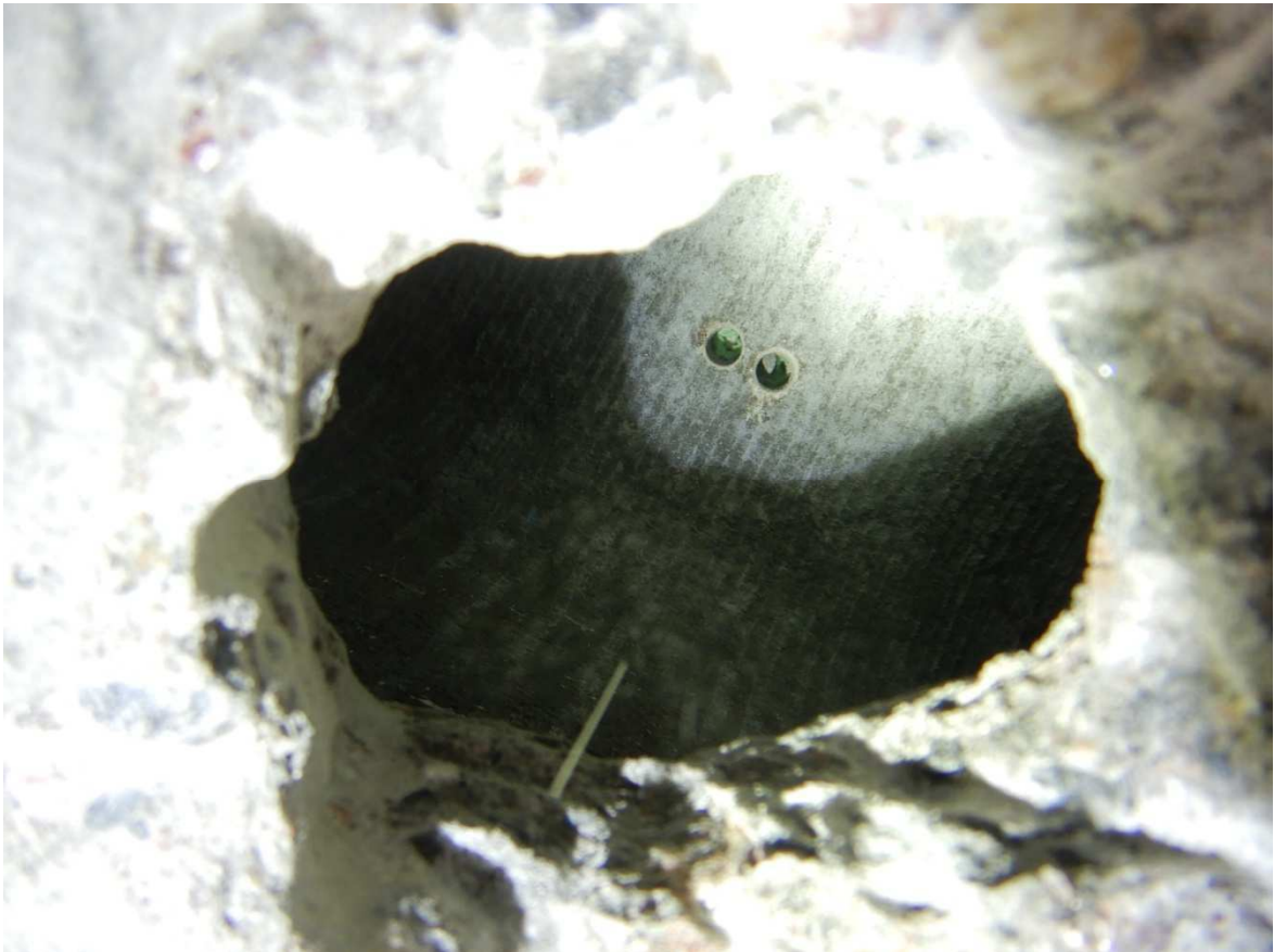
Kuva 1. Kuva on alapuolelta ryömintätilasta ontelolaatan alta onkaloon poratusta aukosta ja eristetilaan poratuista rei'istä. Lämmöneriste näkyy kuvassa vihertävänä.
