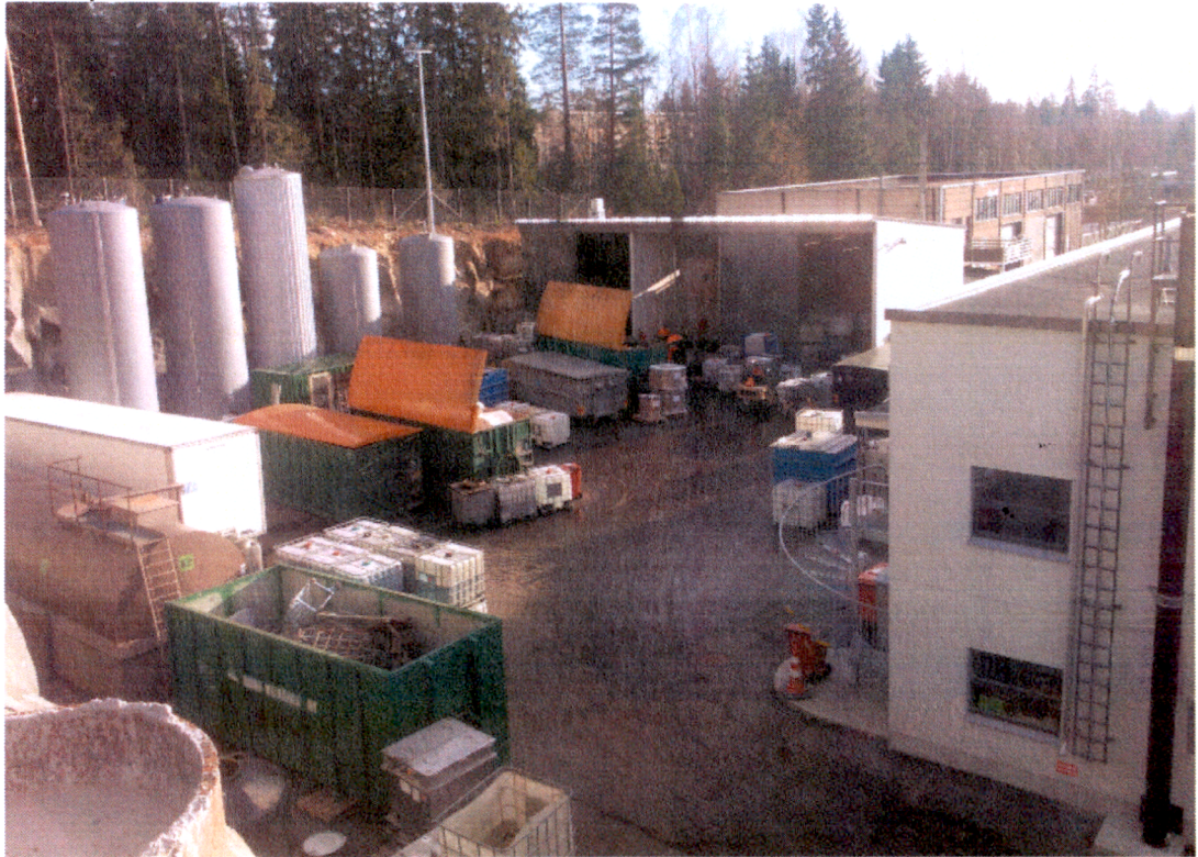
Kuva 7.3. Takapiha, käsittelyhalli oikealla ja nestemäisten jätteiden varastosäiliöt vasemmalla.
