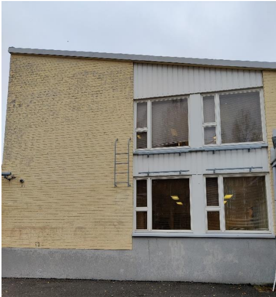
Kuvat 1. Luokan 38 kohdalla oleva päätyseinä.
