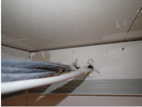
Kuva 2. Huonetilan 117 kohdalla kulkee sähköläpivientejä.
