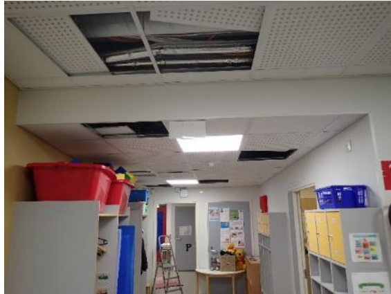
Kuva 12. Alaslasketun katon yläpuolella ei havaittu mahdollisia vuotojälkiä.
