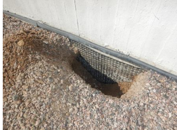
Kuva 13. Itäjäulkisivulla sokkelin ulkopinnassa pato-levy.
