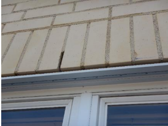
Kuva 38. Ikkunoiden yläpuolen pellityksen päällä rako.
