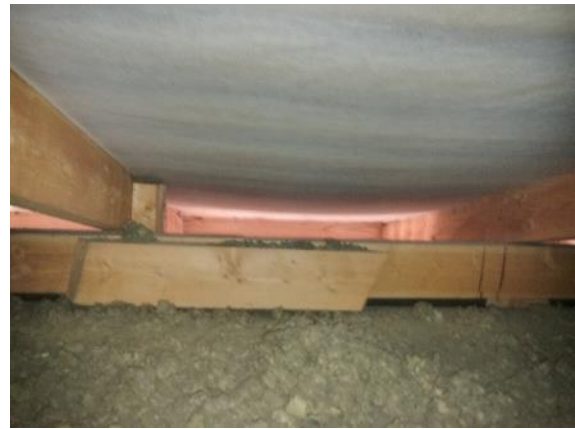
Kuva 72. Räystäällä havaittiin tuuletusraot. Ulkoseinän vierelle on asennettu kova levyvilla.
