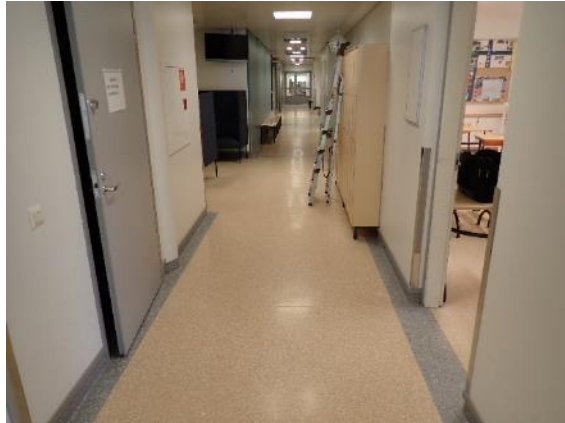
Kuva 25. Muovimattopinnoite.
