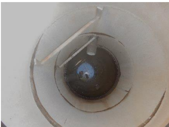
Kuva 14. Kuva kaivon sisältä. Vettä kaivon pohjalla.
