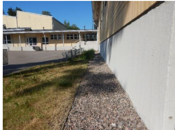
Kuva 3. Etelä-, itä- ja pohjoisjulkisivuilla sepelikaista sokkelin vieressä.
