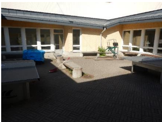
Kuva 8. Sisäpihan pinta kallistaa keskellä olevalle kaivolle.
