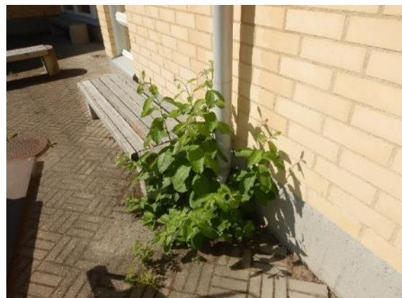
Kuva 9. sisäpihan syöksytorvien alla viherkasvustoja.
