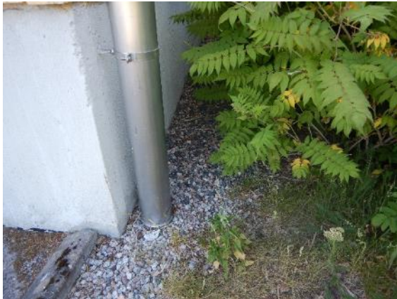
Kuva 6. Syöksytorvet jatkuvat maan pinnan alle.
