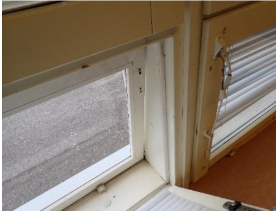
Kuva 42. Aukipitolaite ruuvattu irti.
