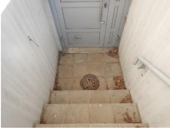
Kuva 10. Kaivo kellarin ulkoportaan alapäässä.
