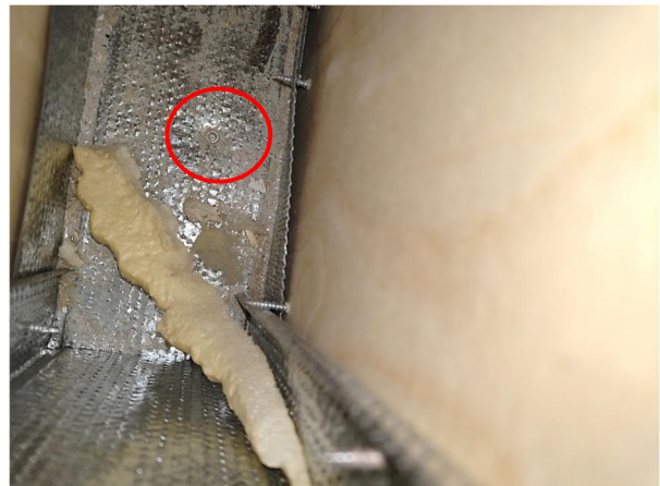
Kuva 6. Metallinen alajuoksu on kiinnitetty betoni- nauloilla.
