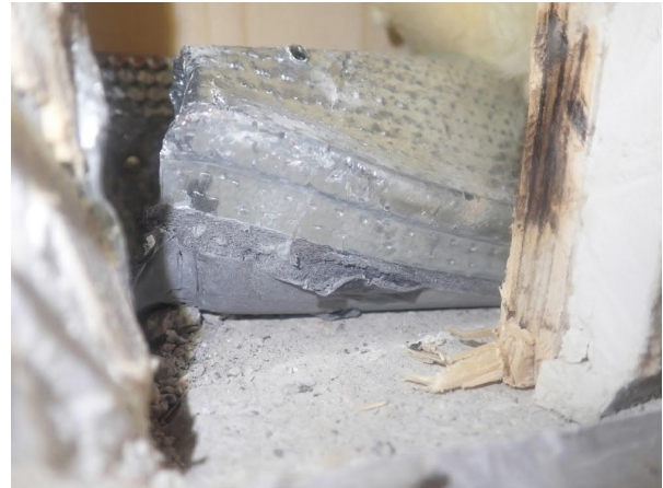
Kuva 4. Väliseinärunko on toteutettu metallirankajärjestelmällä ja erotettu alapohjalaatasta solumuovikaistalla.
