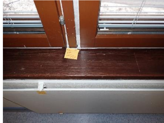
Kuva 5. Pistemäistä ilmavuotoa ikkunakarmin välisessä liittymässä. Pistemäistä ilmavuotoa patterinkannakkeessa. Kummatkin ilmavuodot havaittu normaalitilassa.
