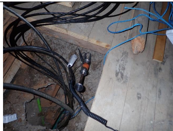
Kuva 1 Alapohjan turvepehkon kosteusmittauksia
