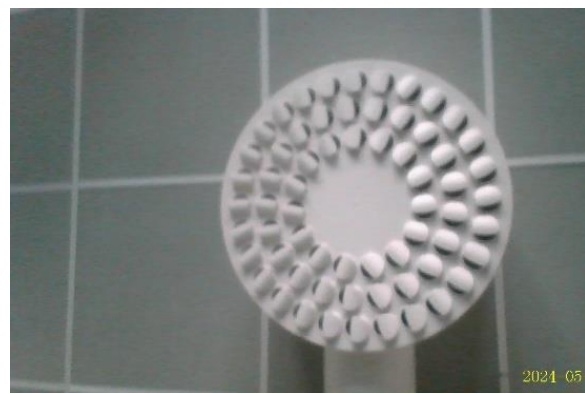
Kuva 14 Uudemmissa pyöreissä kattohajottajissa ei ole mineraalikuitulähteitä (tila 9).
