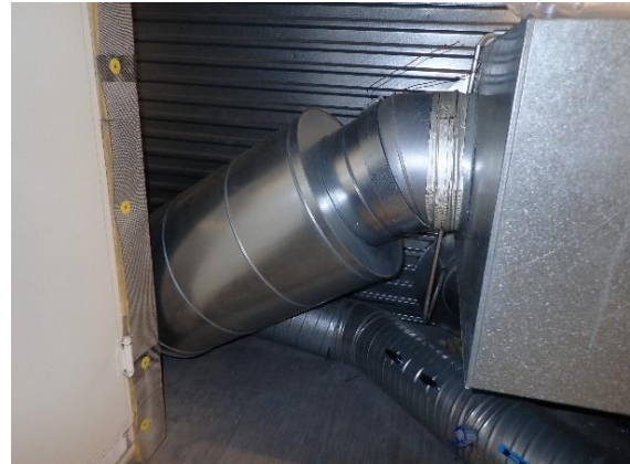
Kuva 5: IV-konehuoneen äänenvaimentimet uusittu.
