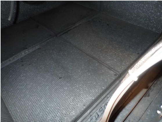
Kuva 4: Puhallinkammiossa reikäpeltilevyä, jonka mineraalivillaaeristettä.
