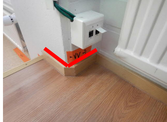
Kuva 8. Vähäistä vuotoa näyttämön ja pilarin vaakaliittymästä (2). Vuotolähde näyttämörakenteen alla.
