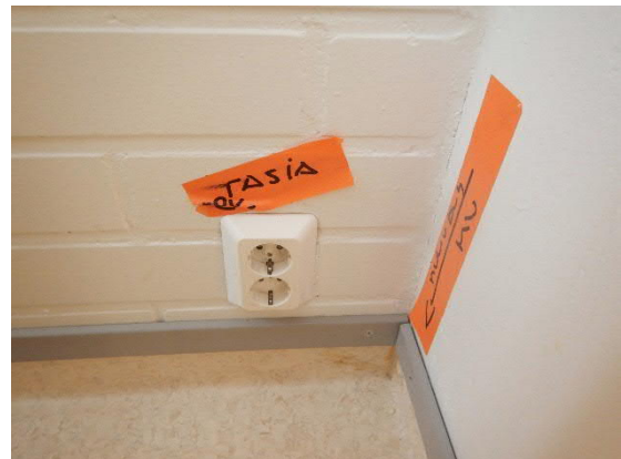
Kuva 17. Pistemäistä vuotoa pistorasian kautta (6).
