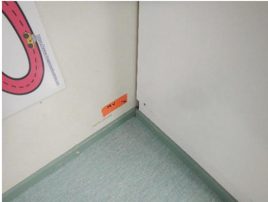
Kuva 19. Merkittävä vuoto raosta kiinteän kaapiston takaa. Vuoto ulkoseinän ja lattian liittymästä, mahdollisesti koko kaapiston pituudelta (3).
