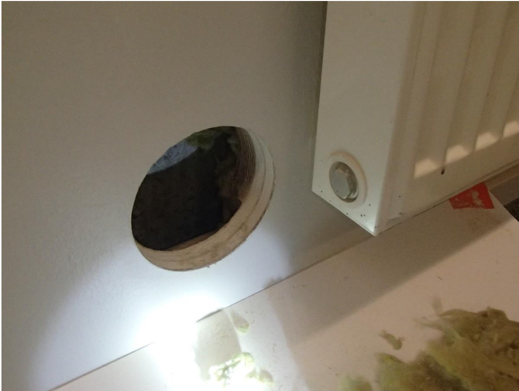
Kuva 7. Rakenneavaus musiikkiluokan sisäseinään.
