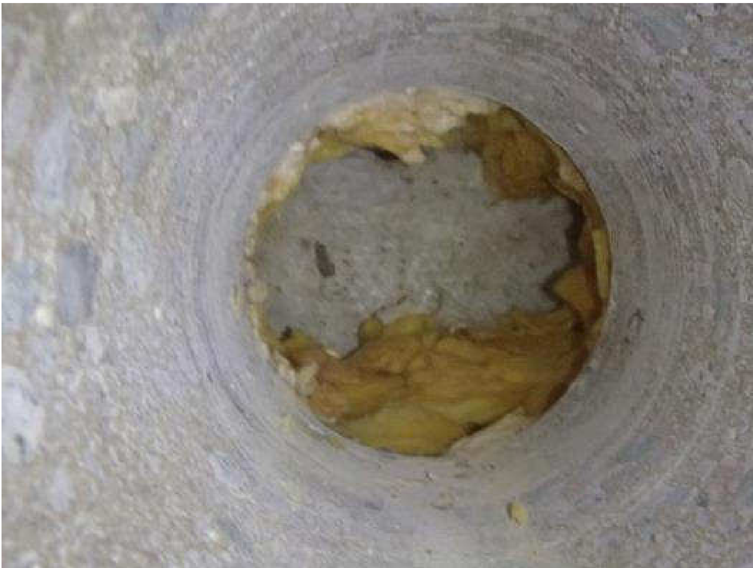
Kuva 95. Rakenneavaus, MVS2, musiikkiluokan maanvastaiseen seinään sisältäpäin.
