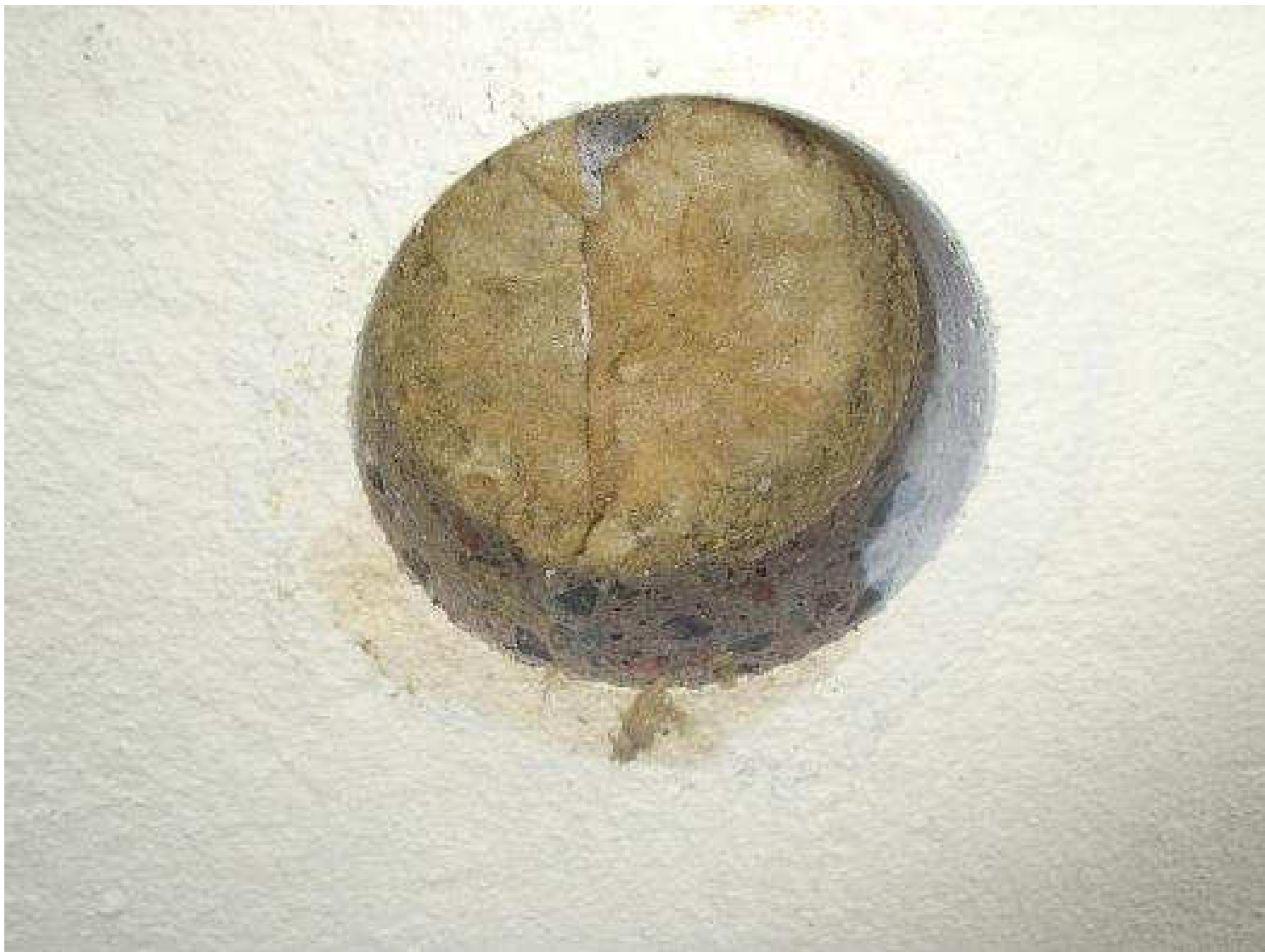
Kuva 81. Rakenneavaus, JS19A, julkisivuun.
