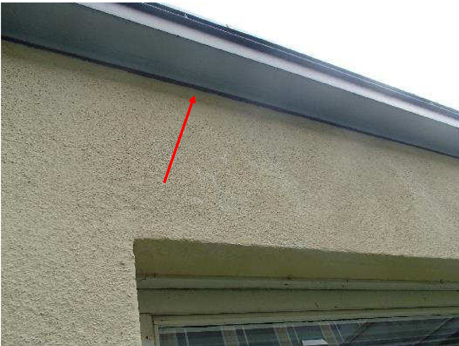
Kuva 109. Julkisivujen ja räystäiden välissä ei havaittu vastapellityksiä.
