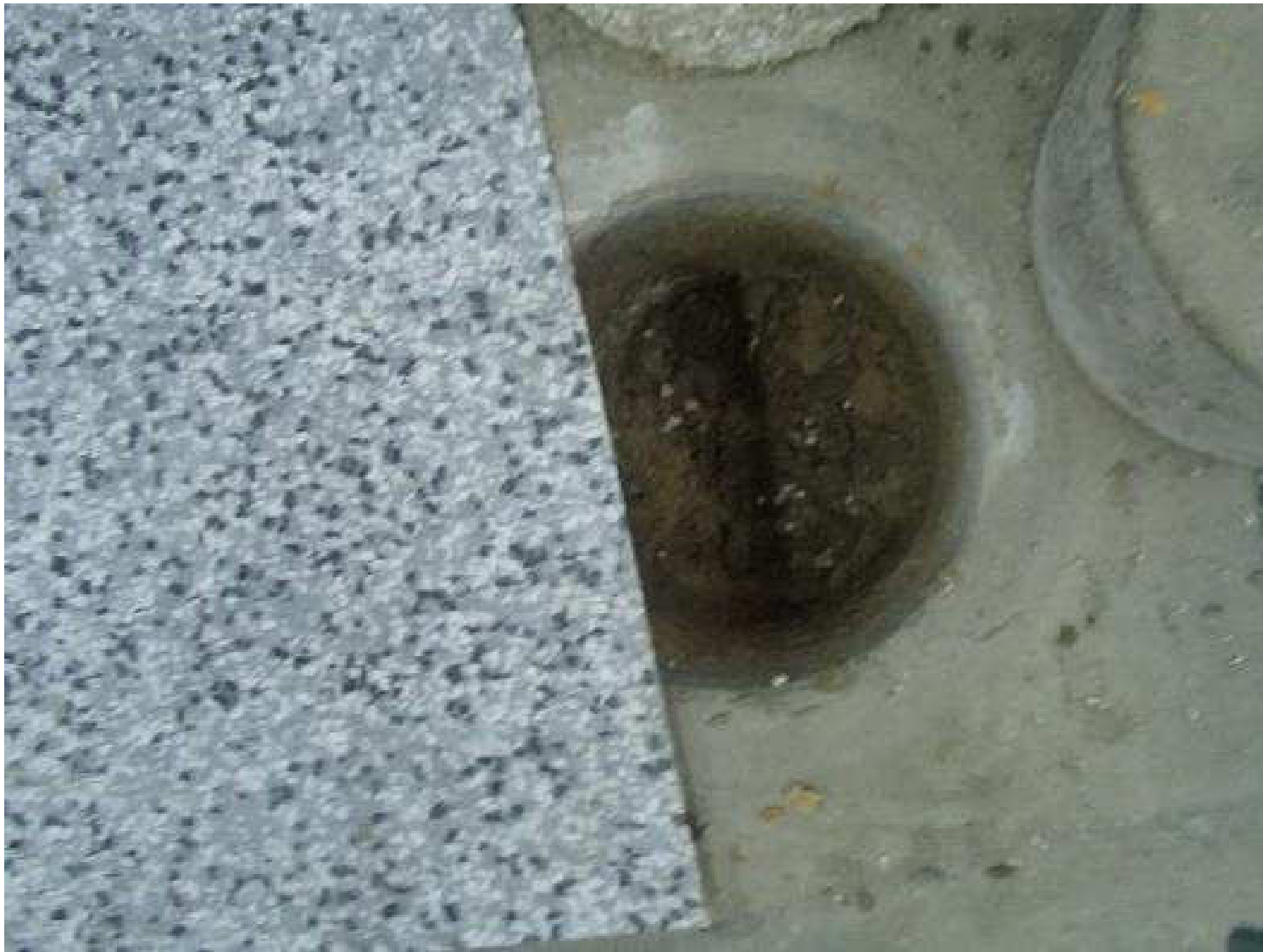
Kuva 84. Rakenneavaus, RAKL18, luokkahuoneen 24 alapohjarakenteeseen.
