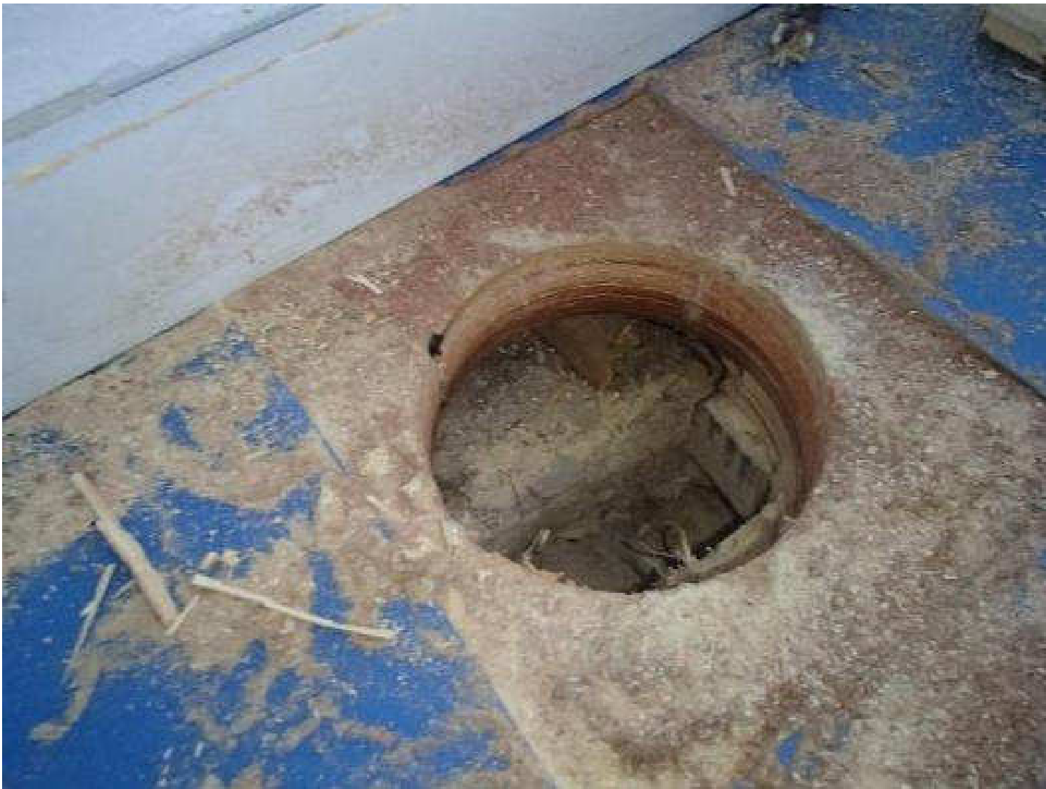
Kuva 25. Rakenneavauskohta, VP2, liikuntasalin välipohjarakenteeseen.
