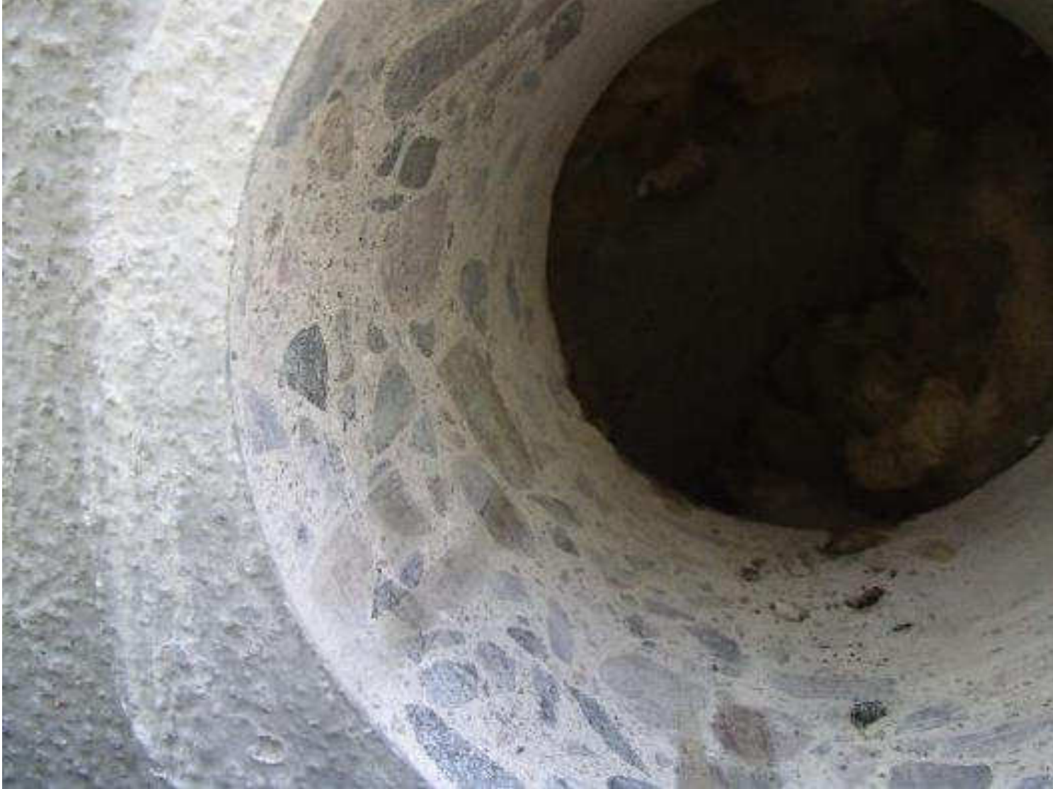
Kuva 50. Rakenneavaus, JS4A, betonisokkeliin.
