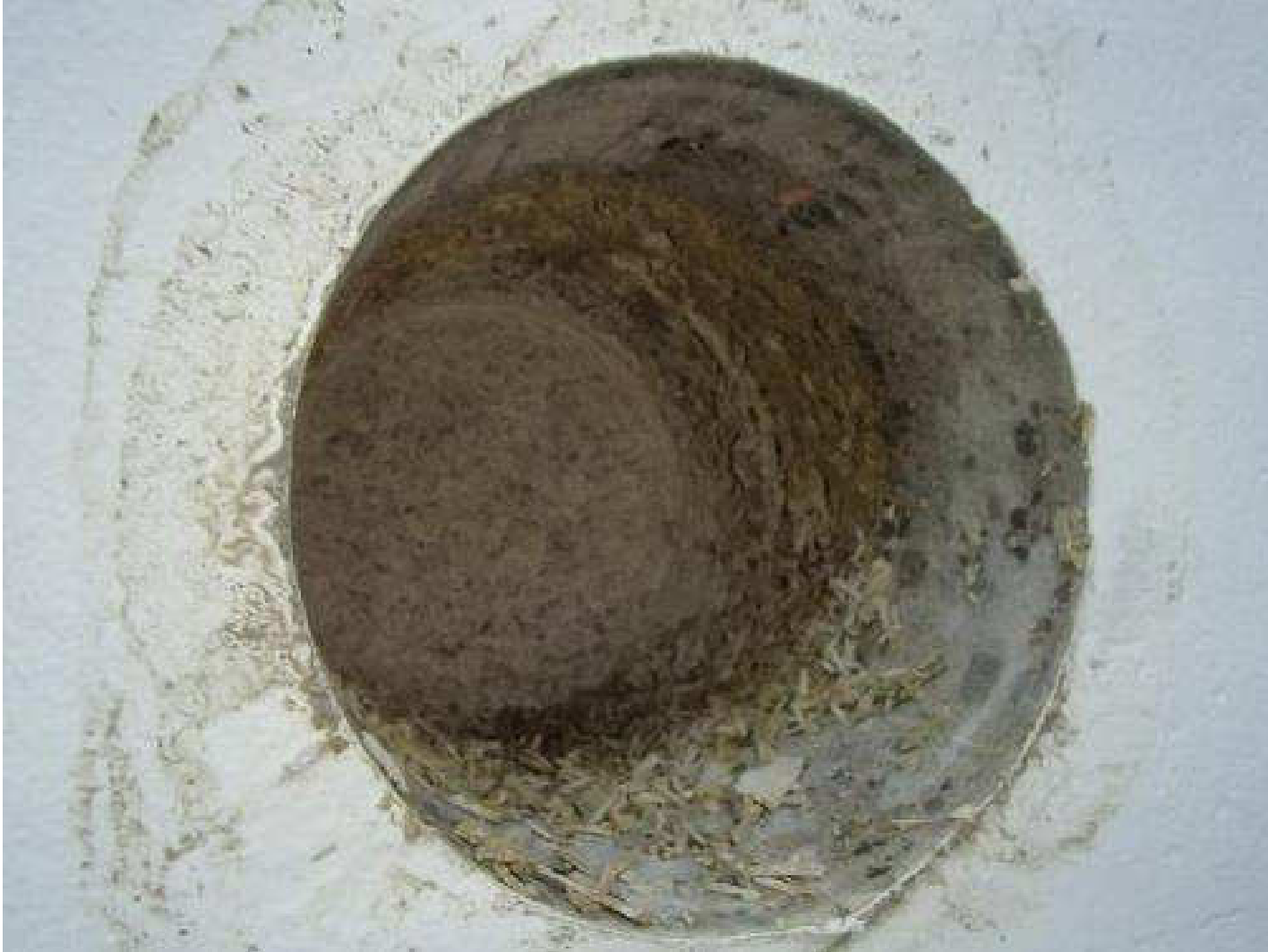
Kuva 85. Rakennearaus, VJS1, luokkahuoneen 24 maanvastaiseen seinään (vanha sokkeli).
