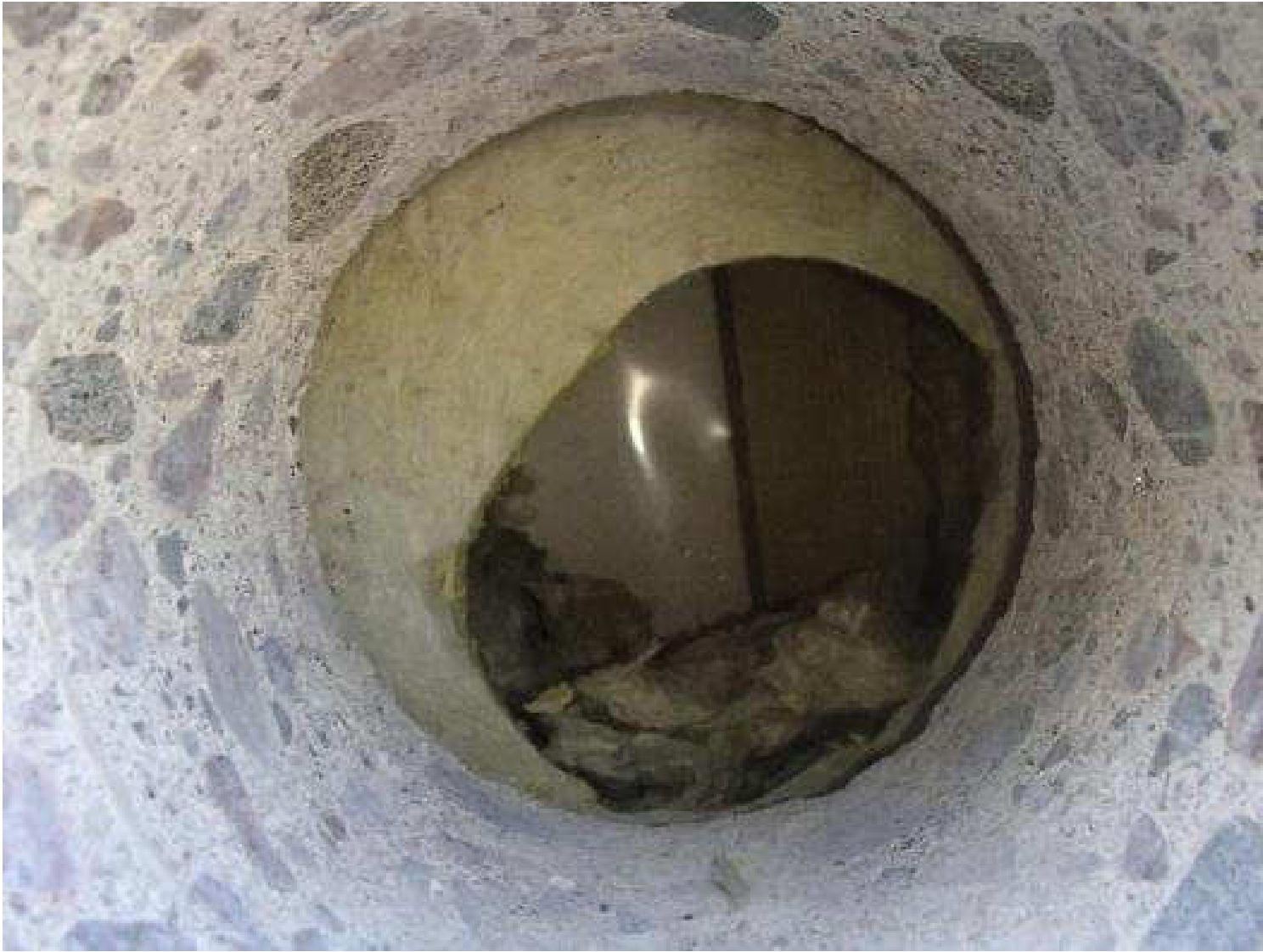
Kuva 6. Rakenneavaus, JS7, ulkovaipparakenteiden sokkeliin.
