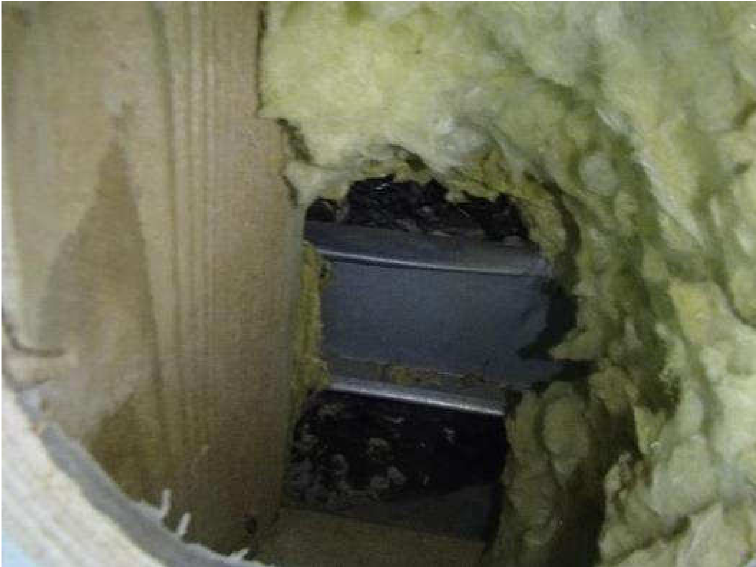
Kuva 60. Rakenneavauskohta, RAKS 5, luokkahuoneen 5 ulkovaipparakenteeseen sisäkautta.
