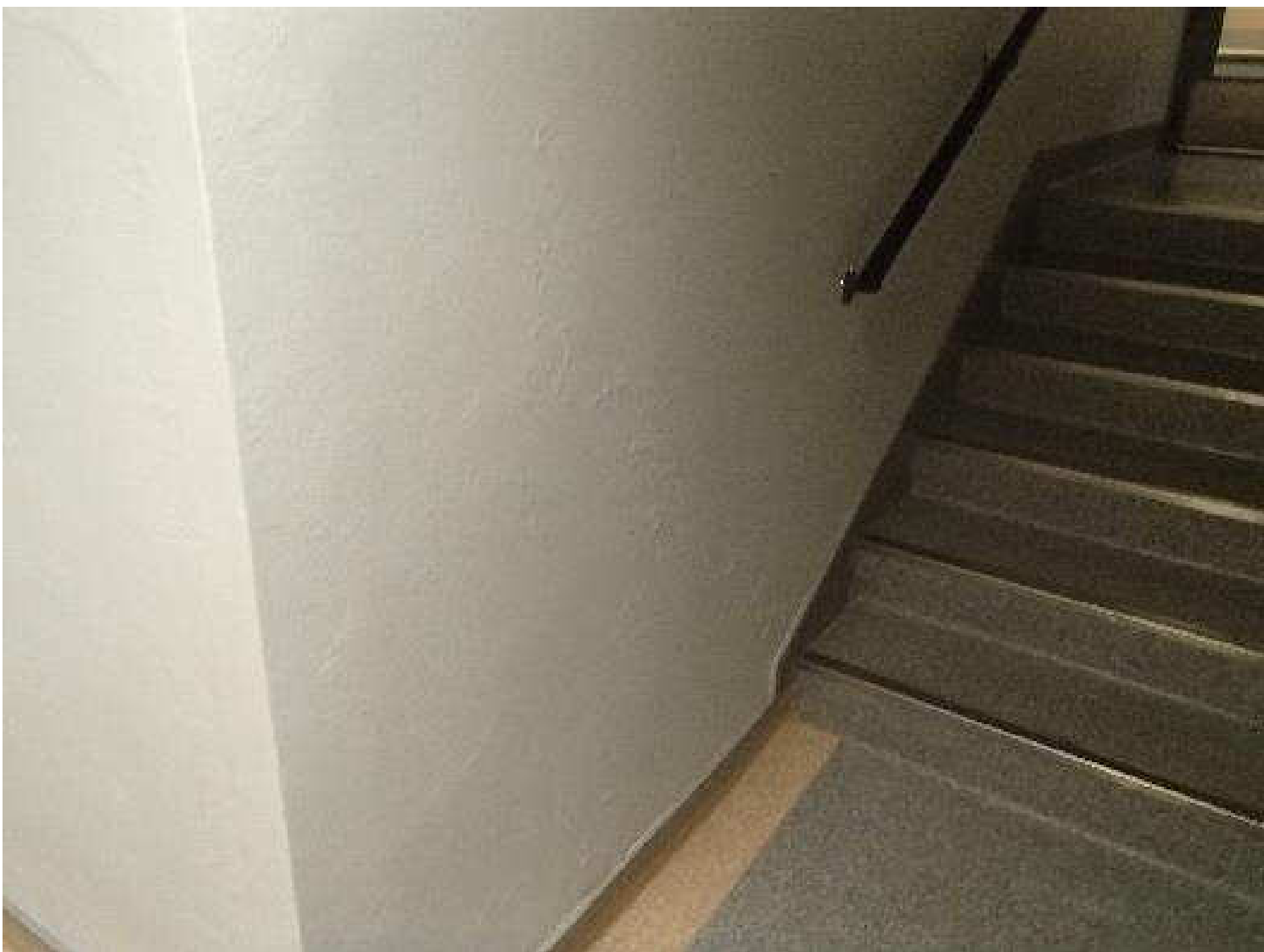
Kuva 168. Kellarikerroksen maanvastaisessa seinässä havaittiin kosteuden aiheuttamia vaurioita maali ja tasoitepinnoissa.
