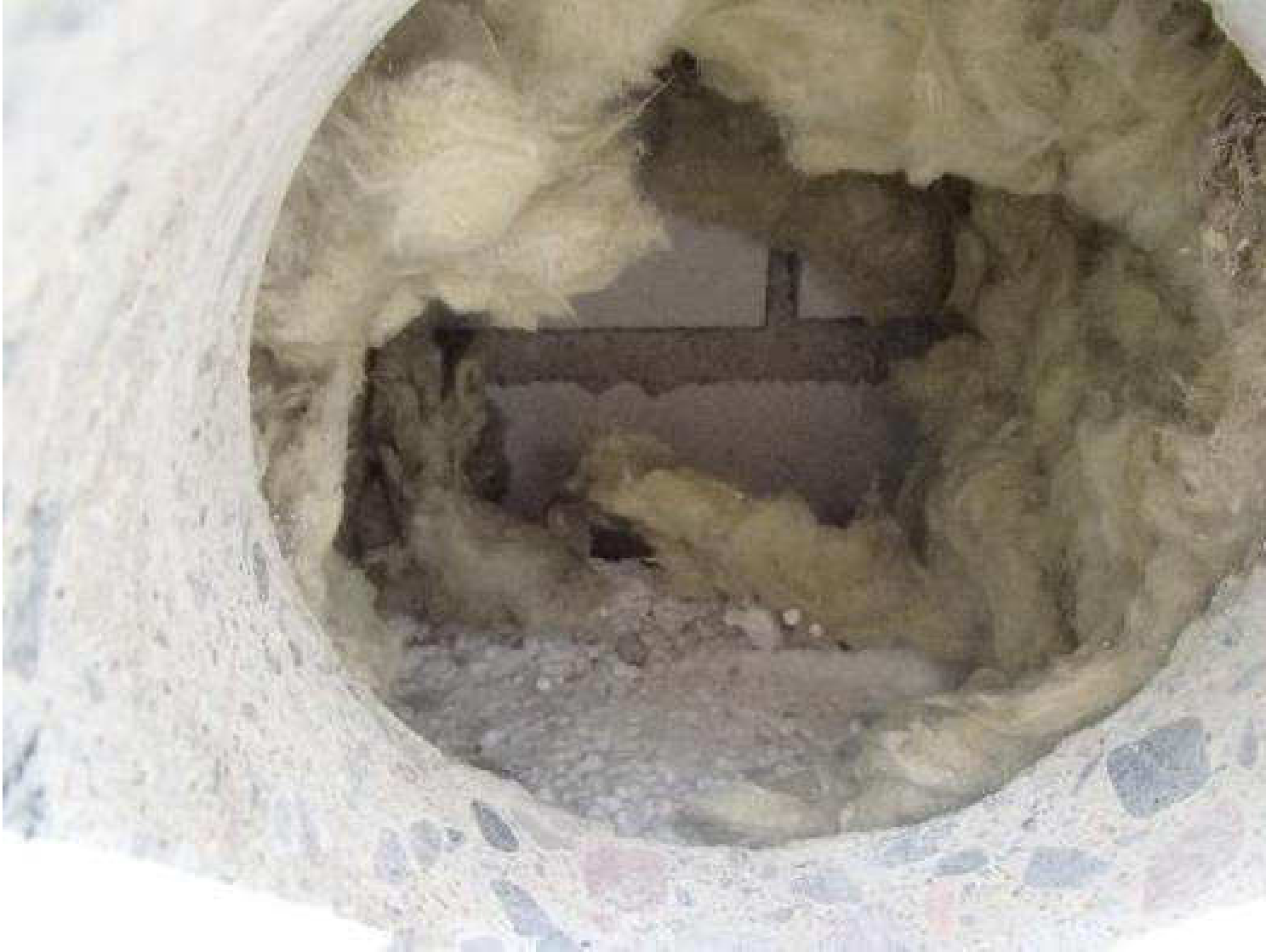
Kuva 93. Rakenneavaus, JS18, tiilimuurattuun julkisivuun.
