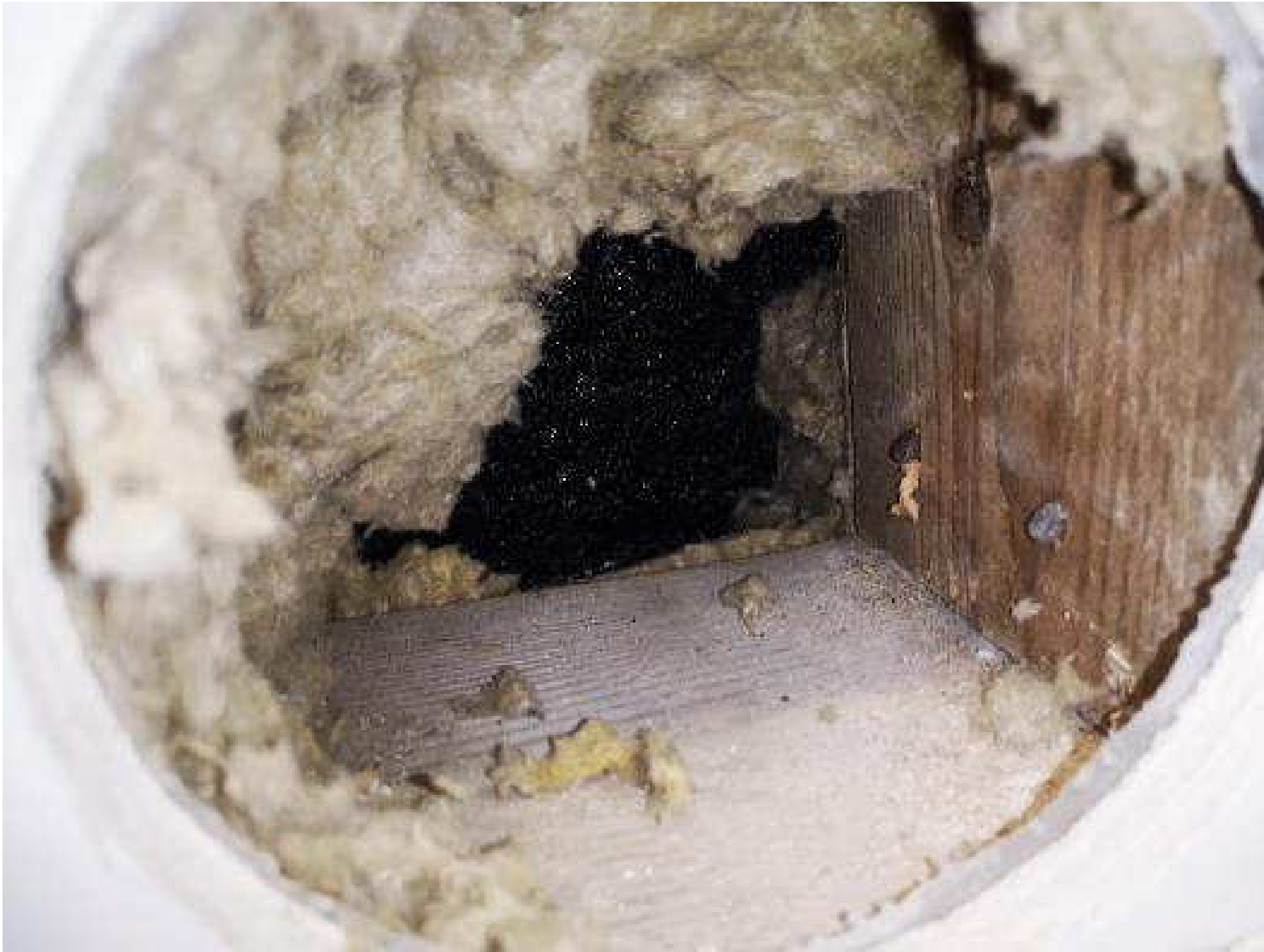
Kuva 18. Rakenneavauskohta, RAKS 11, sisäkautta luokan 20 ulkovaipparakenteeseen.
