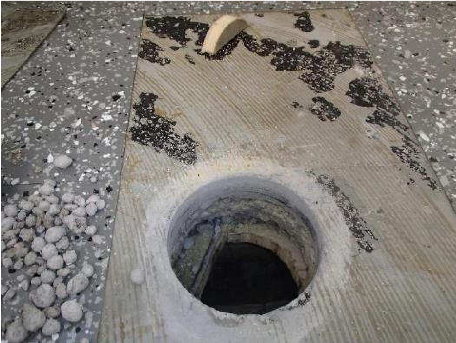
Kuva 35. Rakenneavaus, RAKL17, luokkahuoneen 21 alapohjarakenteeseen putkikanaalin kohdalta.
