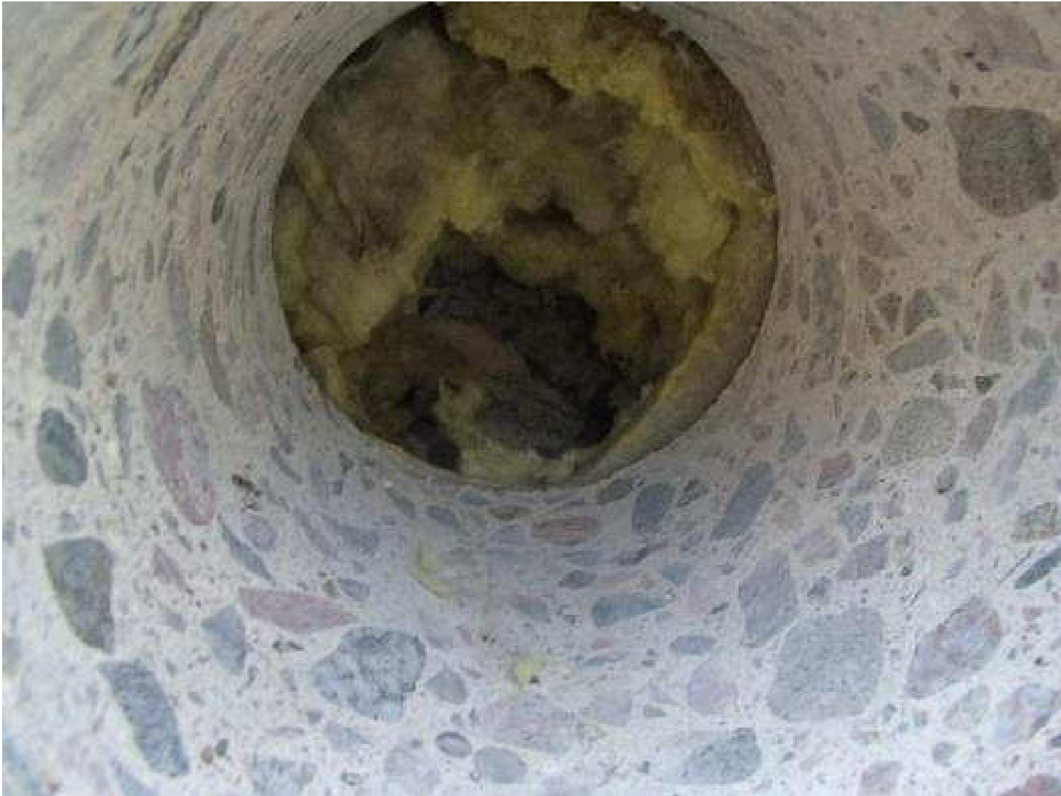
Kuva 47. Rakenneavaus, JS3, betonisokkeliin.
