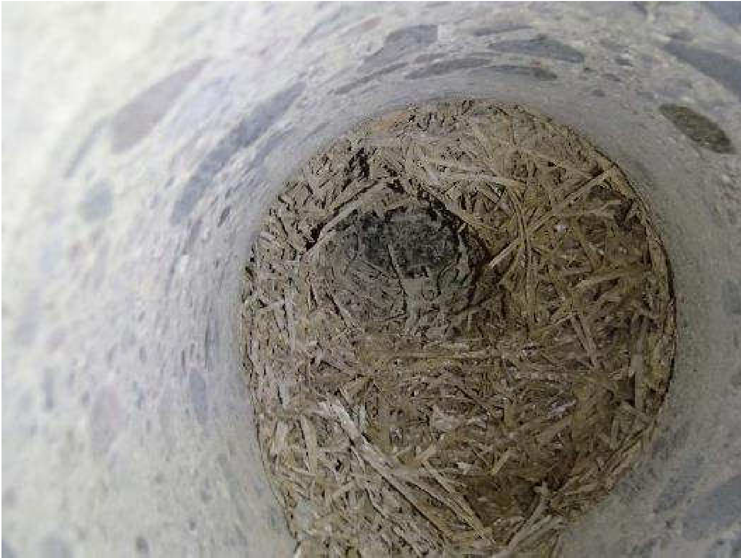
Kuva 21. Rakenneavauskohta, MVS3, sisäkautta luokan 30 ulkovaipparakenteeseen.
