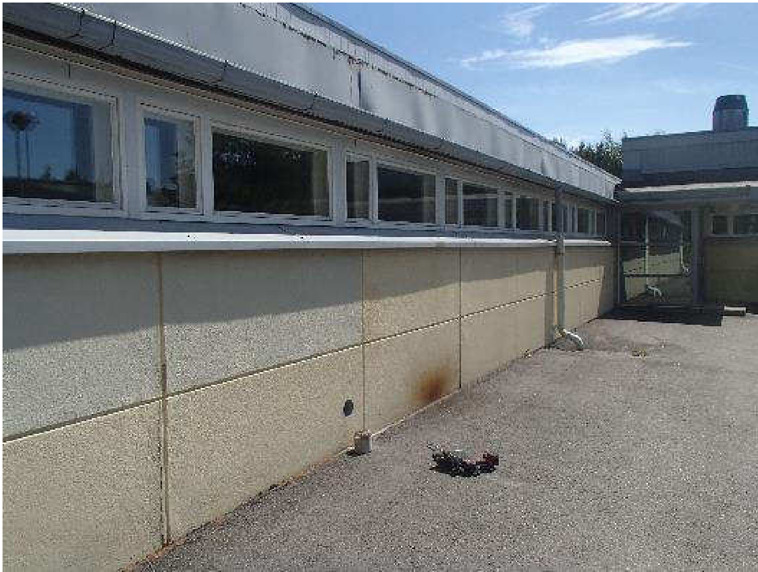
Kuva 124. Sokkelit ovat paikoin matalat.
