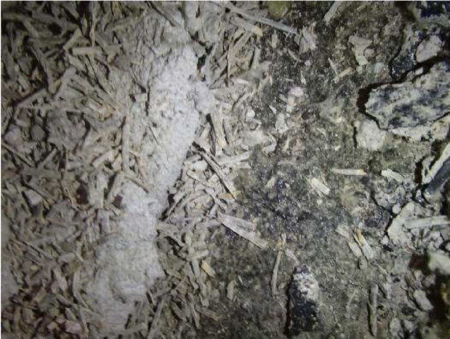
Kuva 15. Rakenneavauskohta, JS15A. Eristehalkaisun päällä on bitumisively.
