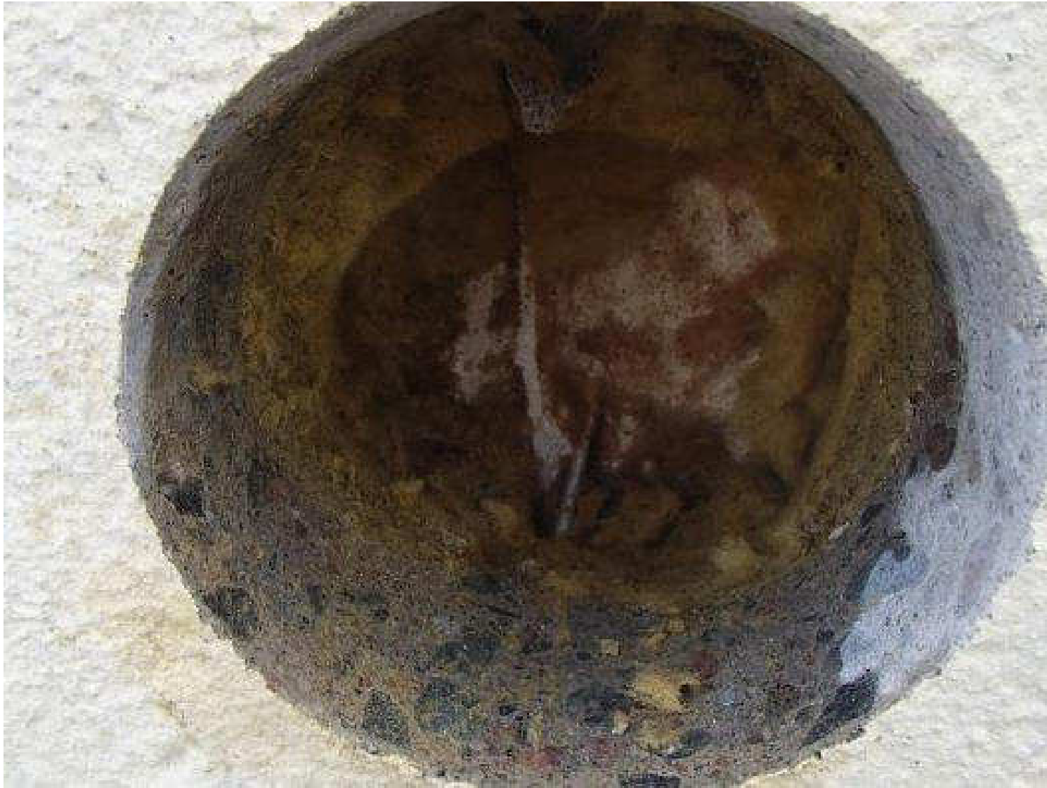
Kuva 82. Rakenneavaus, JS20, julkisivuun.
