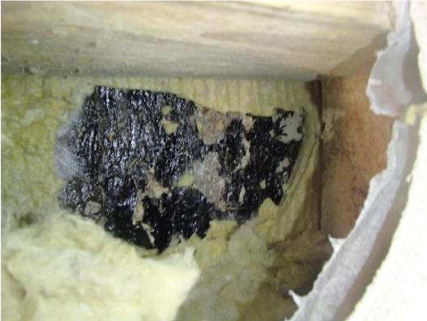
Kuva 62. Rakenneavauskohta, RAKS7, luokkahuoneen 1 ulkovaipparakenteeseen sisäkautta.
