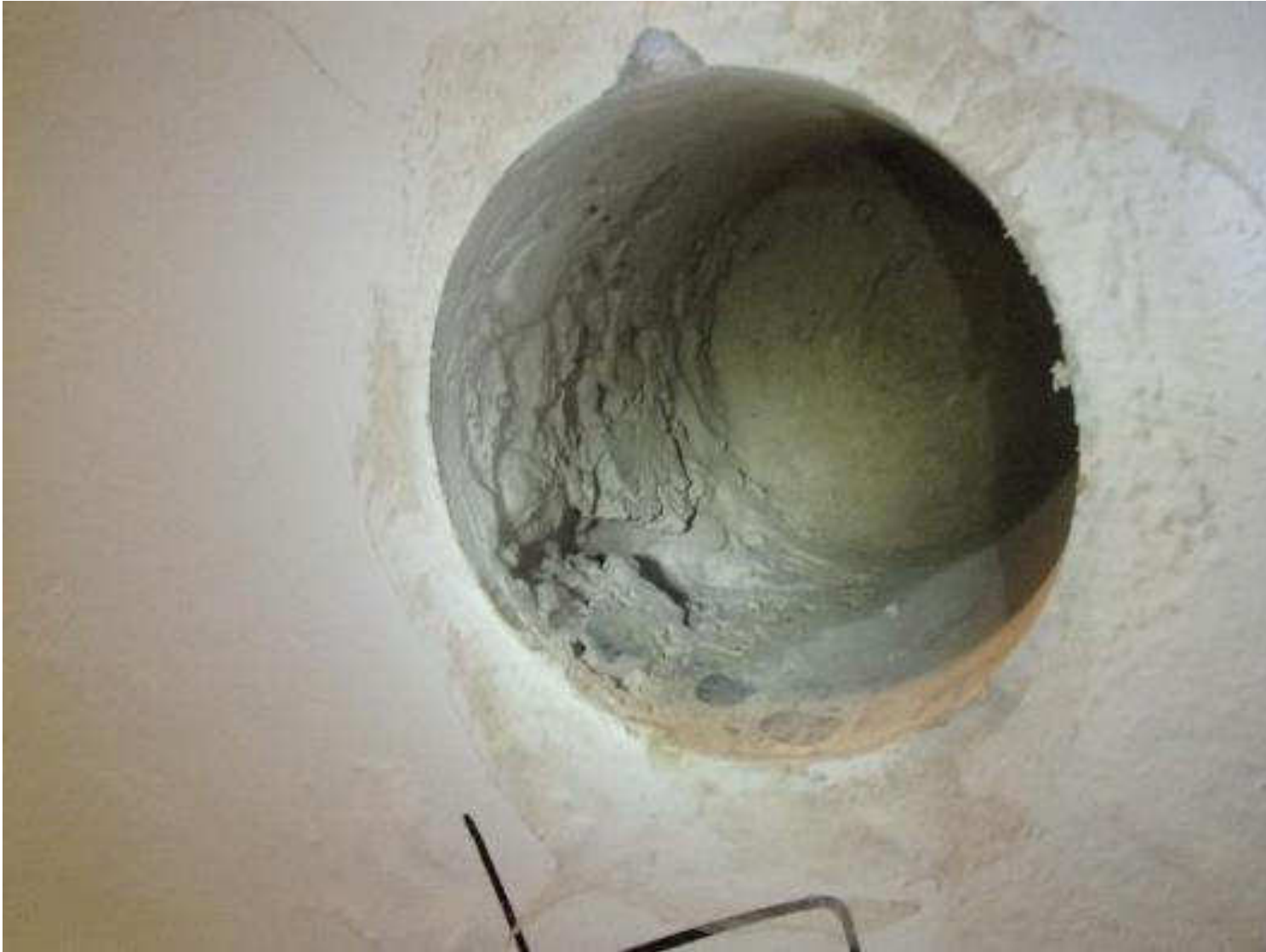
Kuva 97. Rakenneavaus, MVS1, yhdyskäytävän maanvastaiseen seinään.
