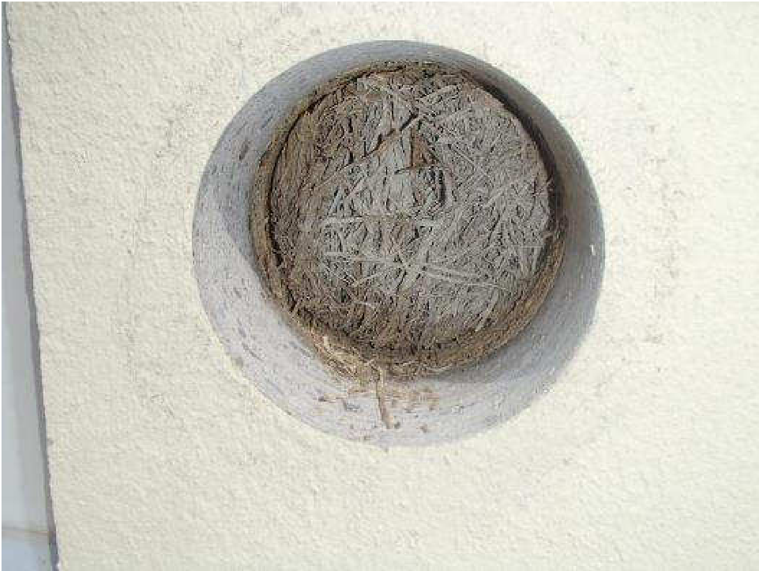
Kuva 10. Rakenneavauskohta, JS22Y, julkisivuun.
