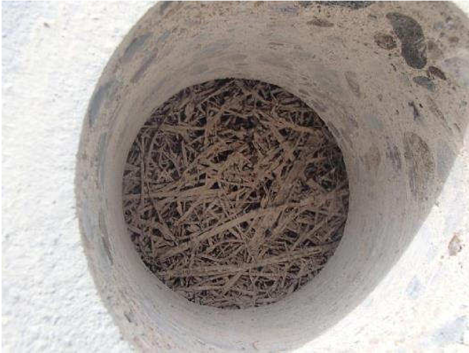
Kuva 9. Rakenneavauskohta, JS12A, sokkeliin.
