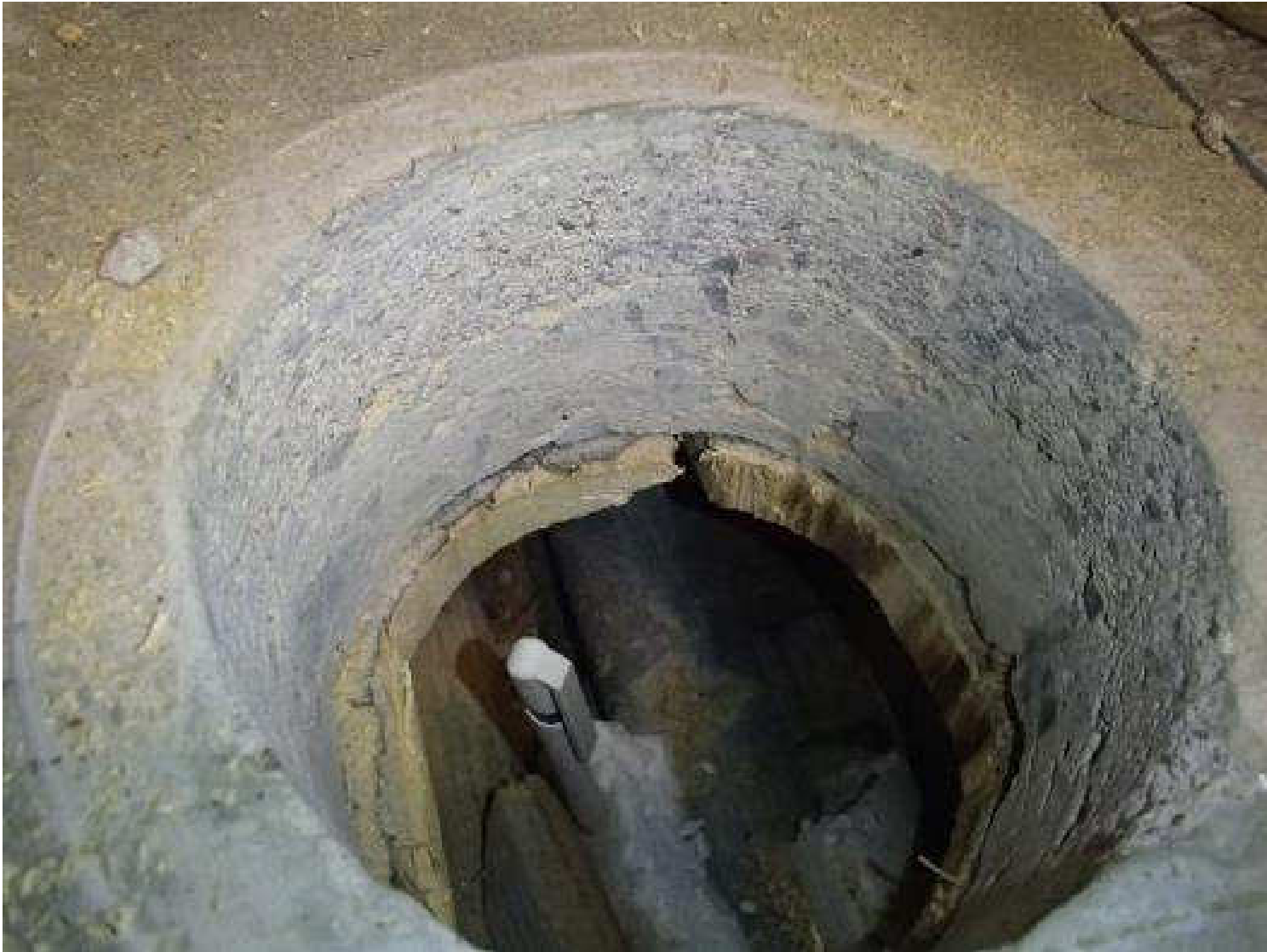
Kuva 75. Rakenneavaus, RAKL28, yhdyskäytävän alapohjarakenteeseen yhdyskäytävän reuna-alueelta.
