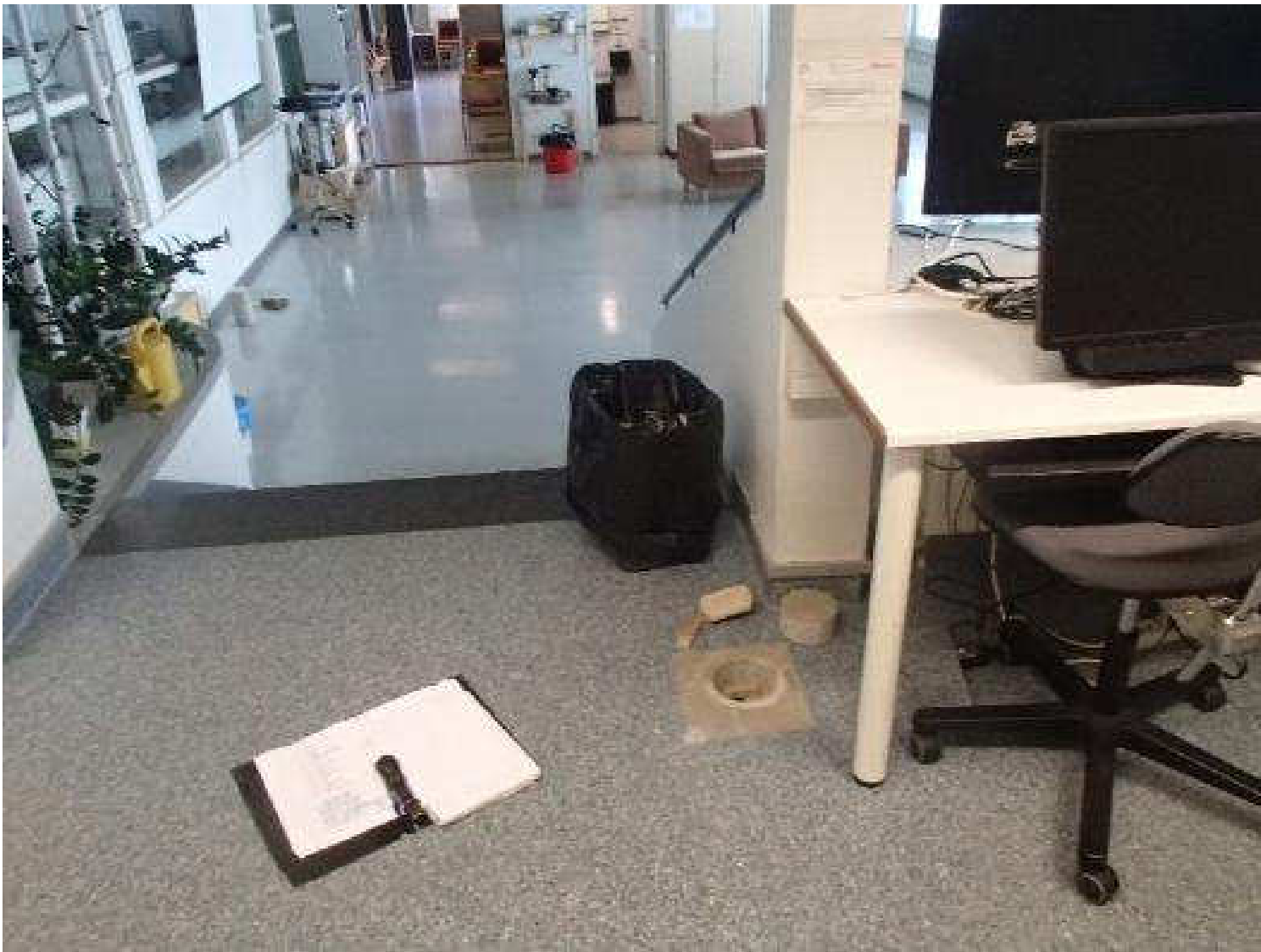
Kuva 38. Rakenneavaus, RAKL21, opettajienhuoneen alapohjarakenteeseen putkikanaalin kohdalta.
