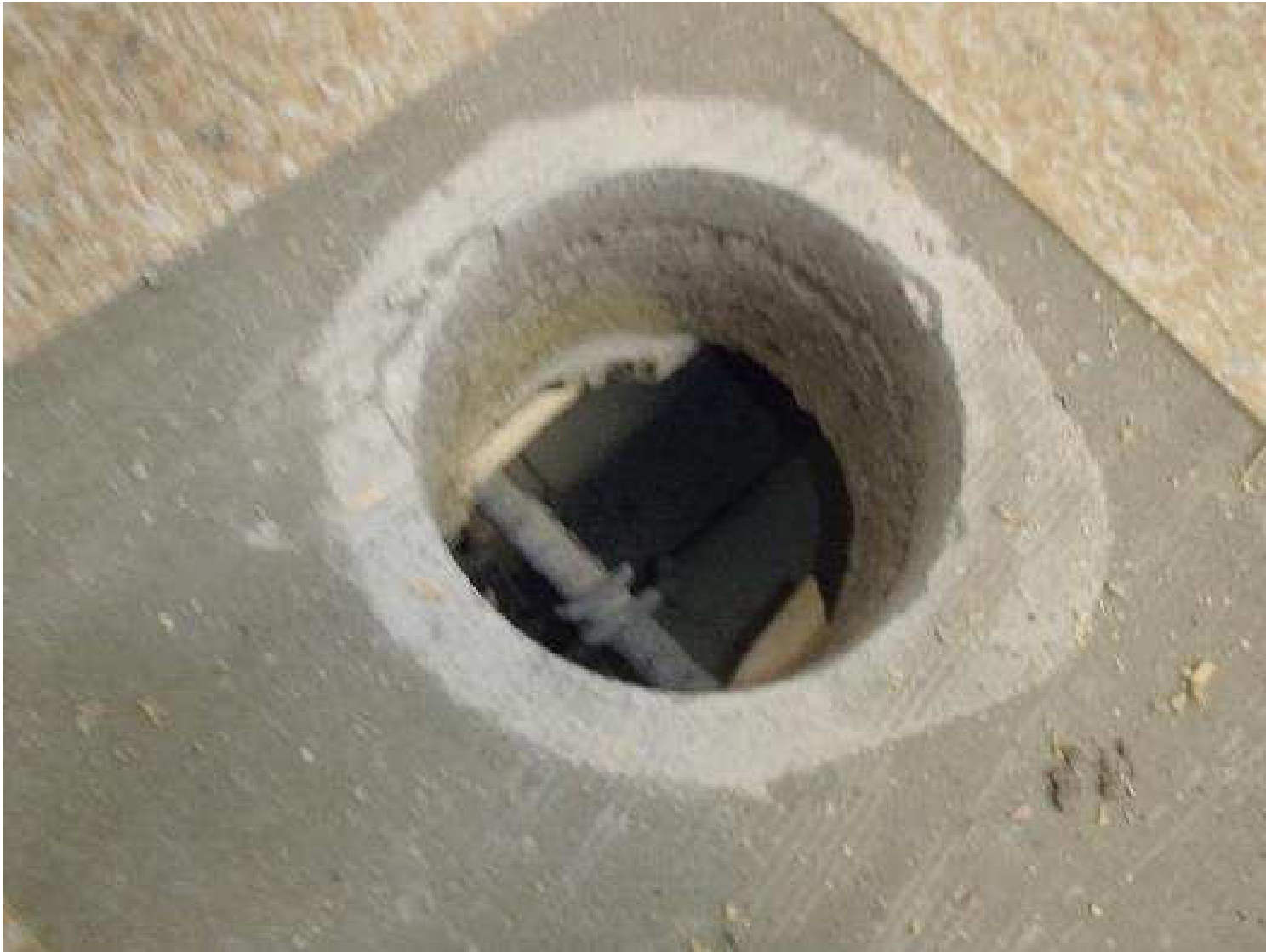
Kuva 31. Rakenneavaus, RAKL13, luokkahuoneen 17 alapohjarakenteeseen putkikanaalin kohdalta.
