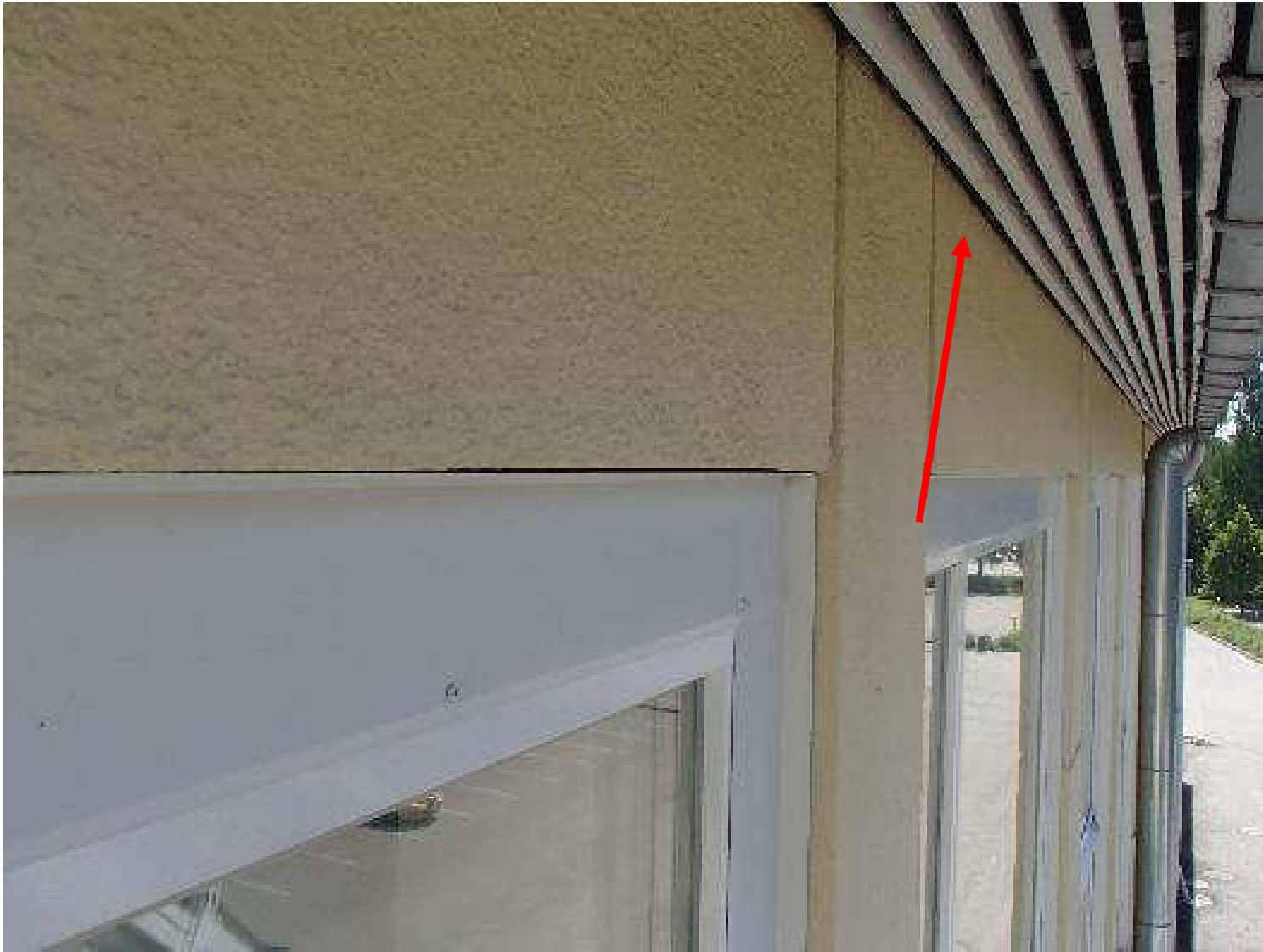
Kuva 110. Julkisivujen ja räystäiden välissä ei havaittu vastapellityksiä.
