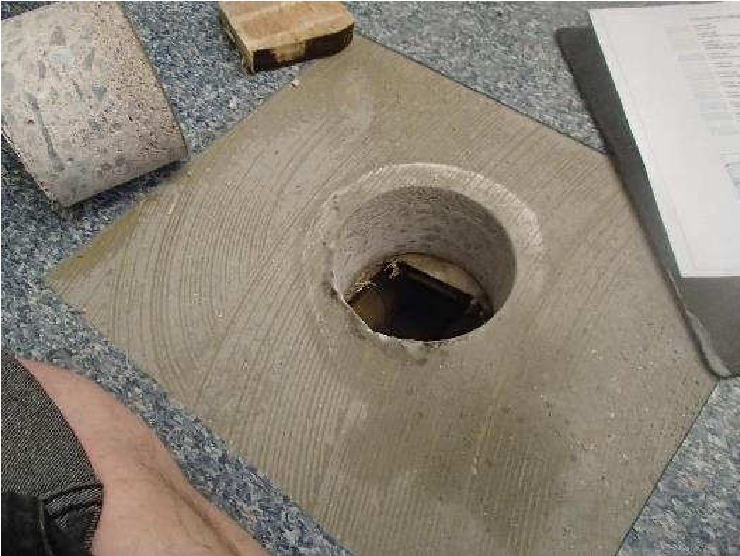
Kuva 73. Rakenneavaus, RAKL9, luokkahuoneen 1 alapohjarakenteeseen luokan reuna-alueelta.
