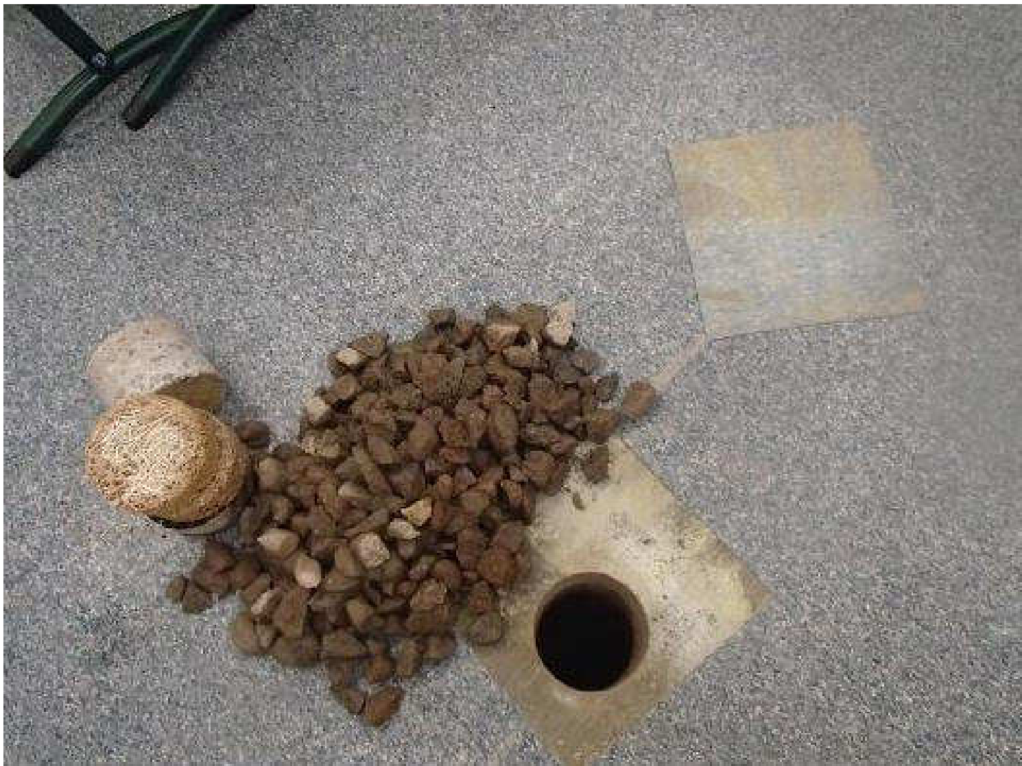
Kuva 71. Rakenneavaus, RAKL7, luokkahuoneen 3 alapohjarakenteeseen luokan keskialueelta.
