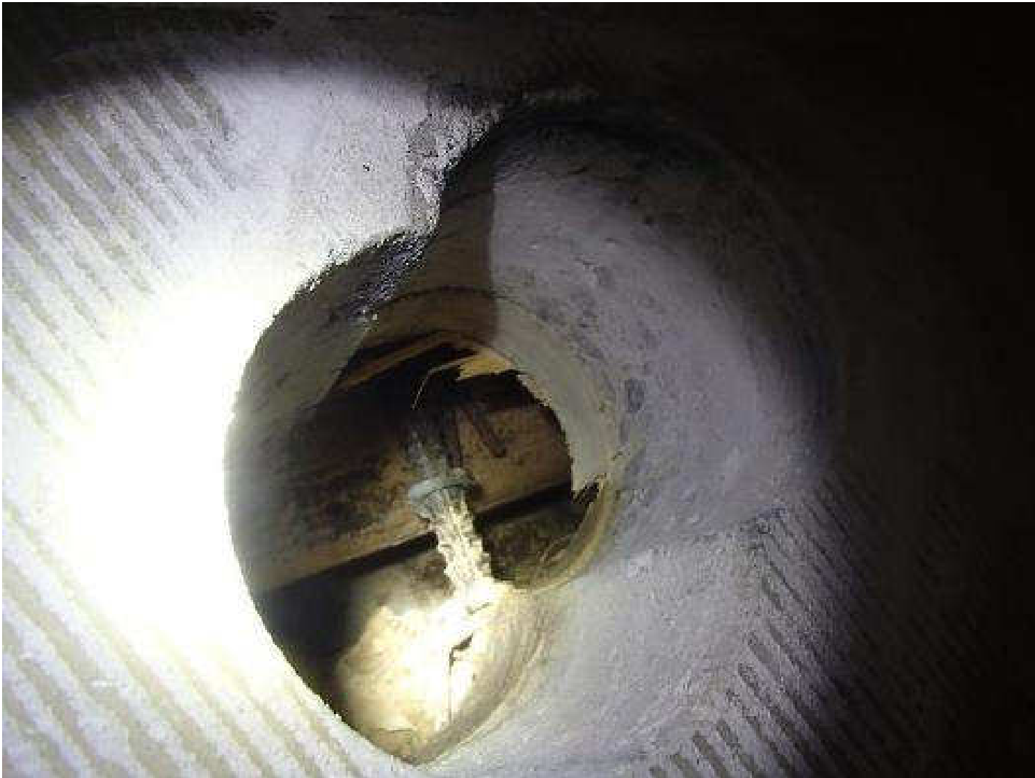
Kuva 66. Rakenneavaus, RAKL1, luokkahuoneen 8 alapohjarakenteeseen putkikanaalin kohdalta.
