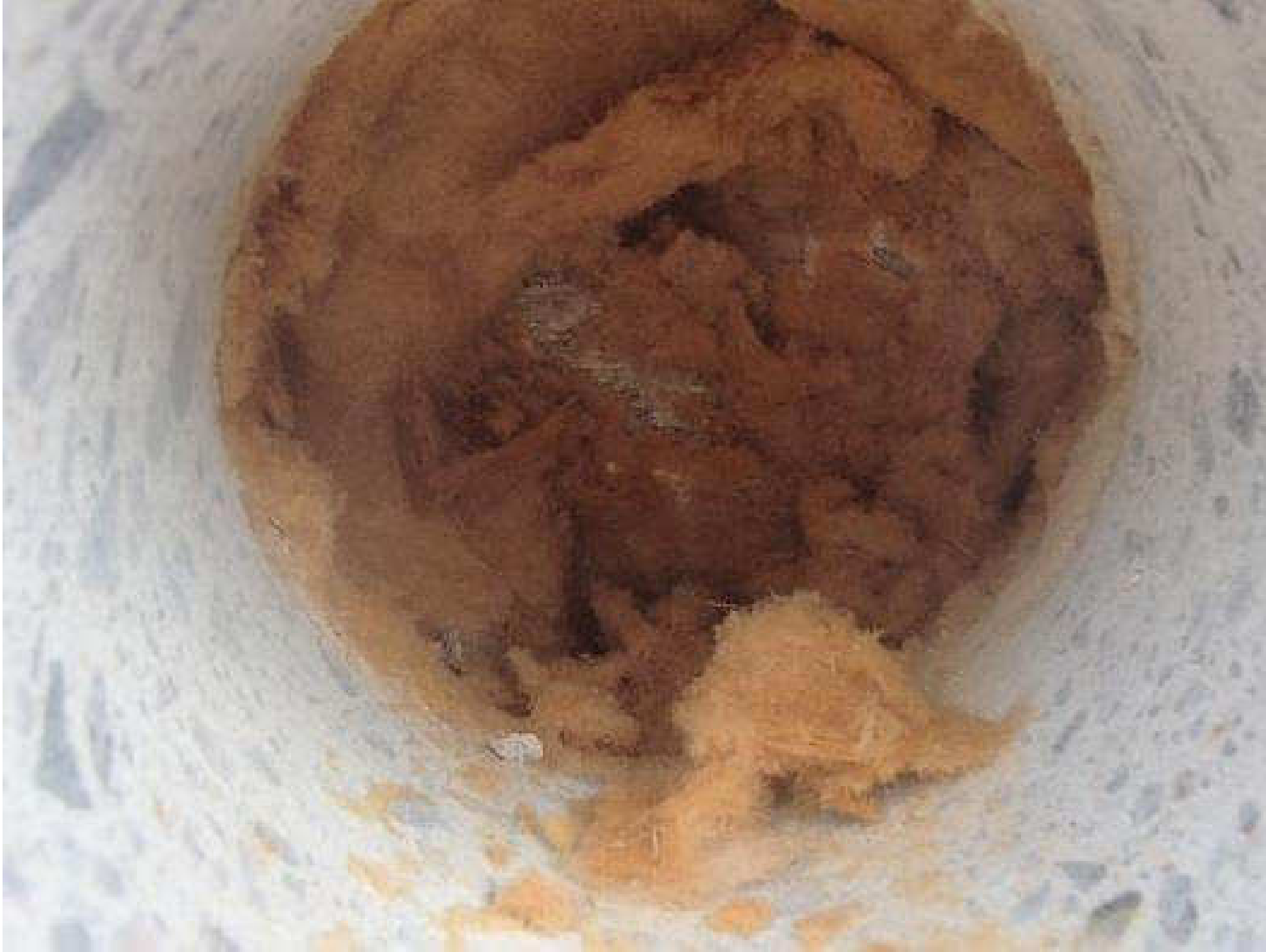
Kuva 78. Rakenneavaus, JS13A, betonisokkeliin.
