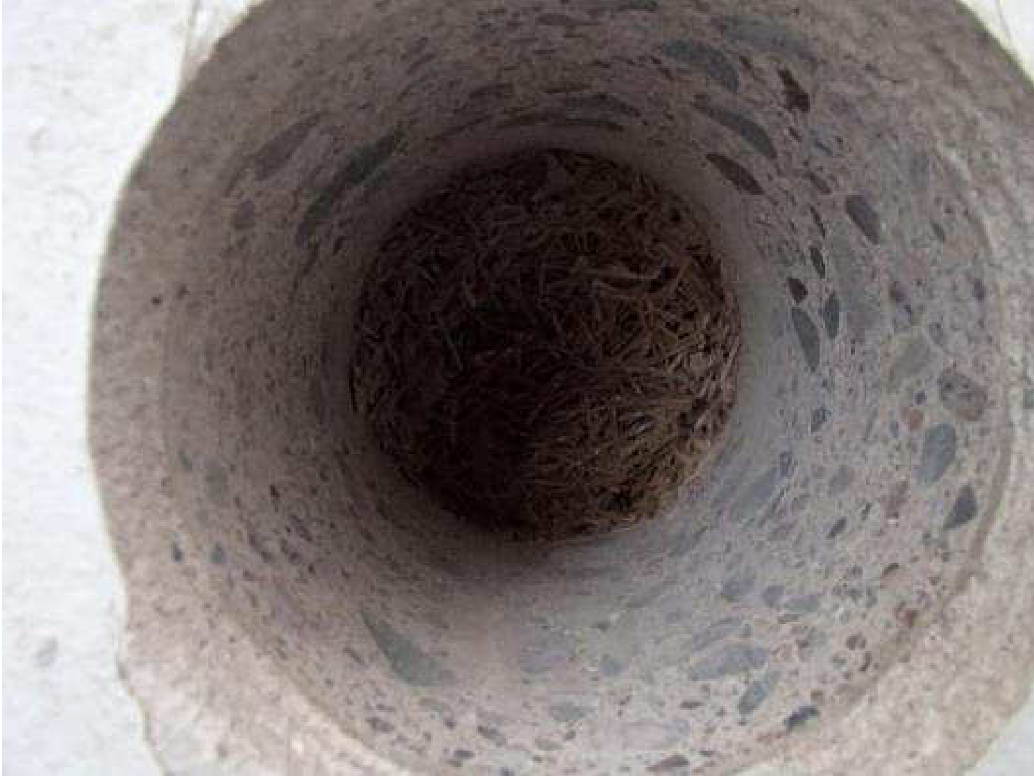
Kuva 20. Rakenneavauskohta, MVS3, sisäkautta luokan 30 ulkovaipparakenteeseen.
