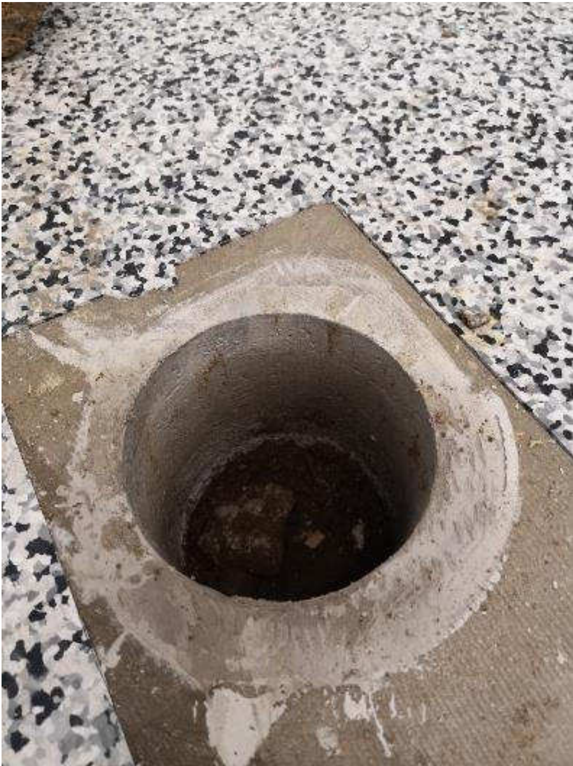
Kuva 86. Rakenneavaus, RAKL19, luokkahuoneen 25 alapohjarakenteeseen.
