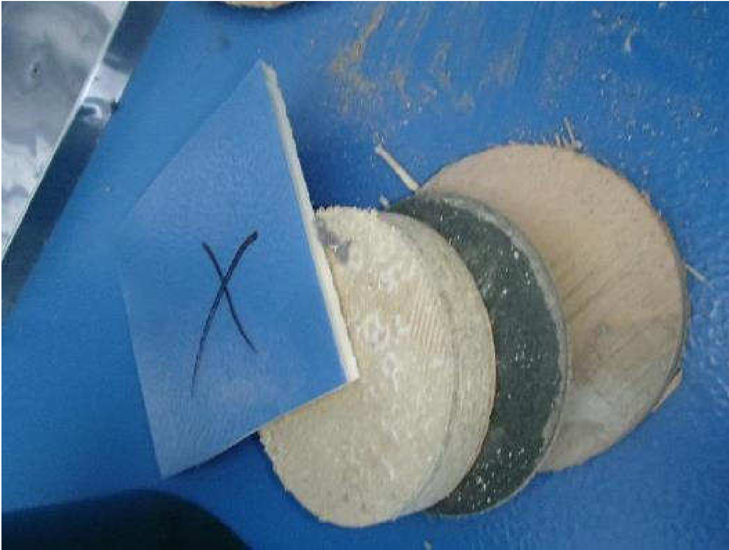
Kuva 26. Rakenneavauskohta, VP2, liikuntasalin välipohjarakenteeseen.
