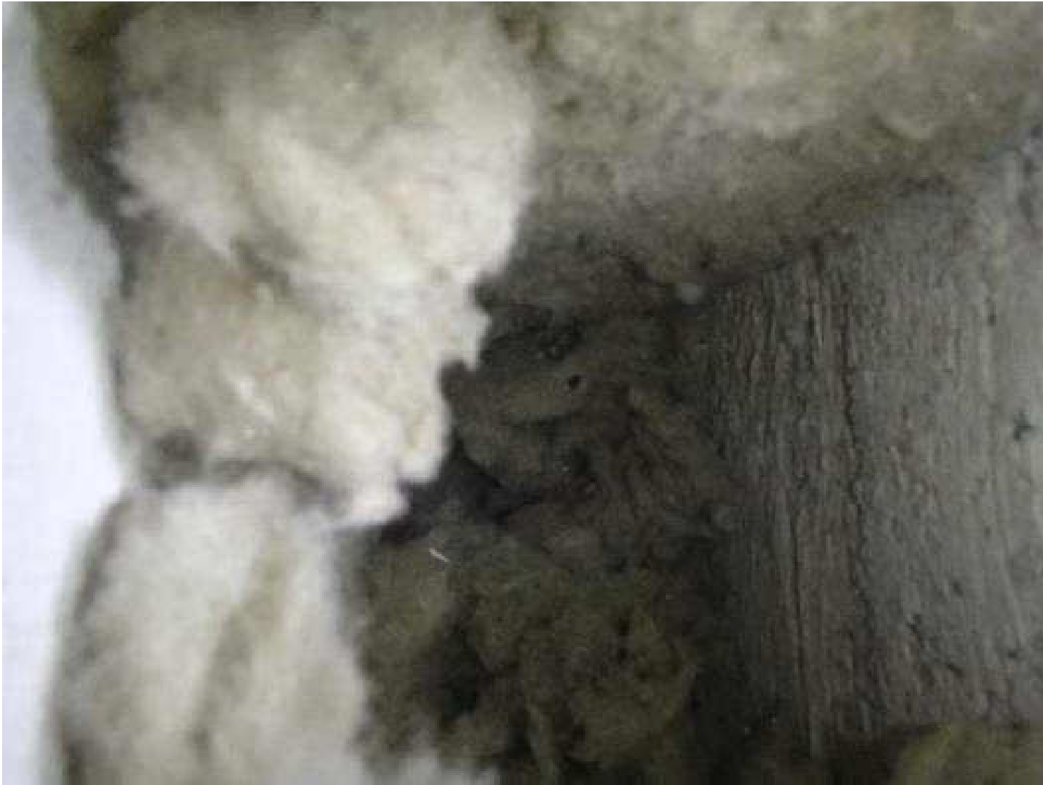
Kuva 80. Rakenneavaus, JS17, betonisokkeliin. Sokkelin eristehalkaisun alapinta on syväällä maanpinnan alapuolella.
