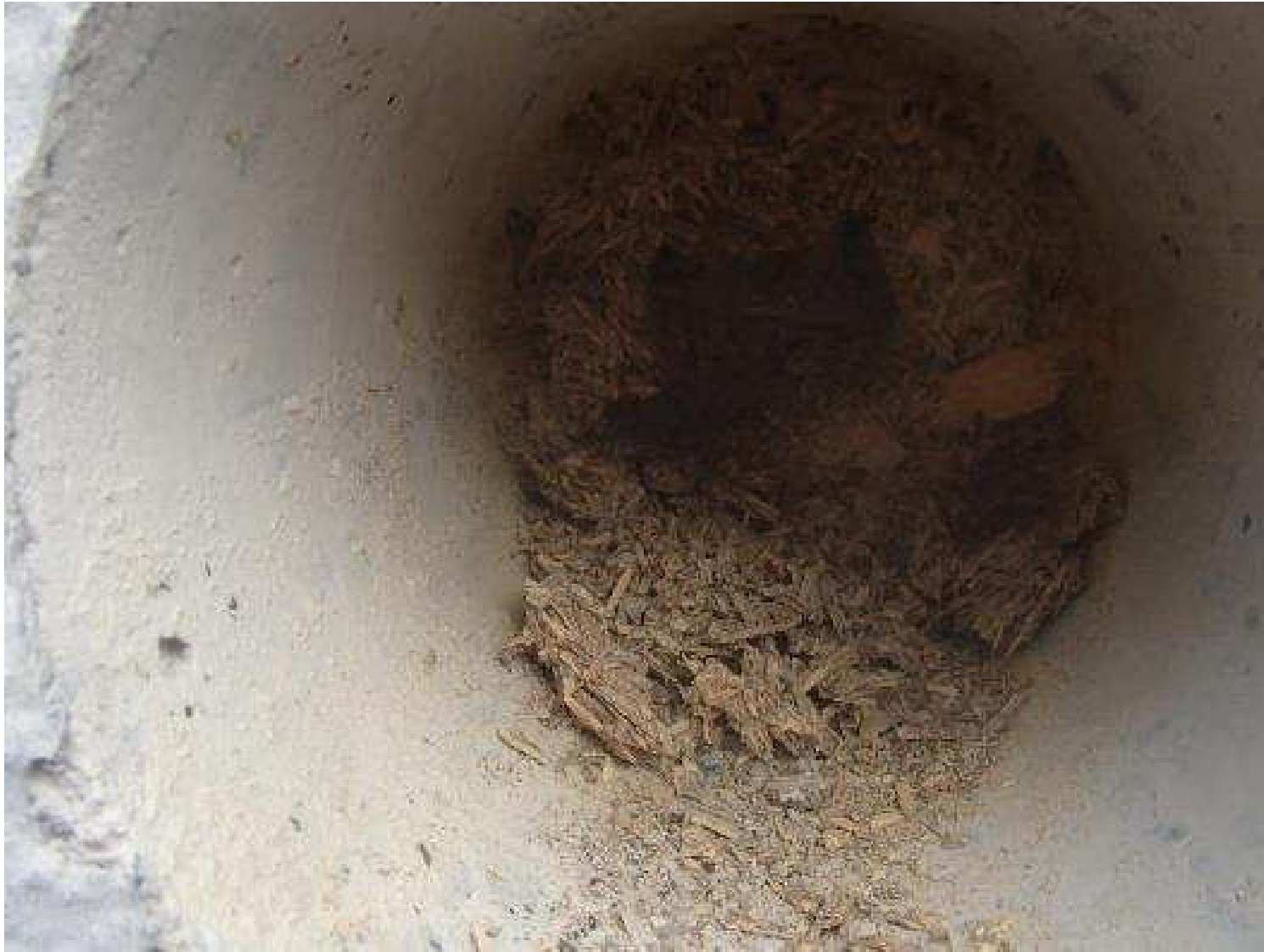
Kuva 13. Rakenneavauskohta, JS14A, sokkeliin.
