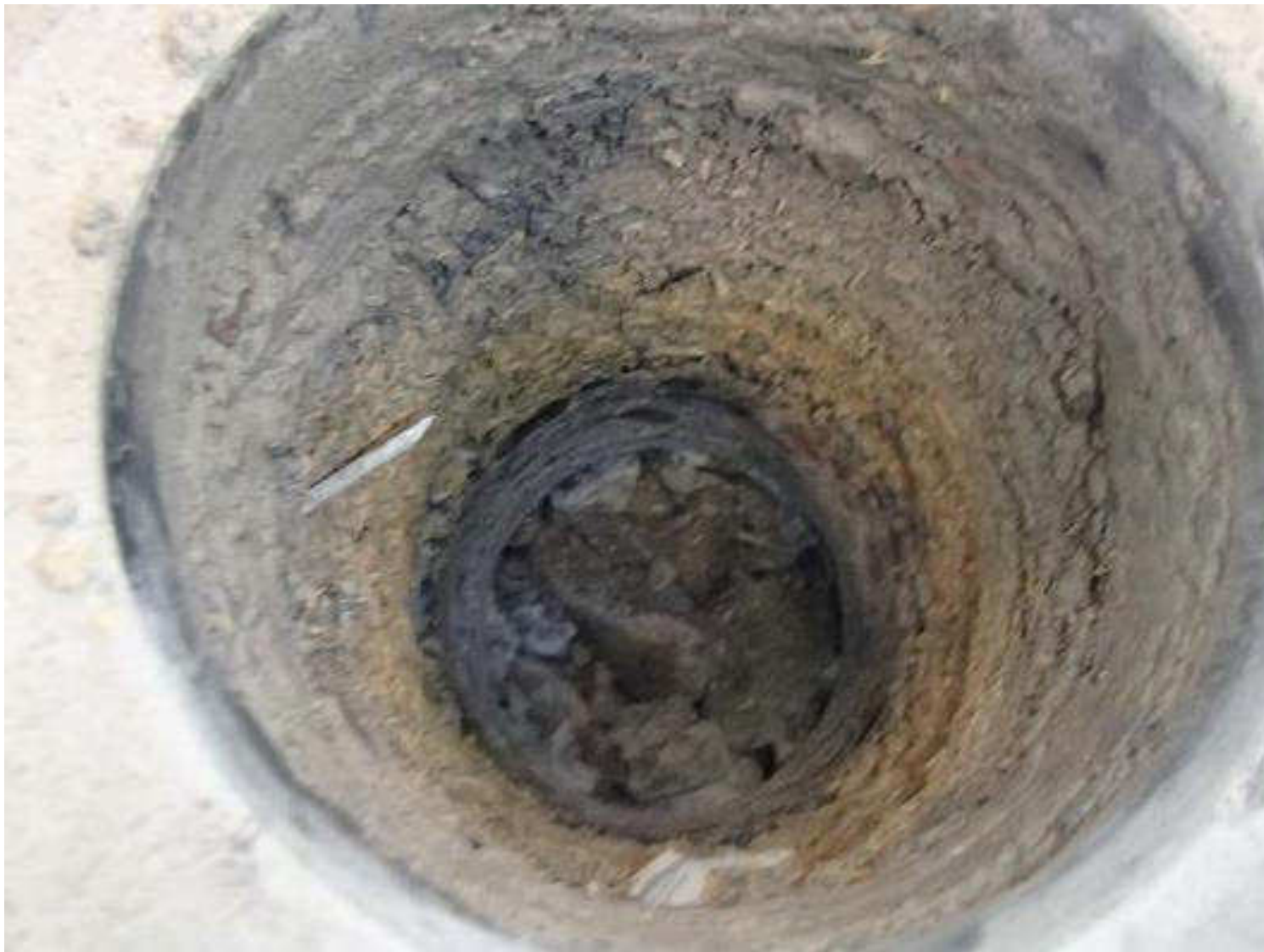
Kuva 34. Rakenneavaus, RAKL16, luokahuoneen 21 alapohjarakenteeseen.
