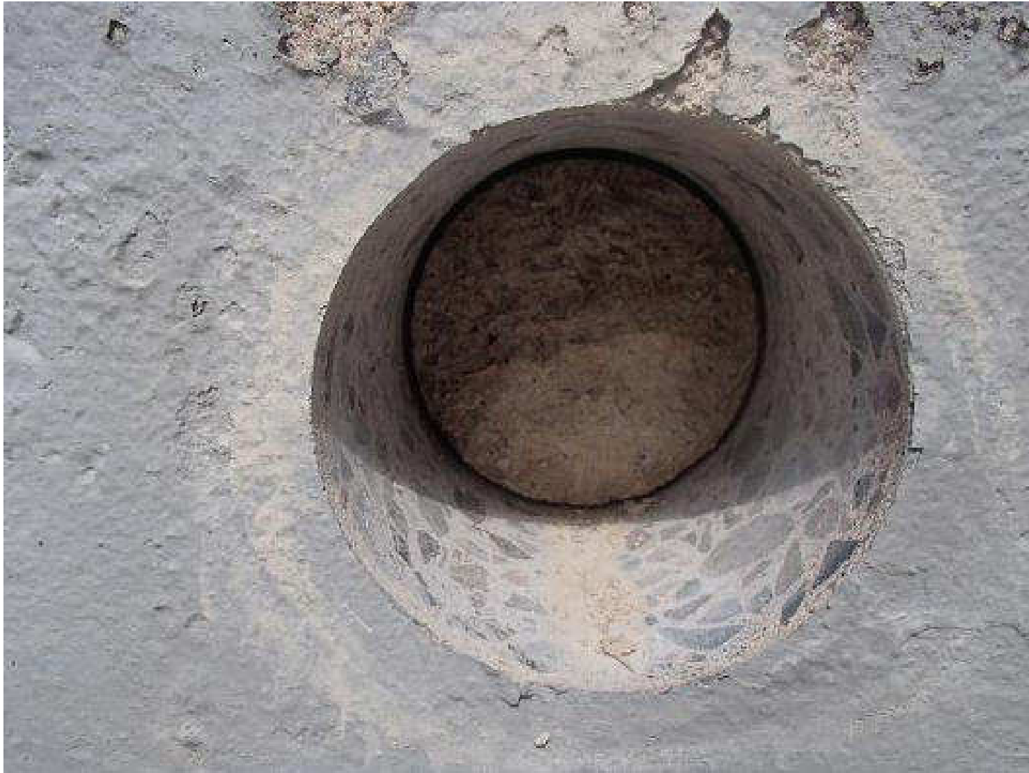
Kuva 45. Rakenneavaus, JS1A, betonisokkeliin.
