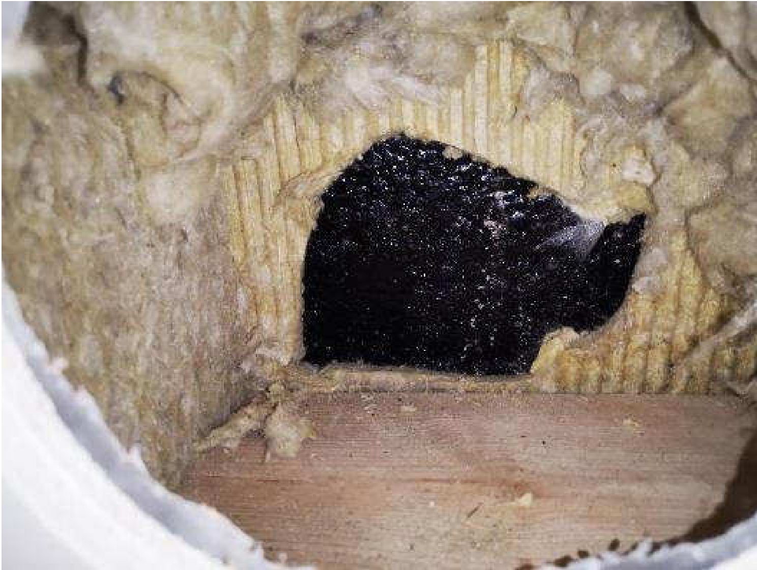
Kuva 19. Rakenneavauskohta, RAKS 12, sisäkautta luokan 21 ulkovaipparakenteeseen.
