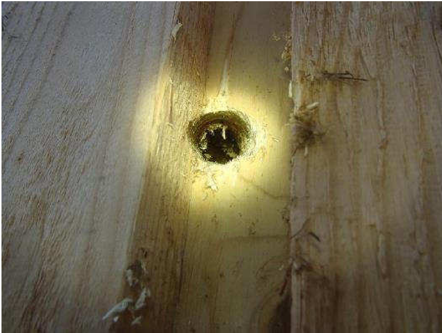
Kuva 63. Rakenneavauskohta, Tilke1, ikkunoiden väliseen ulkovaipparakenteeseen.
