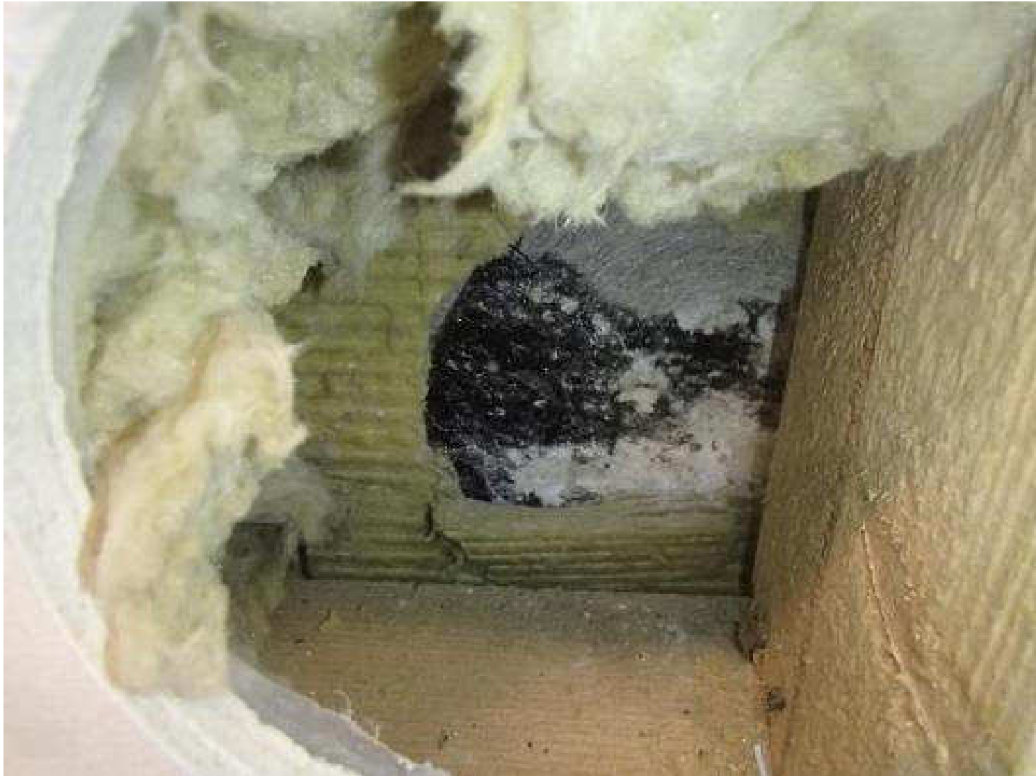
Kuva 61. Rakenneavauskohta, RAKS6, luokkahuoneen 3 ulkovaipparakenteeseen sisäkautta.
