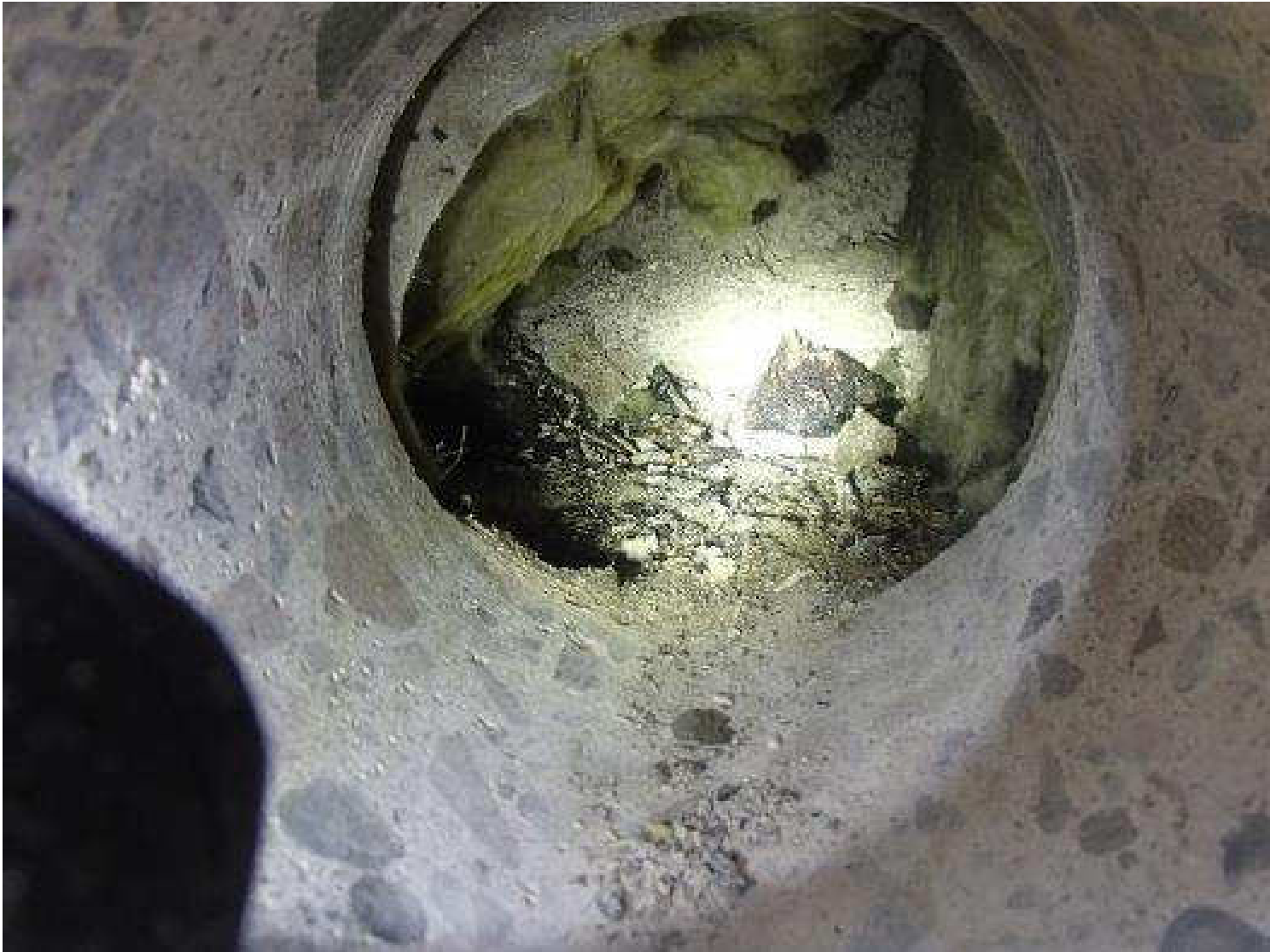
Kuva 46. Rakenneavaus, JS2, betonisokkeliin.
