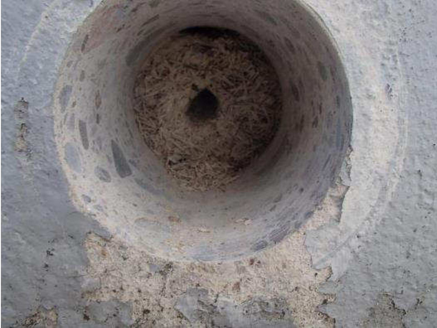
Kuva 7. Rakenneavauskohta, JS10, ulkovaipparakenteiden sokkeliin.
