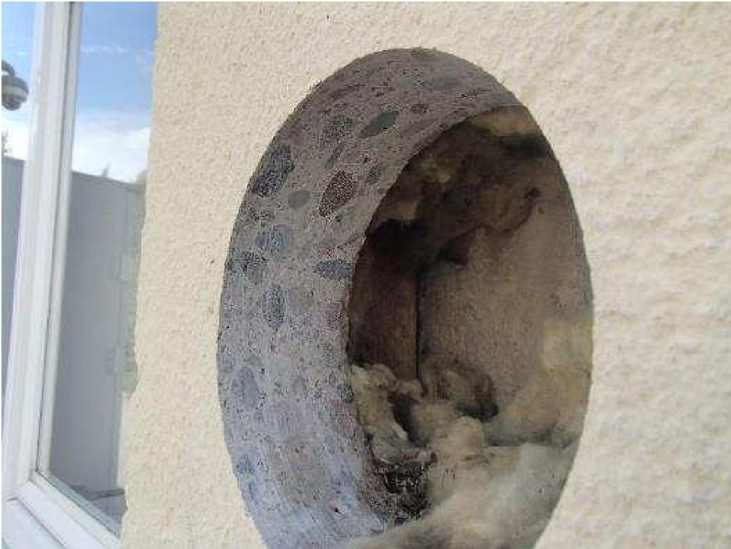
Kuva 83. Rakenneavaus, JS21Y, julkisivuun.
