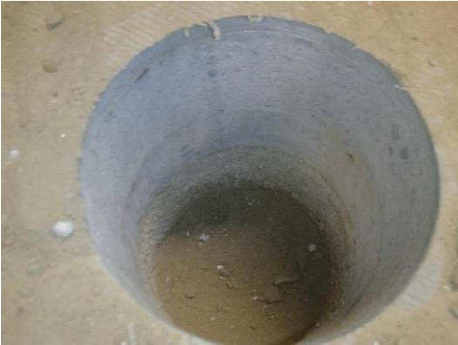
Kuva 37. Rakenneavaus, RAKL20, käytävän alapohjarakenteeseen putkikanaalin kohdalta.
