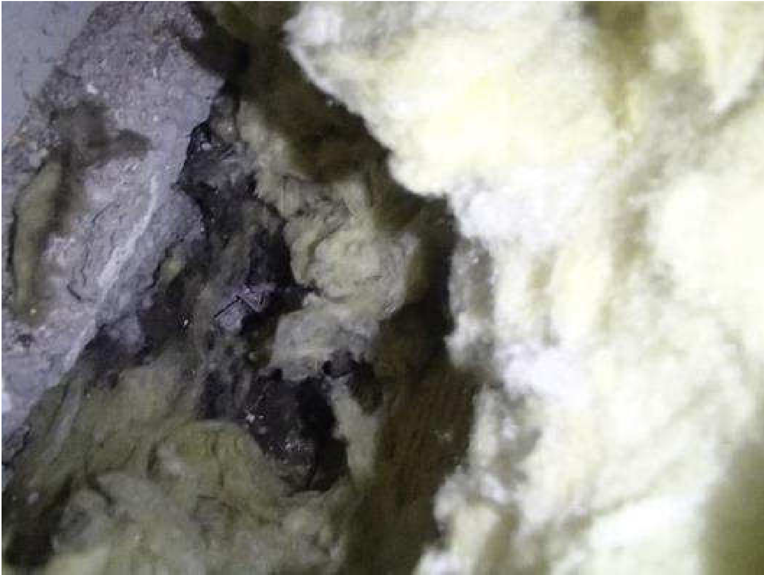
Kuva 48. Rakenneavaus, JS3, betonisokkeliin. Kuva otettu betonisokkelin eristehalkaisusta. Eristehalkaisun päällä on bitumisively.
