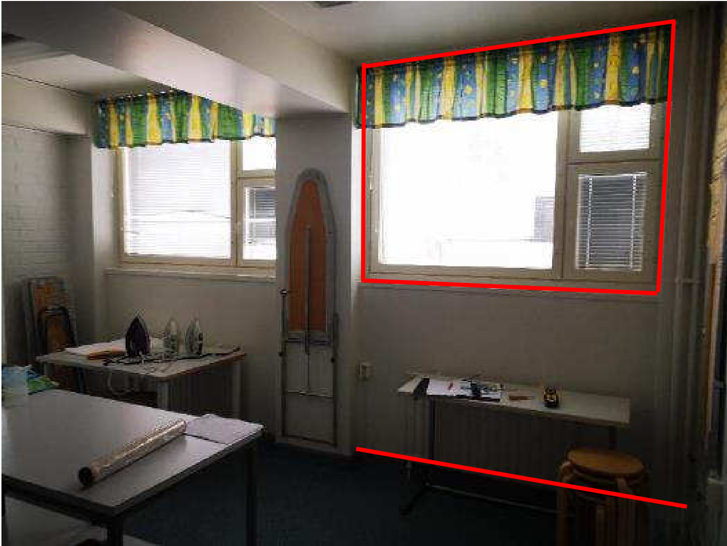
Kuva 190. Kodinhoitoluokan ulkovaipan tyypillisimmät ilmavuotopaikat sisäilmaan.
