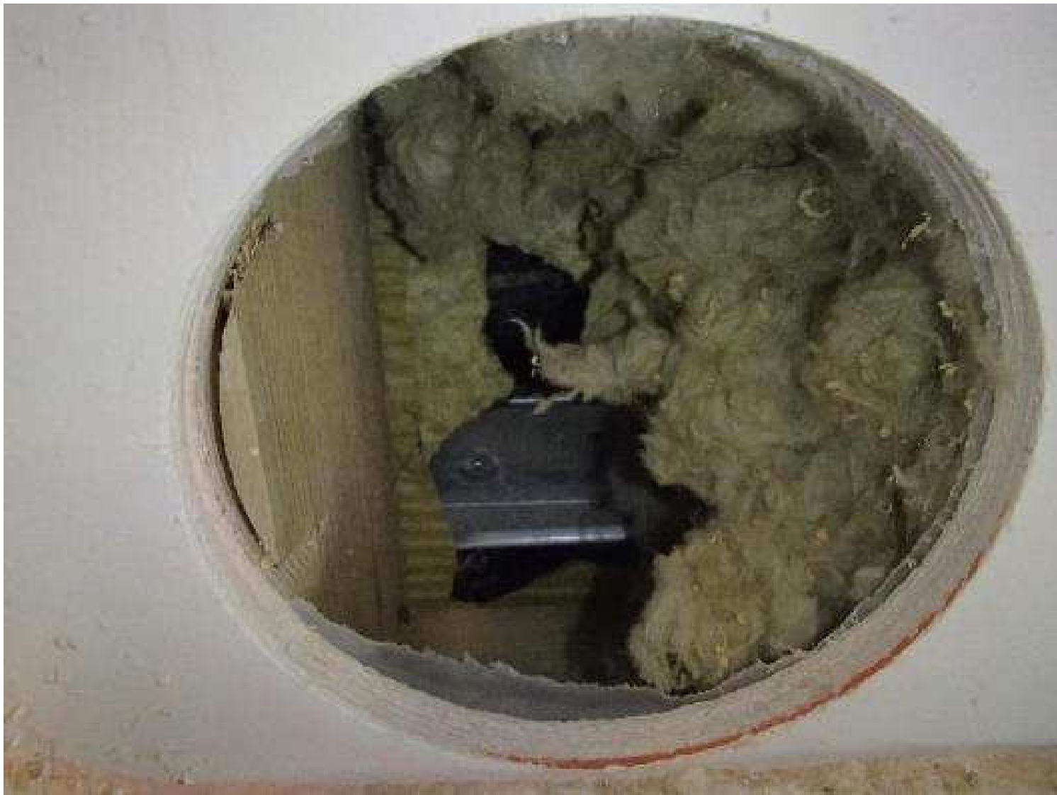
Kuva 16. Rakenneavauskohta, RAKS 9, sisäkautta luokan 15 ulkovaipparakenteeseen.
