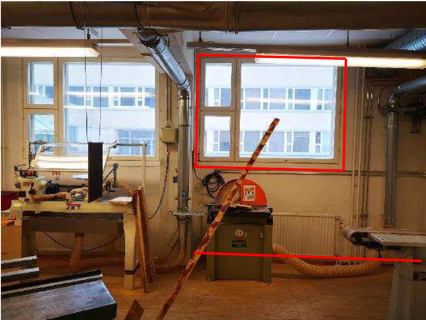
Kuva 193. Teknisen työn luokan tyypillisimmät ilmavuotopaikat tilan sisäilmaan.
