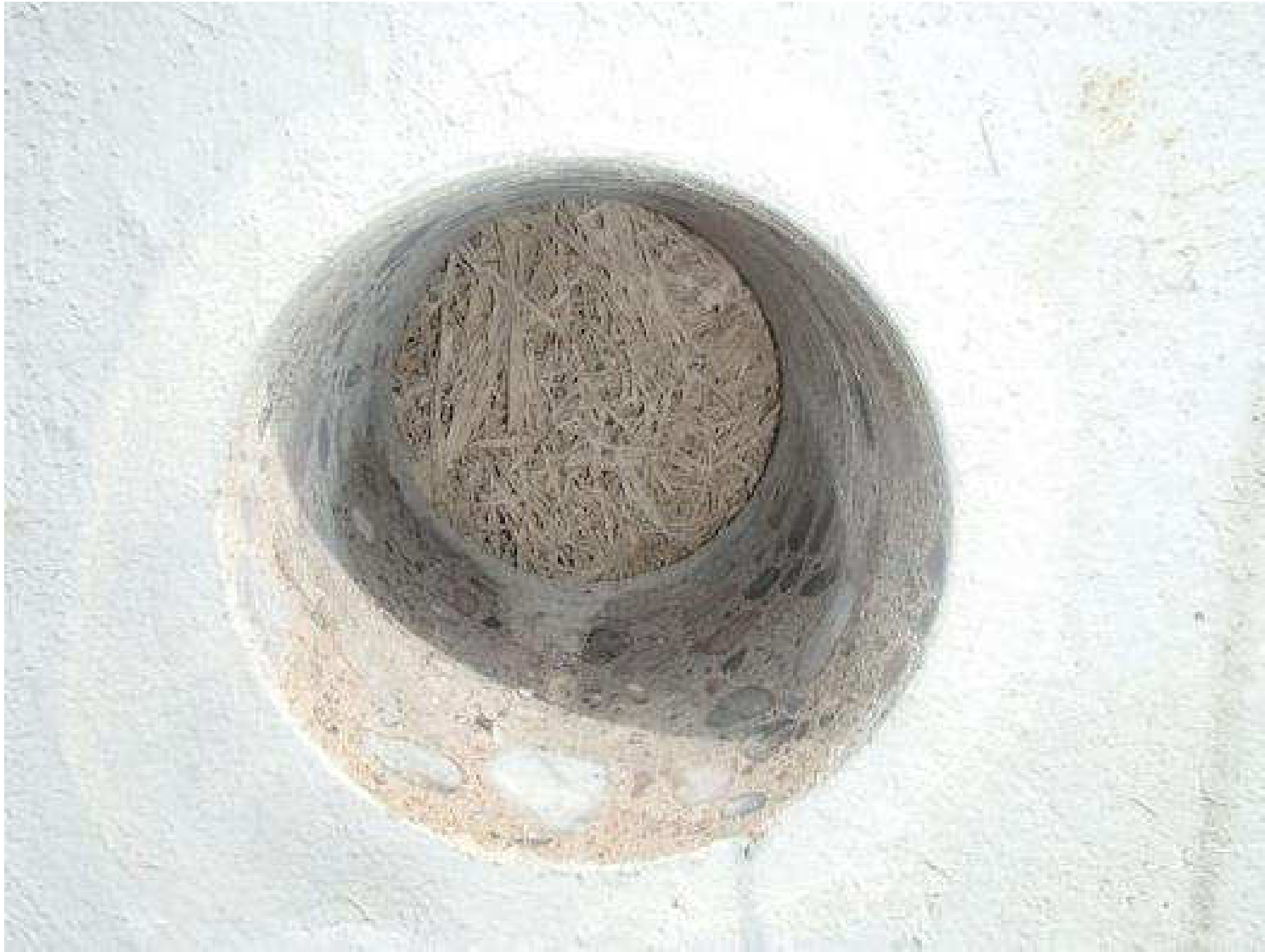
Kuva 11. Rakenneavauskohta, JS22A, sokkeliin.
