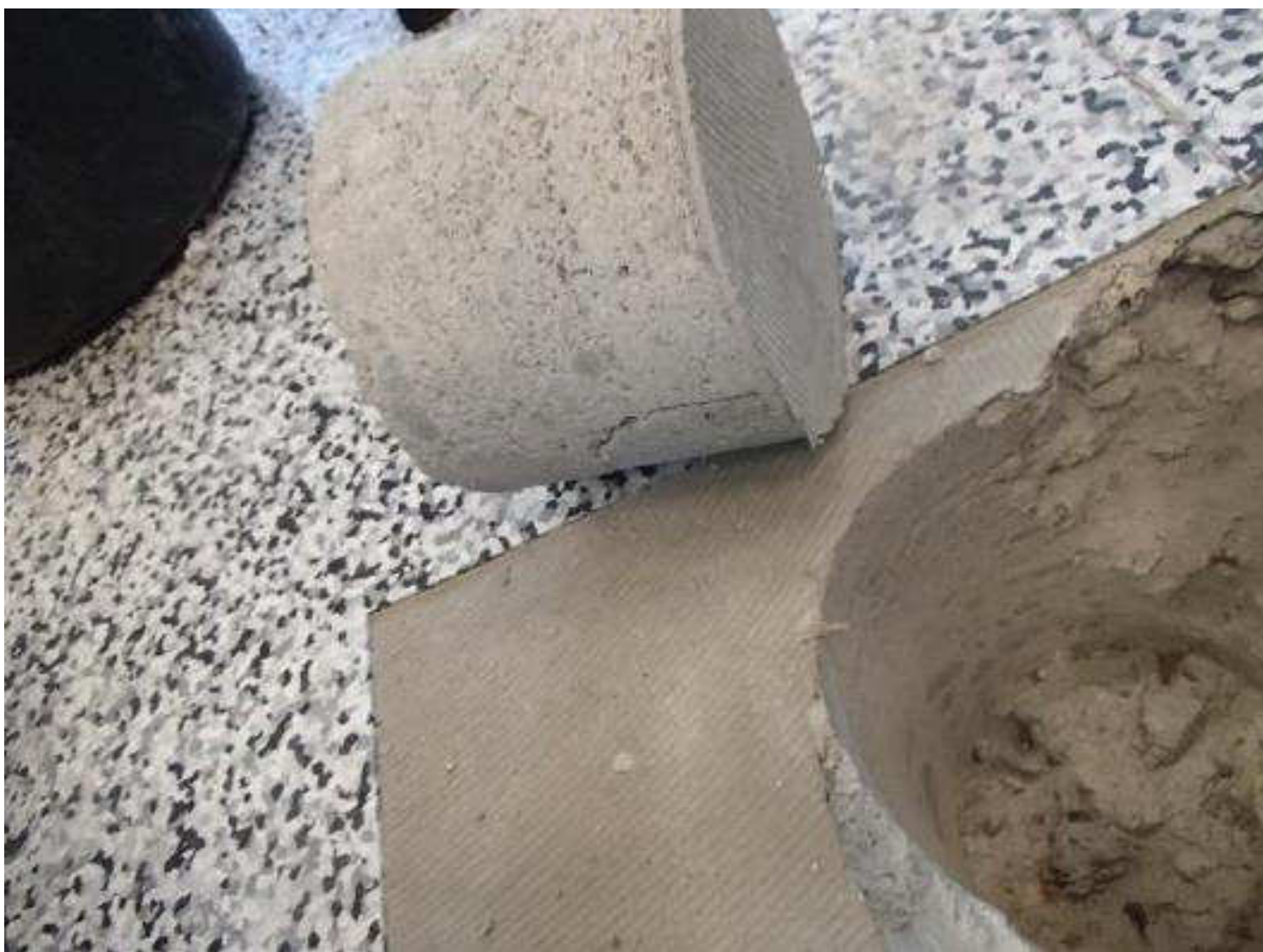
Kuva 24. Rakenneavauskohta, VP1, luokan 39 välipohjarakenteeseen.
