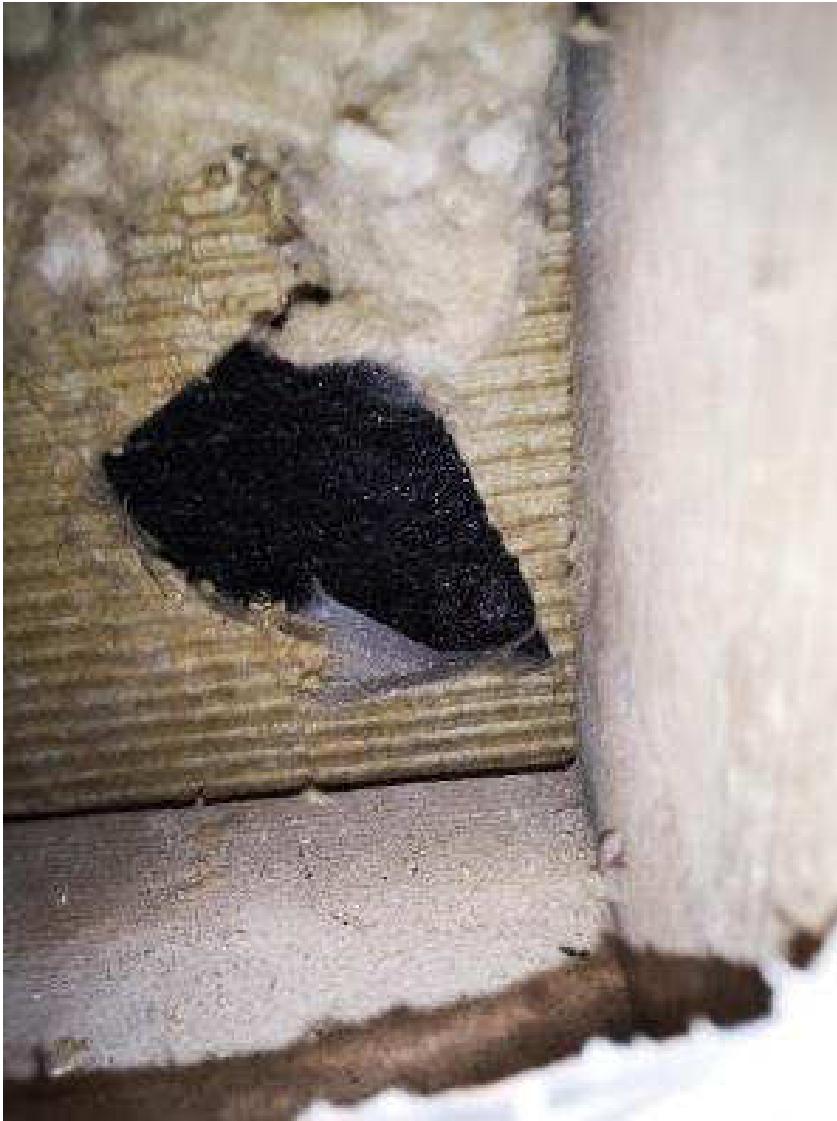
Kuva 17. Rakenneavauskohta, RAKS 10, sisäkautta luokan 17 ulkovaipparakenteeseen.
