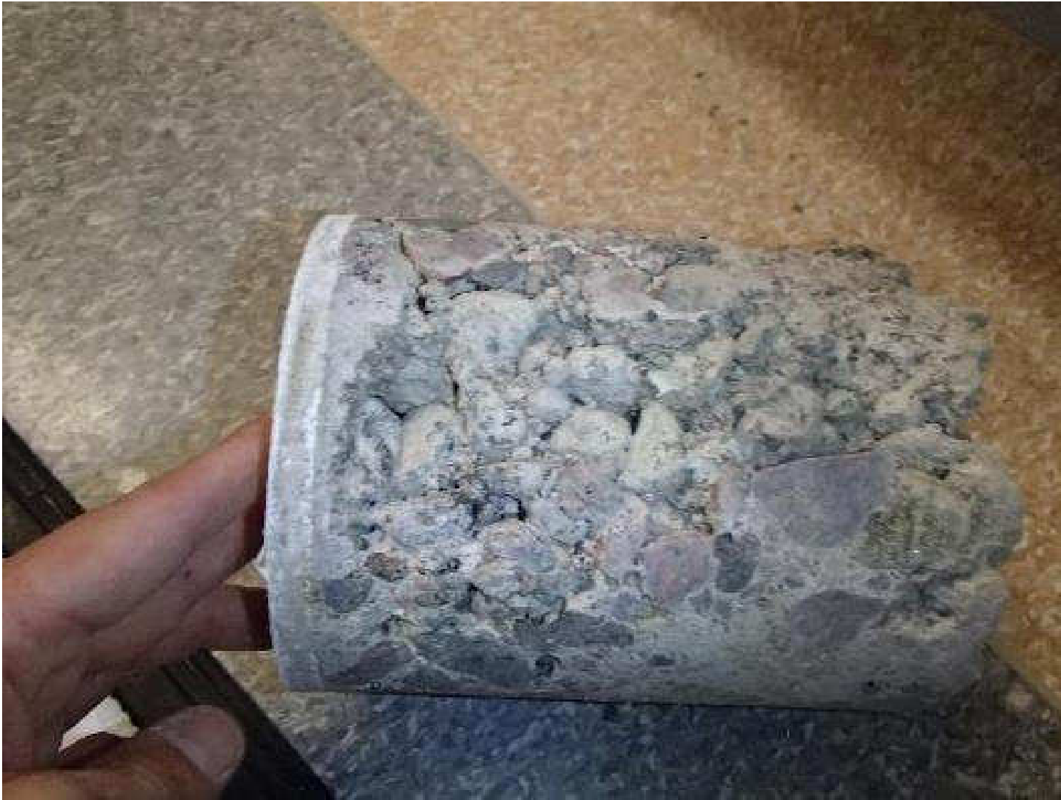
Kuva 98. Rakennearaus, MVS1, yhdyskäytävän maanvastaiseen seinään.
