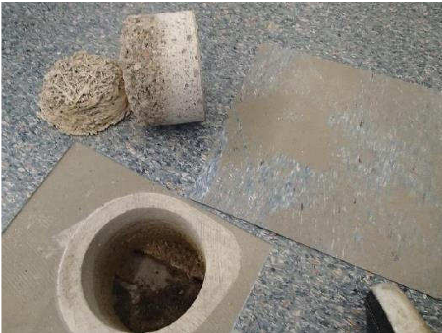
Kuva 28. Rakenneavaus, RAKL10, luokahuoneen 15 alapohjarakenteeseen.
