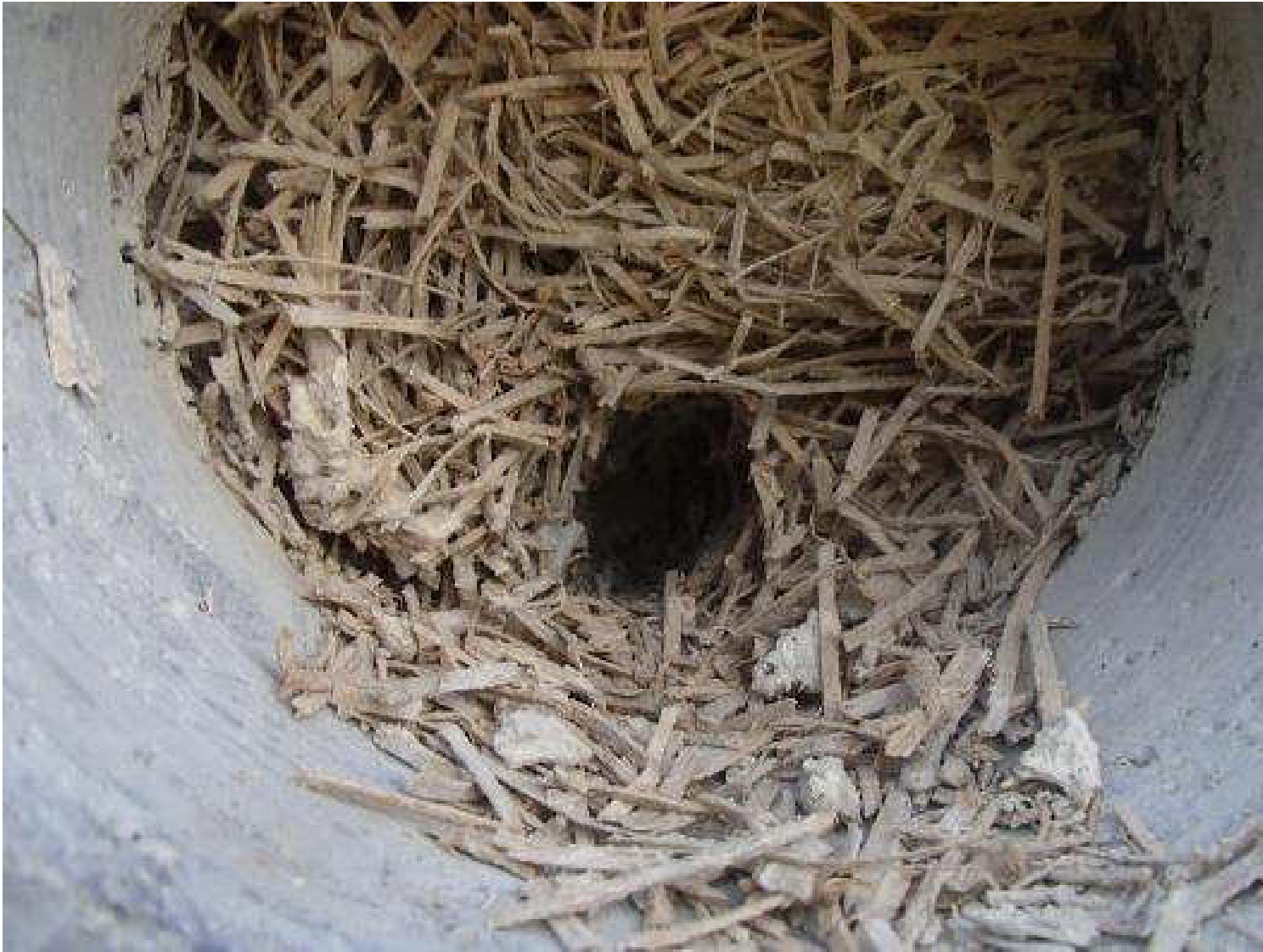
Kuva 52. Rakenneavaus, JS6, julkisivun betonielementtiin.
