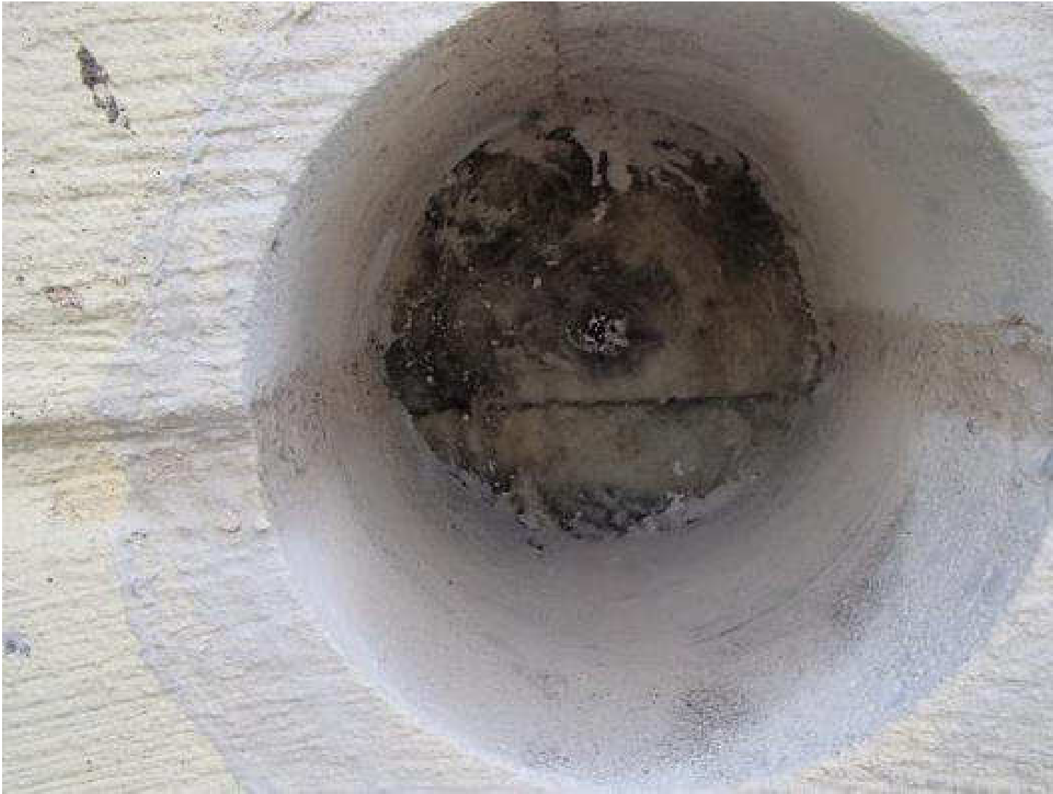
Kuva 53. Rakenneavaus, JS8Y, tiilimuurattuun julkisivuun.
