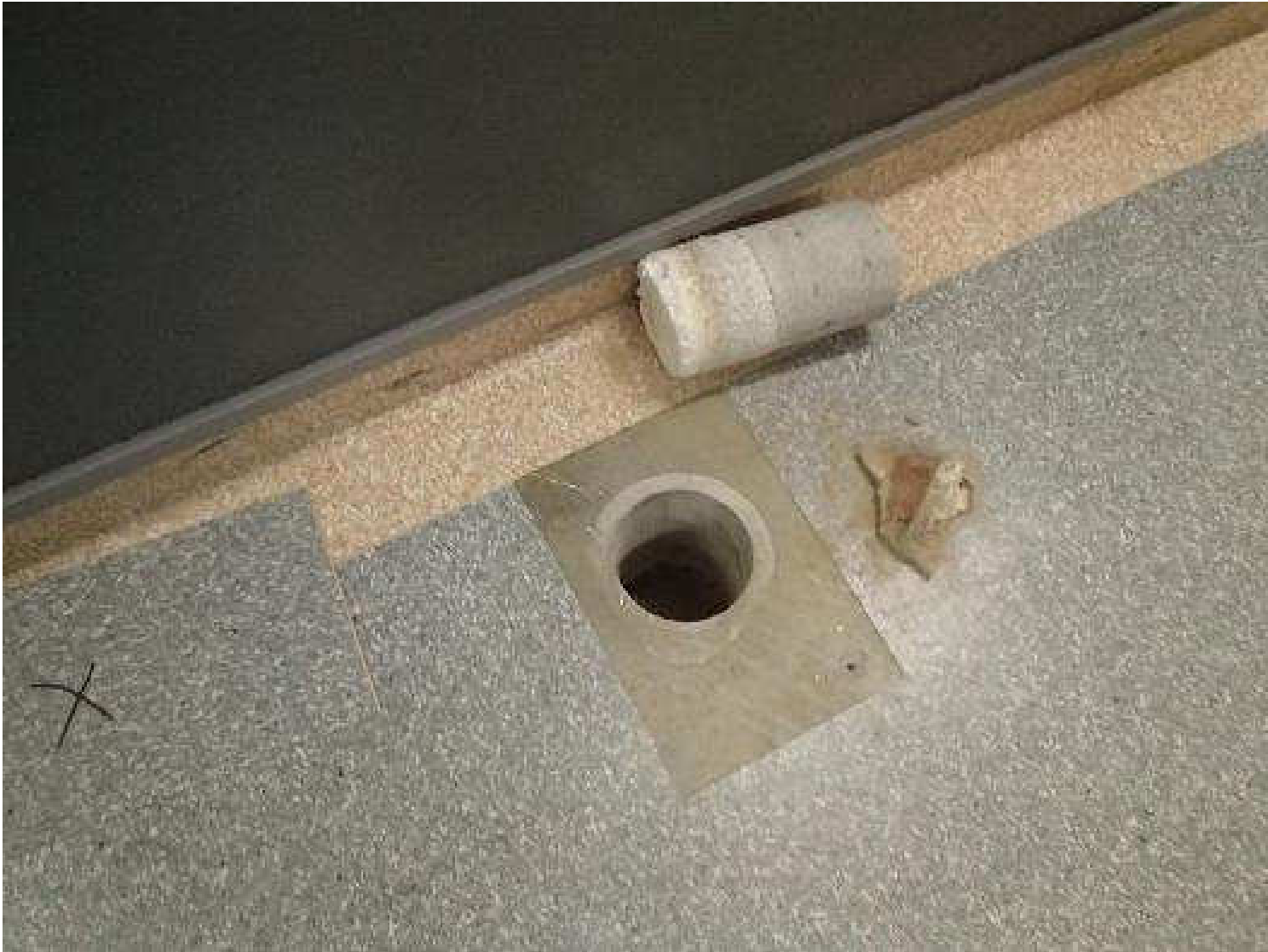
Kuva 36. Rakenneavaus, RAKL20, käytävän alapohjarakenteeseen putkikanaalin kohdalta.
