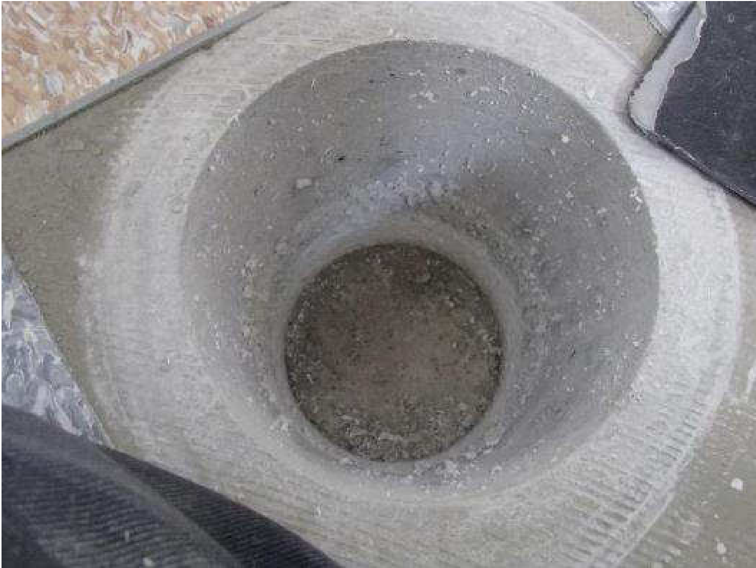
Kuva 39. Rakenneavaus, RAKL22, yhdyskäytävän alapohjarakenteeseen.
