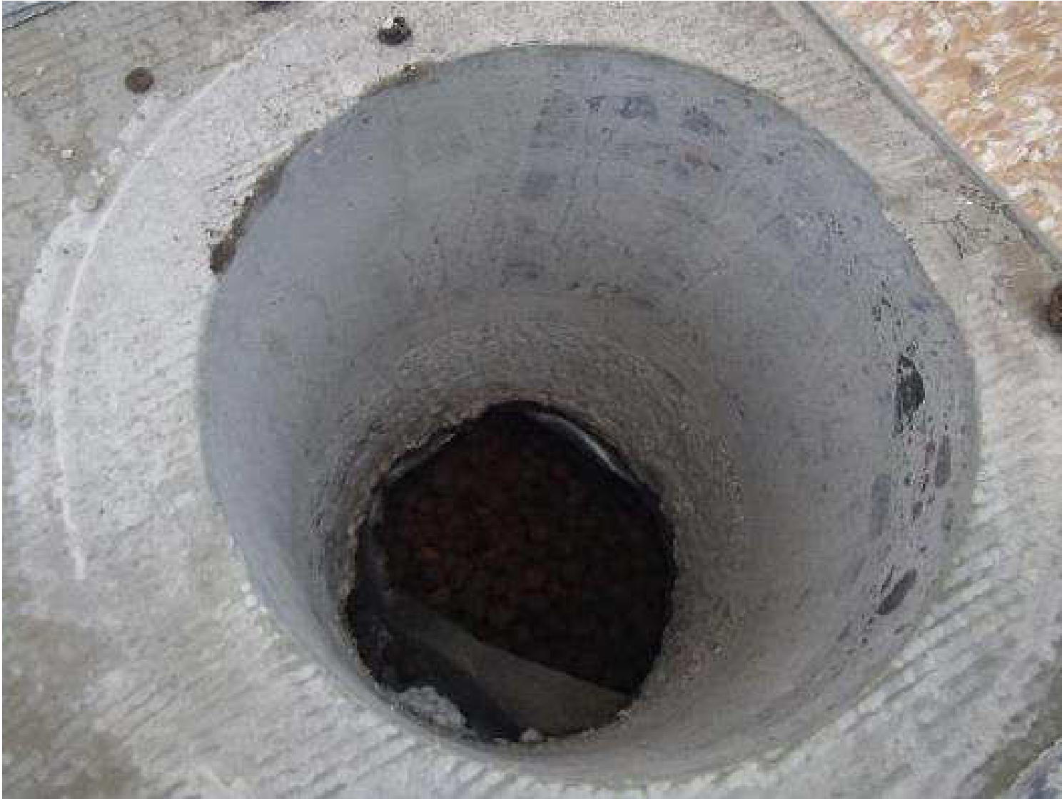
Kuva 40. Rakenneavaus, RAKL23, yhdyskäytävän alapohjarakenteeseen.
