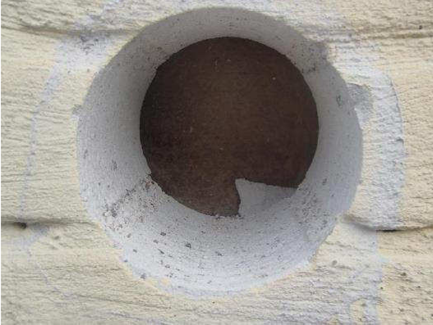
Kuva 77. Rakenneavaus, JS13Y, tiilimuurattuun julkisivuun.
