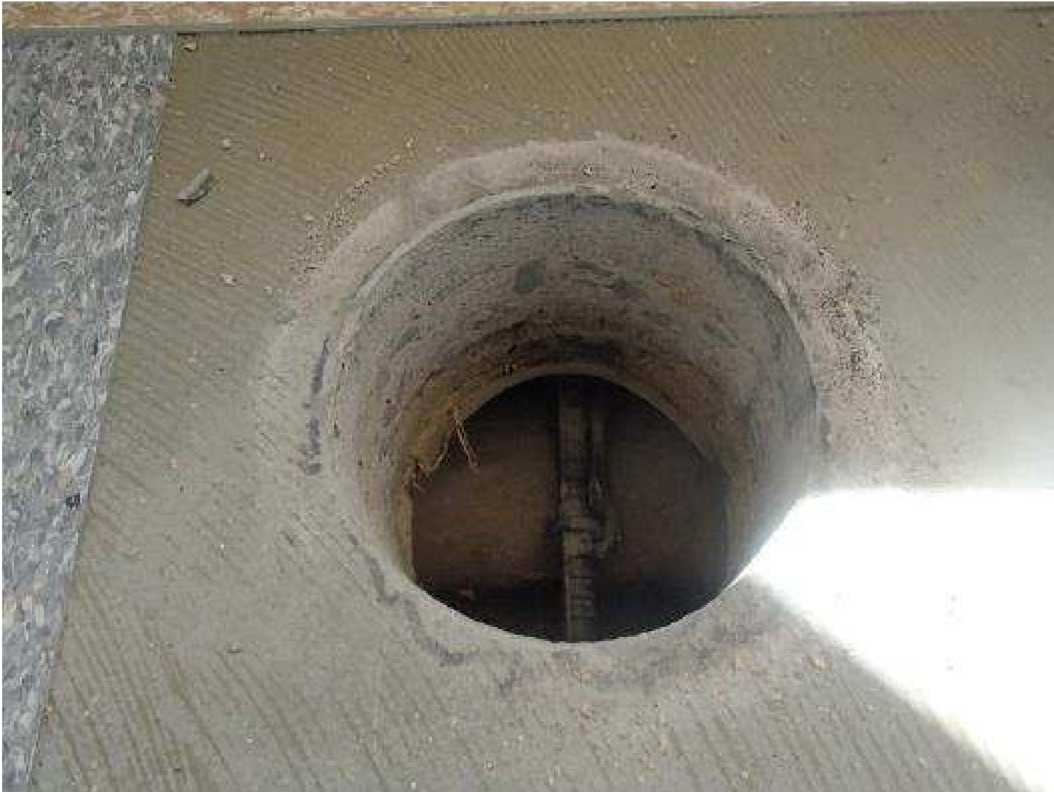
Kuva 68. Rakenneavaus, RAKL3, käytävän alapohjarakenteeseen putkikanaalin kohdalta.
