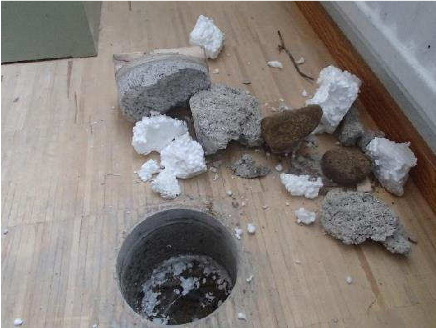
Kuva 89. Rakenneavaus, RAKL25, teknisen työn luokan alapohjarakenteeseen reuna-alueelta.
