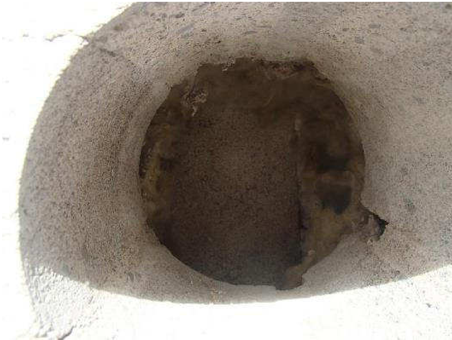
Kuva 44. Rakenneavaus, JS1Y, tiilimuurattuun julkisivuun.
