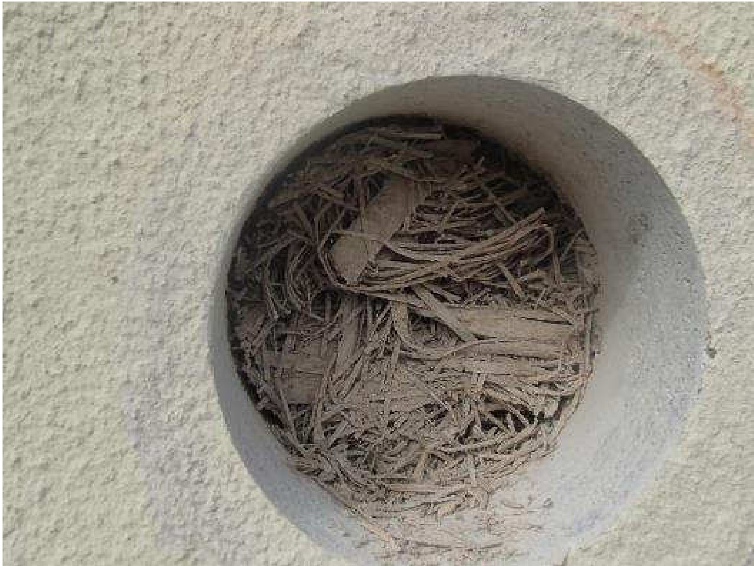
Kuva 8. Rakenneavauskohta, JS12Y, julkisivuun.
