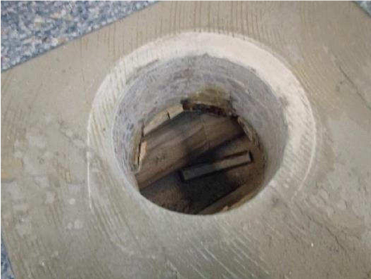
Kuva 72. Rakenneavaus, RAKL8, luokkahuoneen 1 alapohjarakenteeseen luokan reuna-alueelta.
