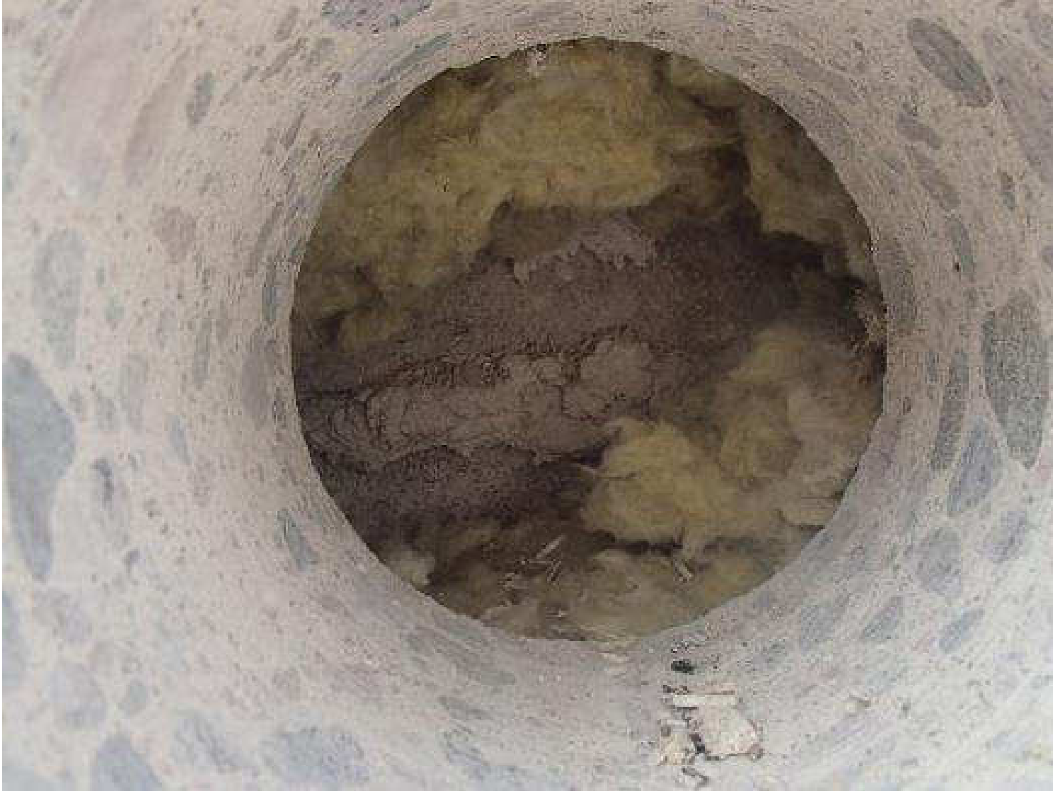
Kuva 14. Rakenneavauskohta, JS15A, sokkeliin.
