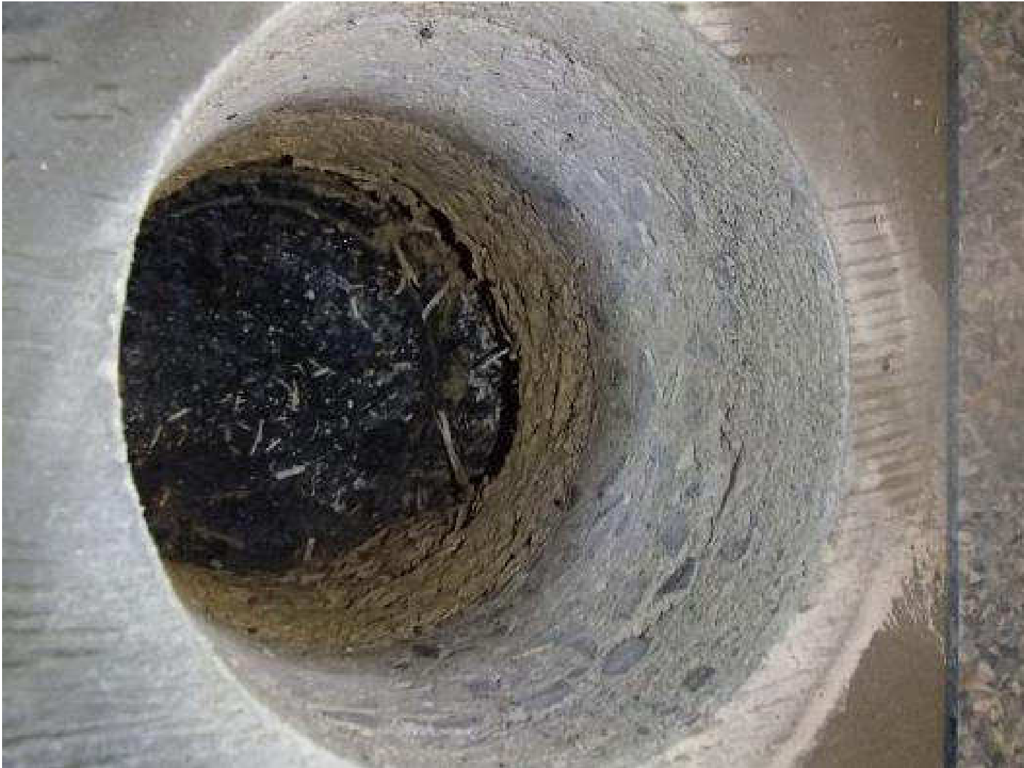
Kuva 70. Rakenneavaus, RAKL5, luokkahuoneen 5 alapohjarakenteeseen luokan keskialueelta.
