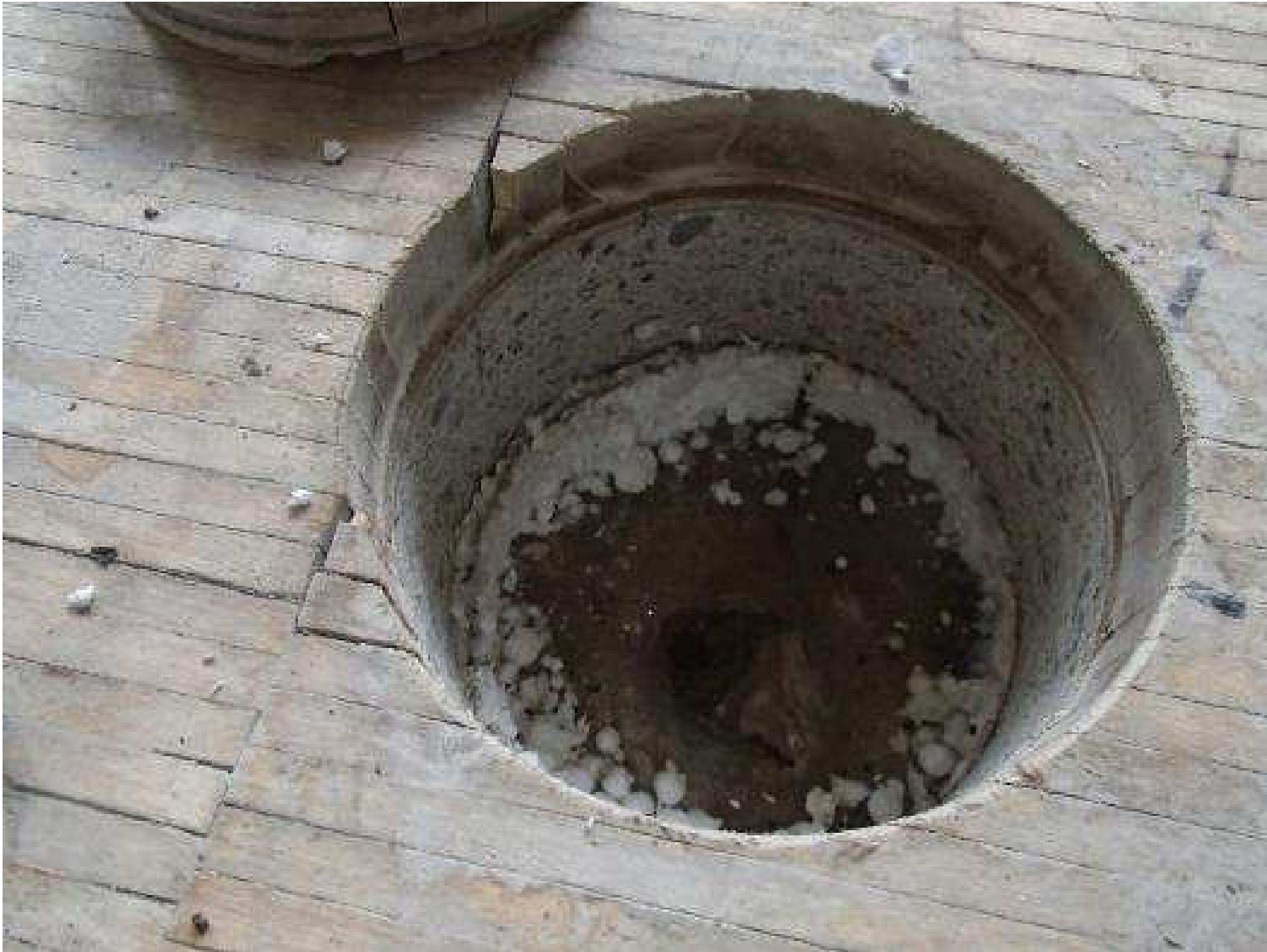
Kuva 88. Rakenneavaus, RAKL24, teknisen työn luokan alapohjarakenteeseen keskialueelta.
