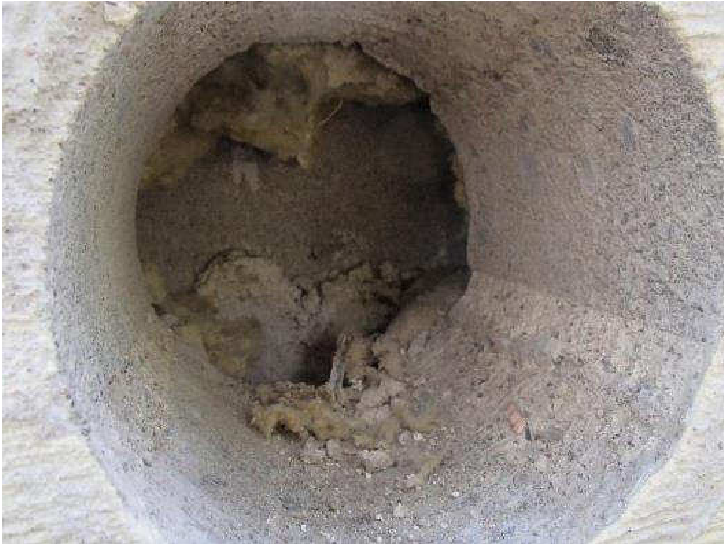
Kuva 49. Rakenneavaus, JS4Y, tiilimuurattuun julkisivuun.
