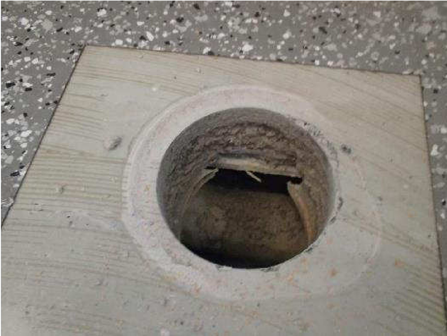
Kuva 33. Rakenneavaus, RAKL15, luokkahuoneen 20 alapohjarakenteeseen putkikanaalin kohdalta.
