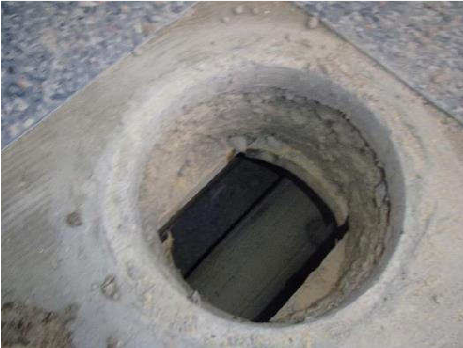
Kuva 29. Rakenneavaus, RAKL11, luokkahuoneen 15 alapohjarakenteeseen putkikanaalin kohdalta.
