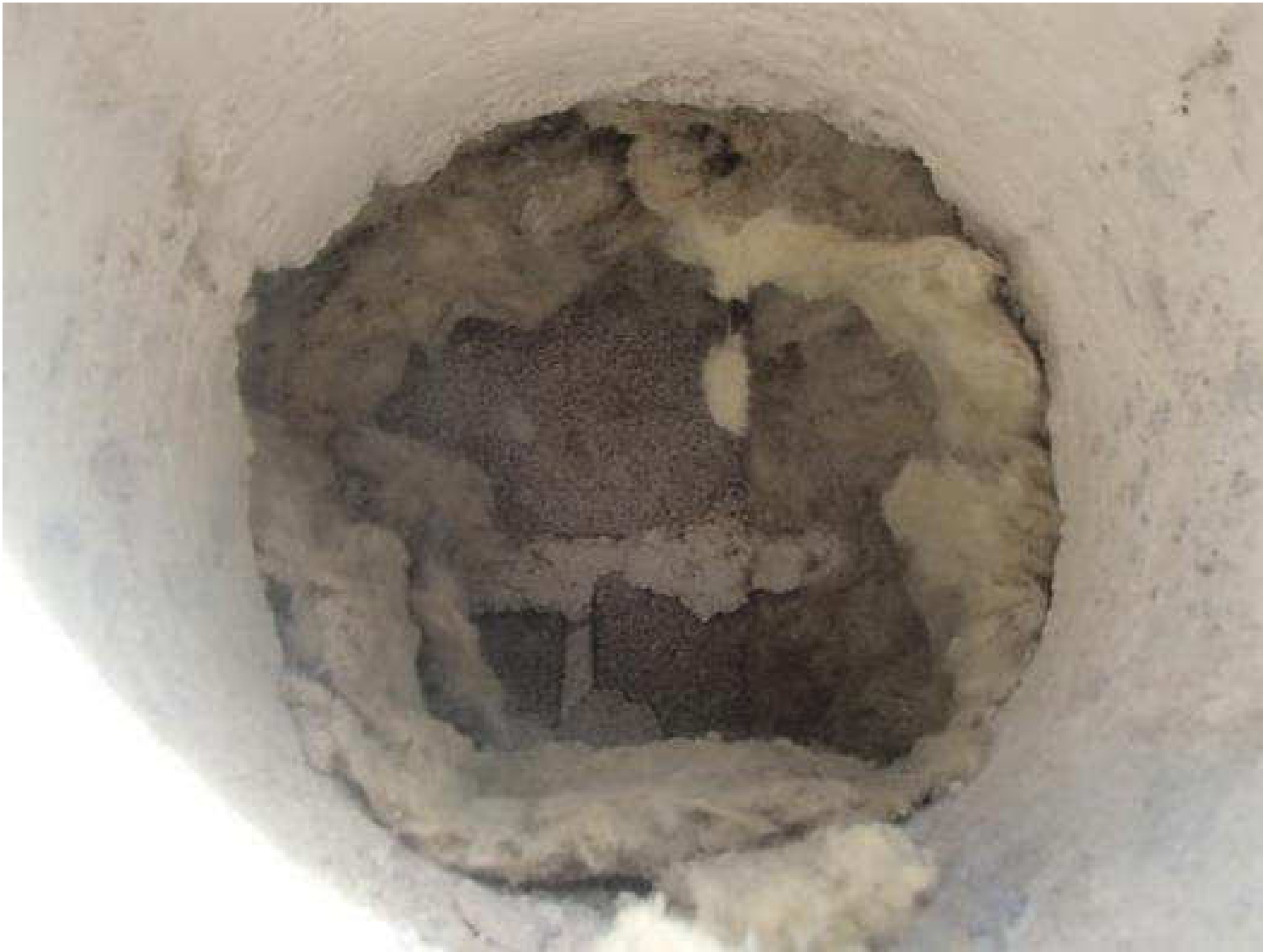
Kuva 12. Rakenneavauskohta, JS 14Y, julkisivuun.
