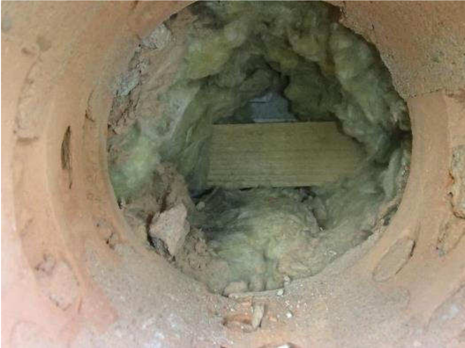
Kuva 91. Rakenneavaus, JS11Y, tiilimuurattuun julkisivuun.
