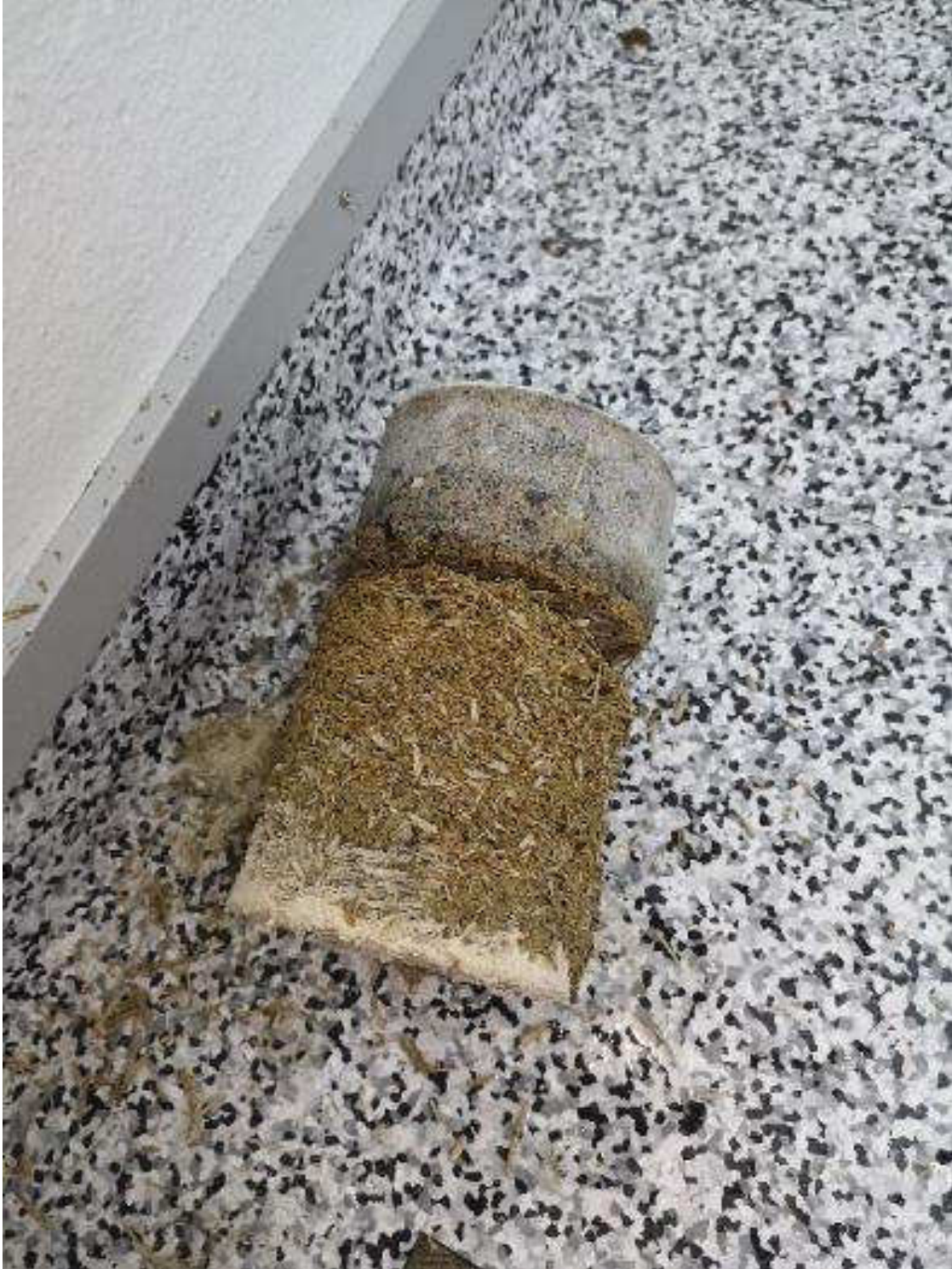
Kuva 87. Rakenneavaus, VJS2, luokkahuoneen 25 maanvastaiseen seinään (vanha sokkeli).
