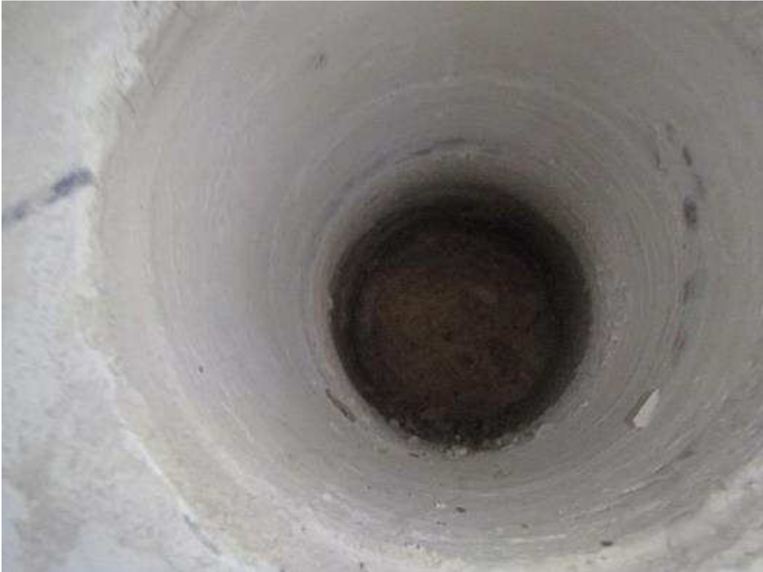
Kuva 94. Rakenneavaus, VJS3, opettajienhuoneen maanvastaiseen seinään (vanha sokkeli).
