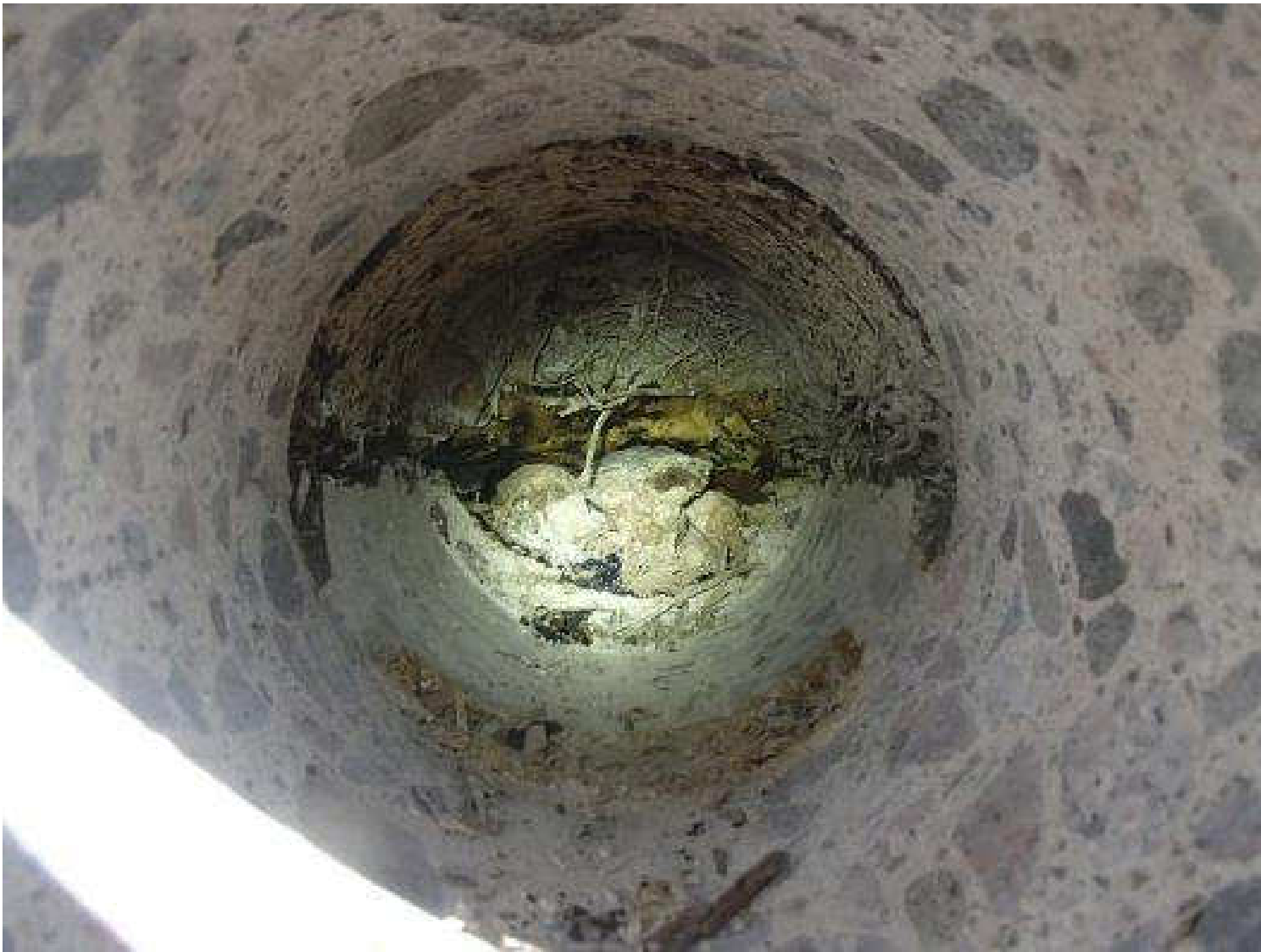
Kuva 55. Rakenneavaus, JS16, betonisokkeliin.
