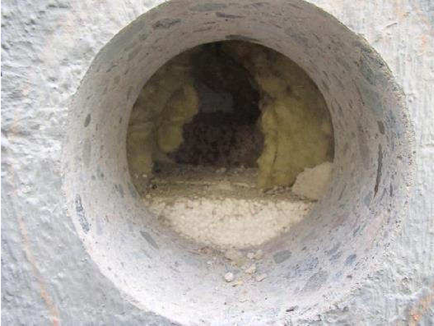
Kuva 92. Rakenneavaus, JS11A, tiilimuurattuun julkisivuun.
