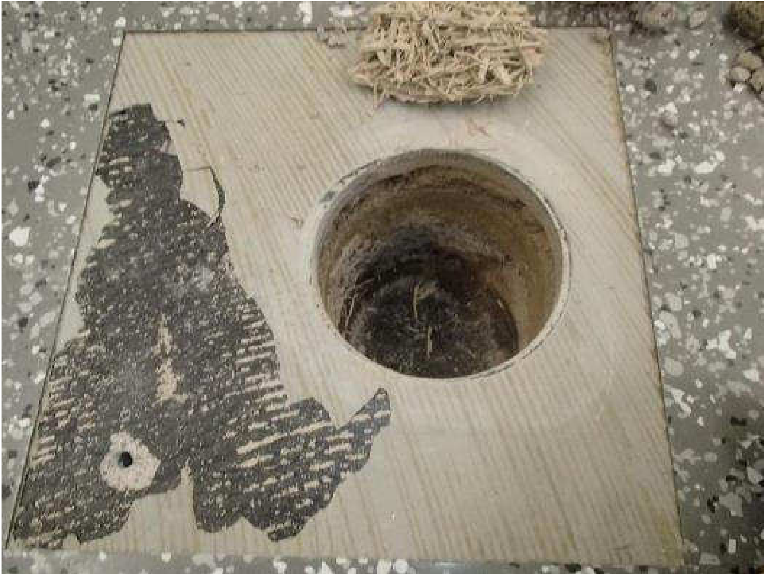
Kuva 32. Rakenneavaus, RAKL14, luokkahuoneen 20 alapohjarakenteeseen.
