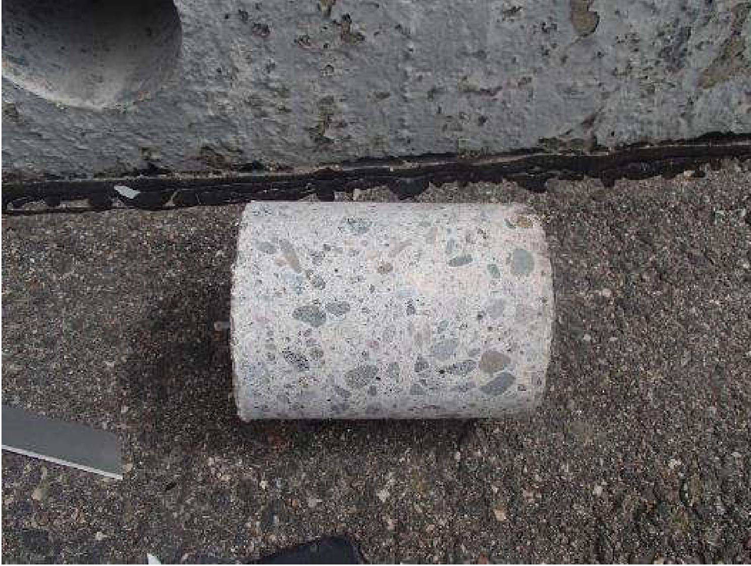
Kuva 79. Rakenneavaus, JS17, betonisokkeliin.
