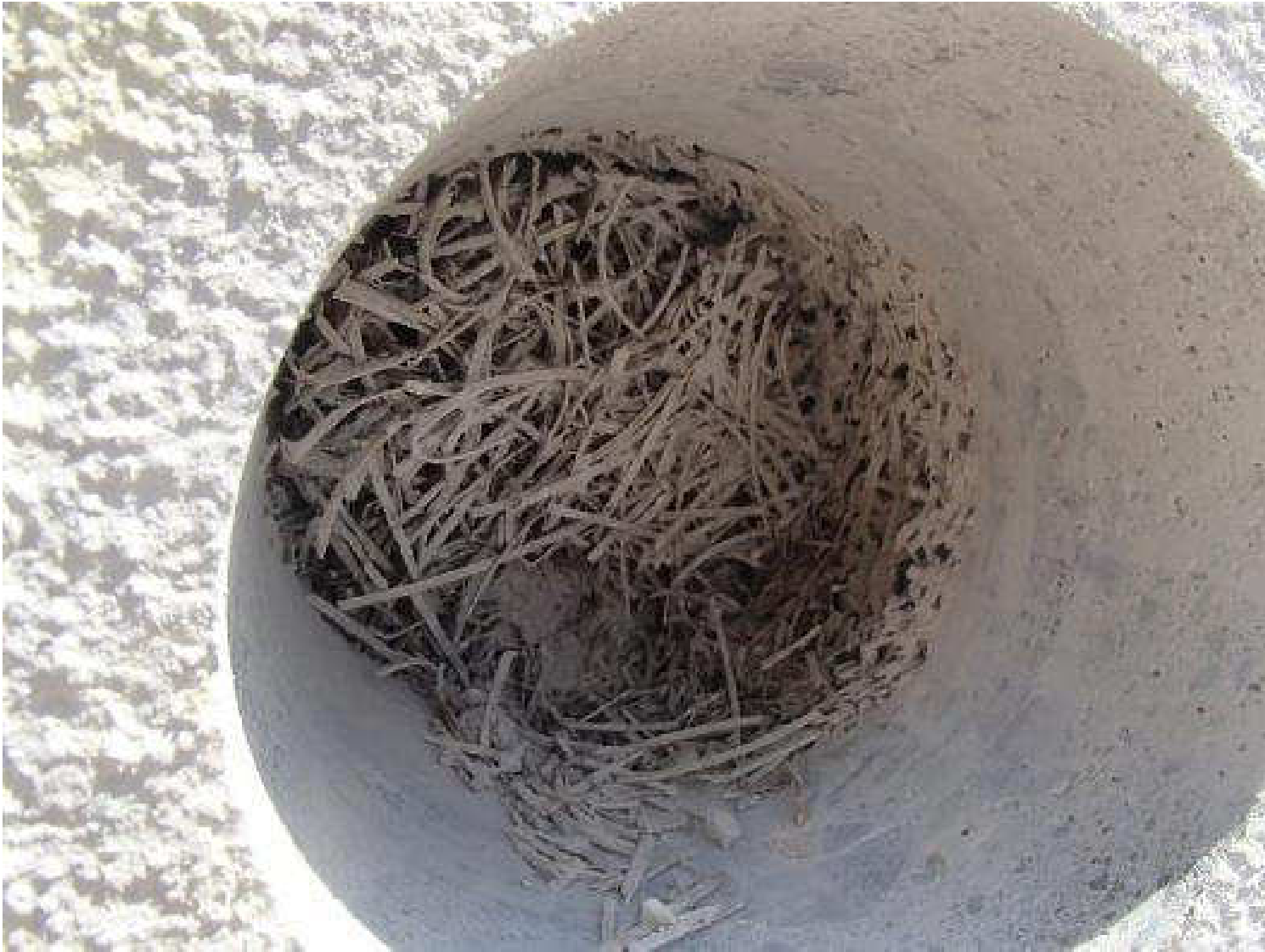
Kuva 51. Rakenneavaus, JS5, julkisivun betonielementtiin.
