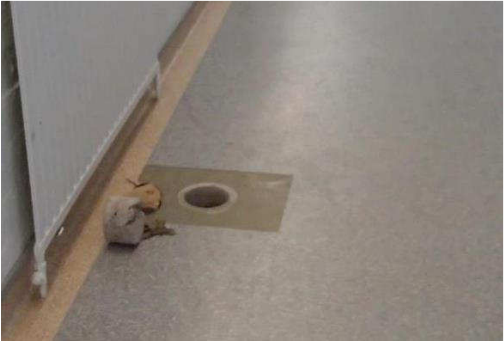
Kuva 74. Rakenneavaus, RAKL6, käytävän alapohjarakenteeseen käytävän reuna-alueelta.
