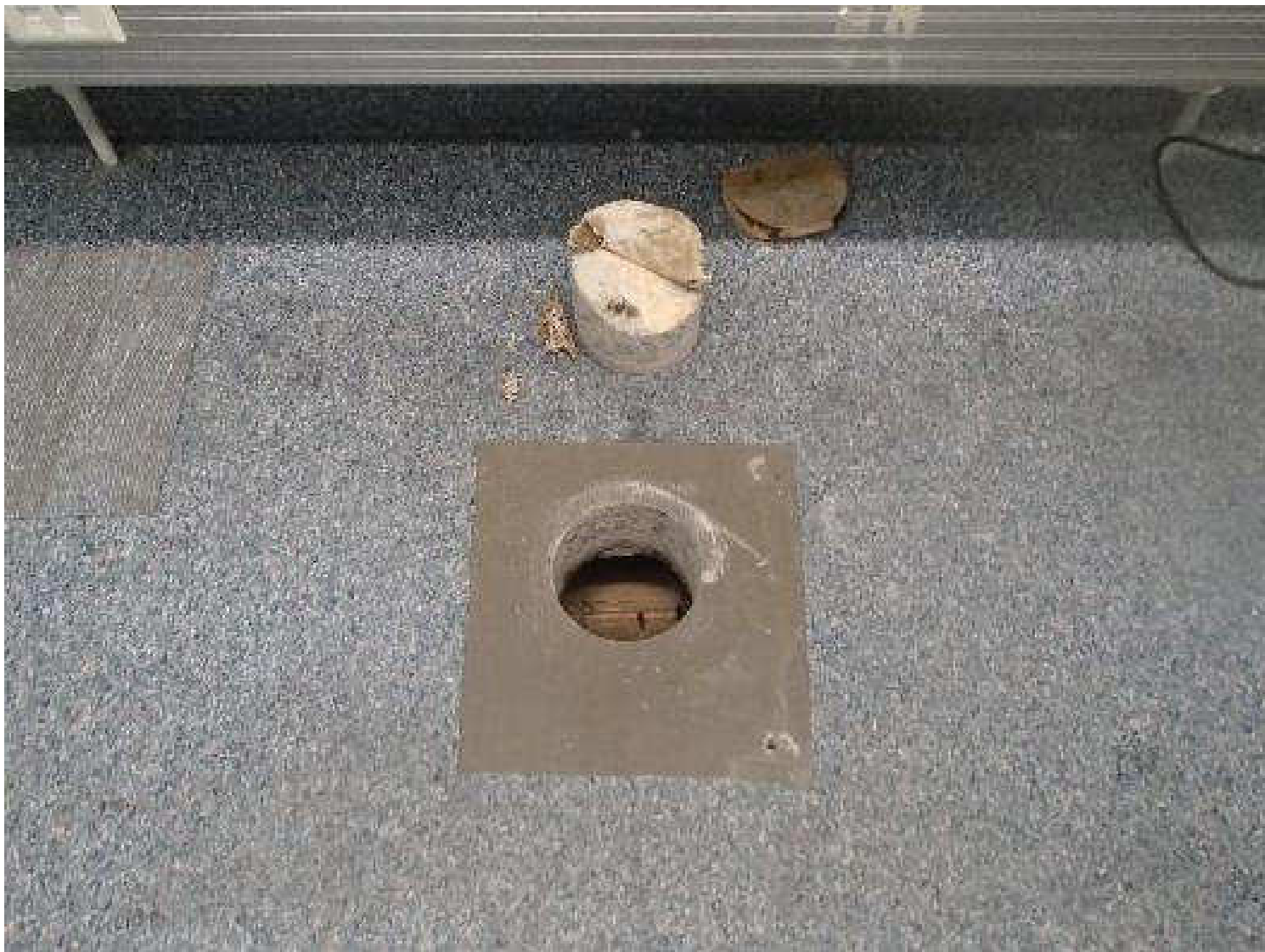
Kuva 69. Rakenneavaus, RAKL4, luokkahuoneen 5 alapohjarakenteeseen putkikanaalin kohdalta.
