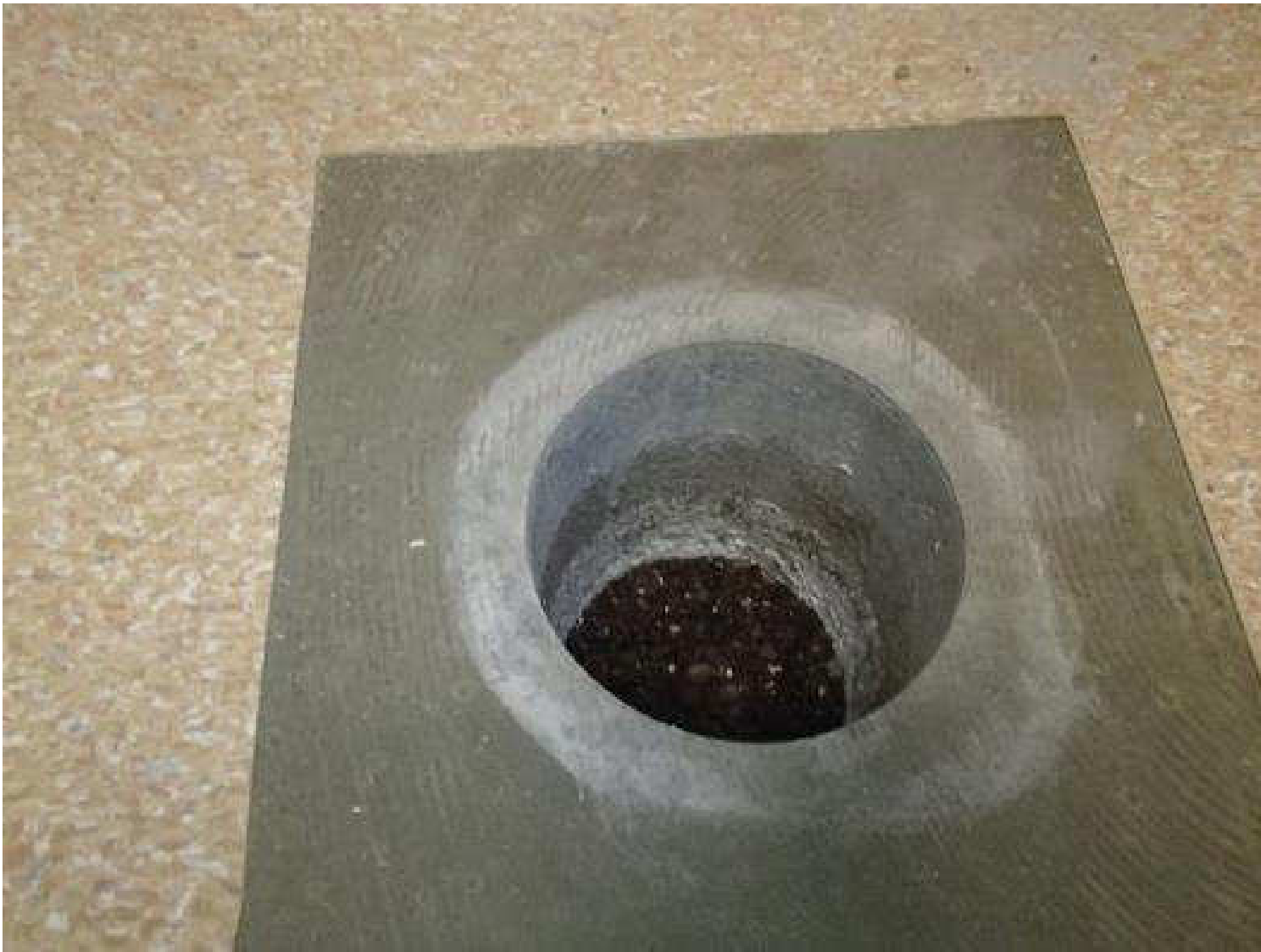
Kuva 96. Rakenneavaus, RAKL26, musiikkiluokan alapohjaan.
