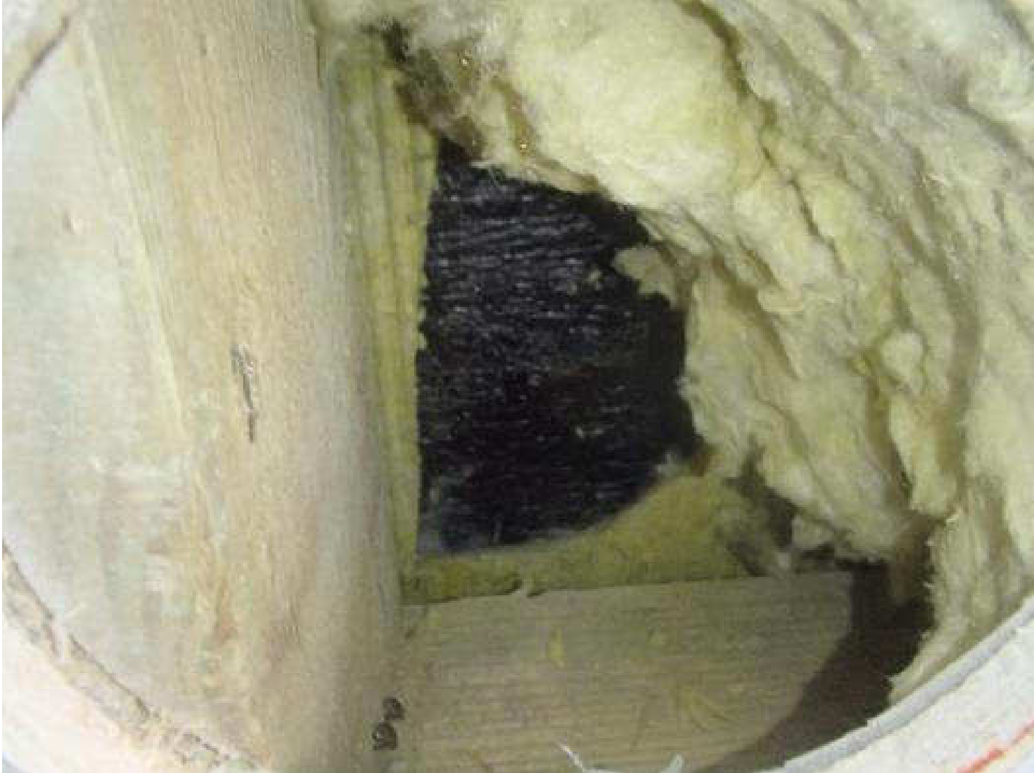
Kuva 59. Rakenneavauskohta, RAKS 3, käytävän ulkovaipparakenteeseen sisäkautta.
