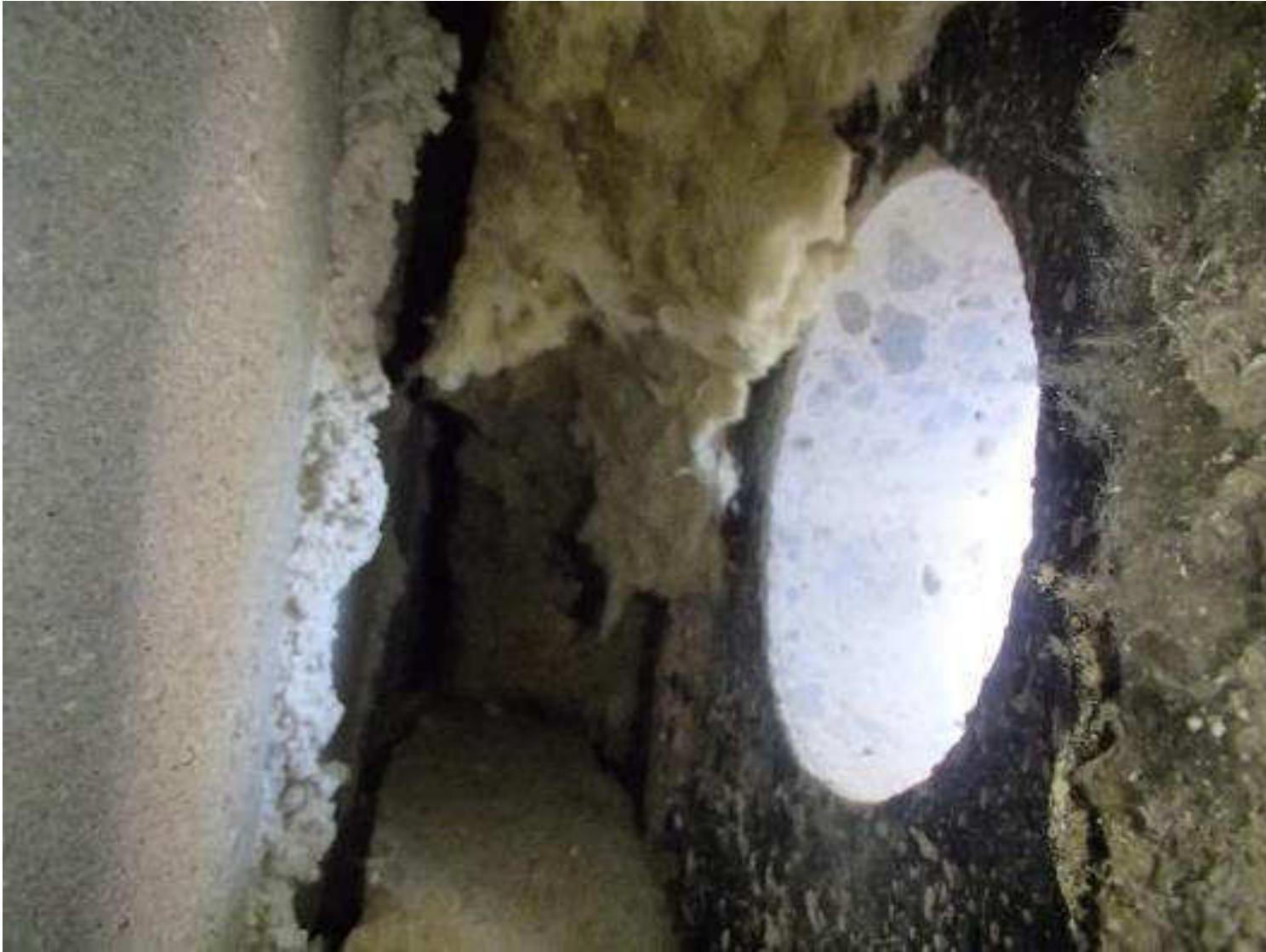
Kuva 54. Rakenneavaus, JS8A, betonisokkeliin.
