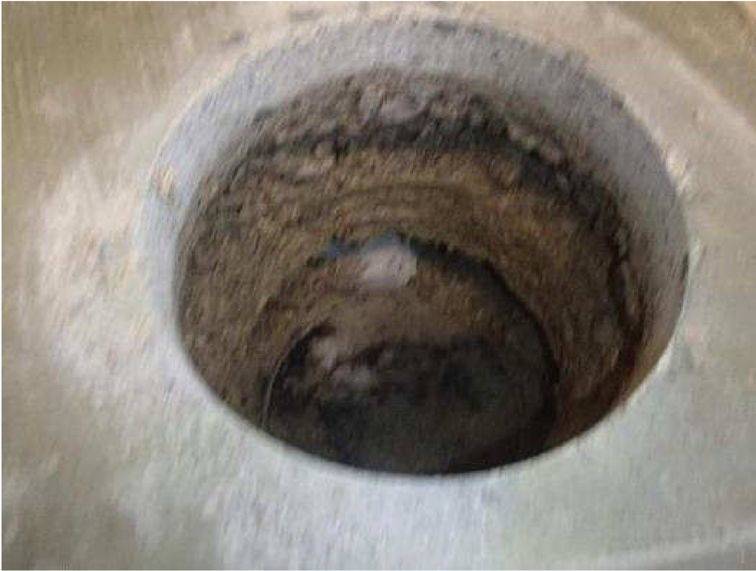
Kuva 30. Rakenneavaus, RAKL12, luokkahuoneen 17 alapohjarakenteeseen.
