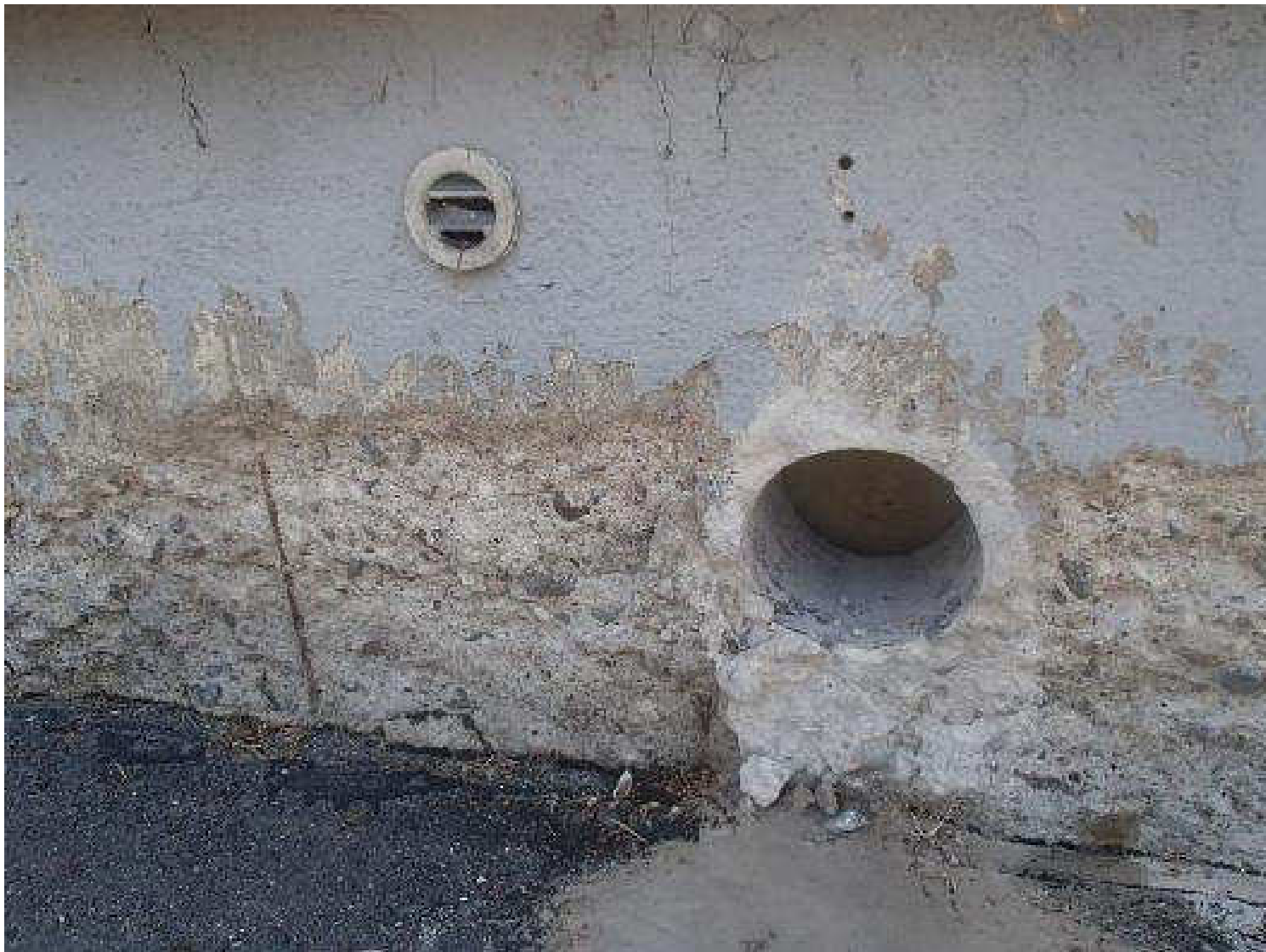
Kuva 5. Rakenneavaus, JS7, ulkovaipparakenteiden sokkeliin.
