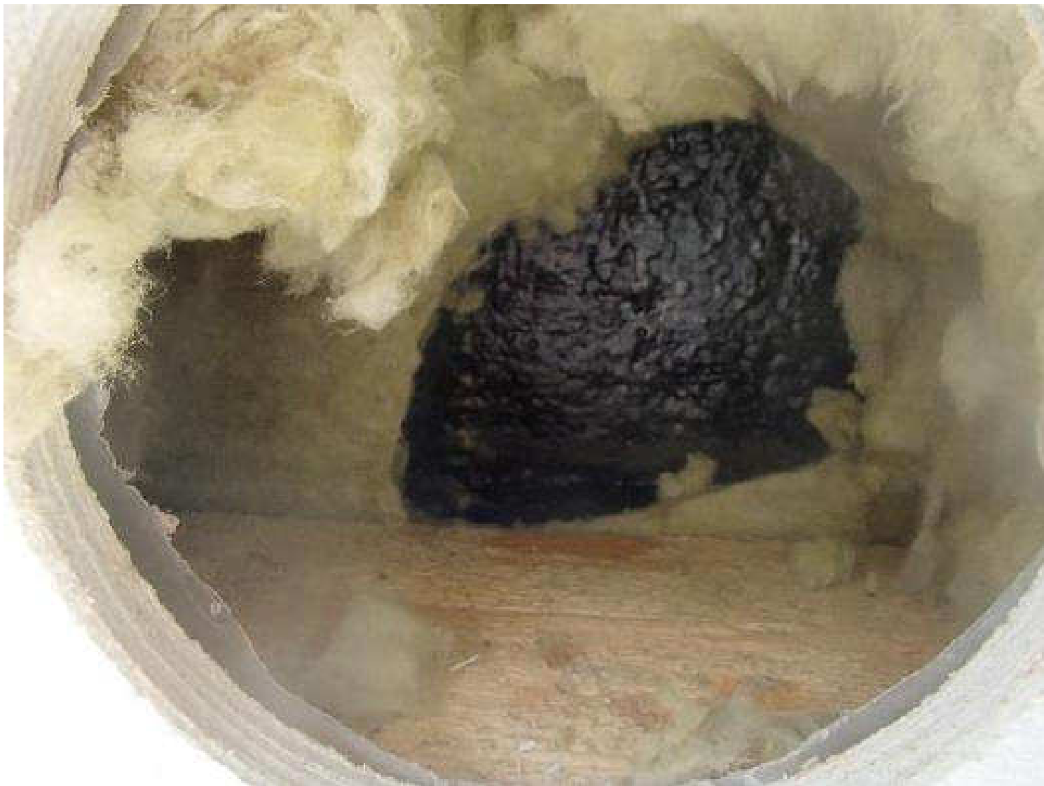
Kuva 58. Rakenneavauskohta, RAKS1, luokkahuoneen 8 ulkovaipparakenteeseen sisäkautta.
