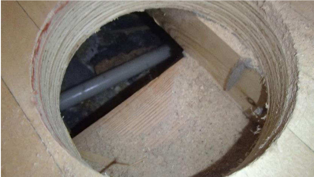
Kuva 15. Rakenneavaus liikuntasalin lattiarakenteeseen.
