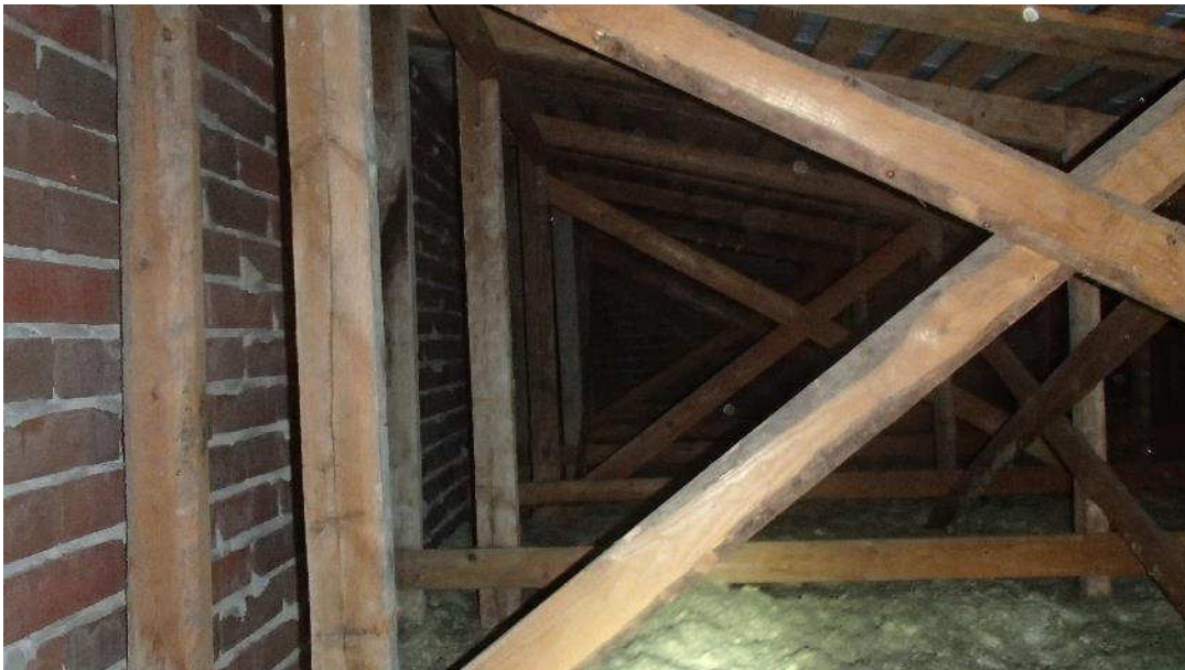
Kuva 14. Yleiskuva näyttämön yläpohjan tuulettuvasta tilasta.
