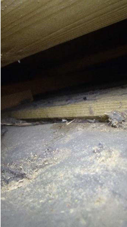
Kuva 17. Yleiskuva liikuntasalin rungosta.
