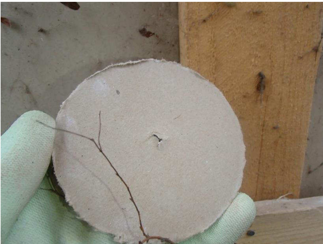
Kuva 4. Tuulensuojalevyn kartonkipinnoilla ei havaittu vaurioita.
