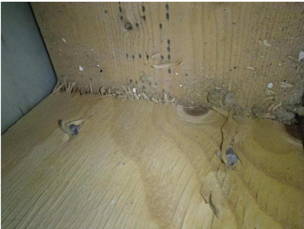
Kuva 6. Rakenneavausten yhteydessä rakenteissa ei havaittu vaurioita.
