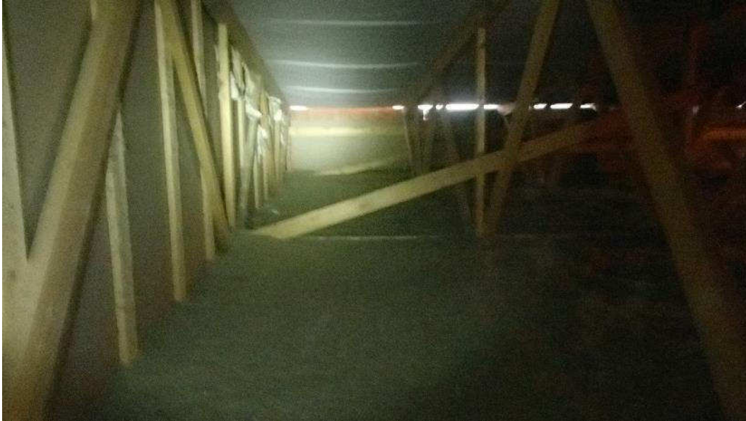
Kuva 13. Yleiskuva yläpohjan tuulettuvasta tilasta.
