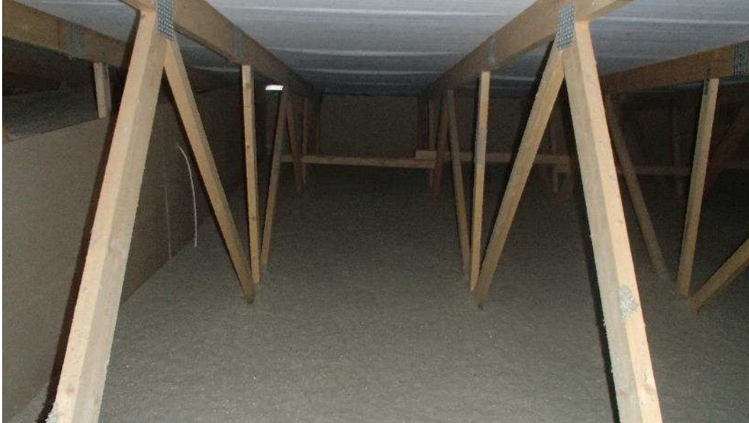
Kuva 15. Yleiskuva yläpohjan tuulettuvasta tilasta.
