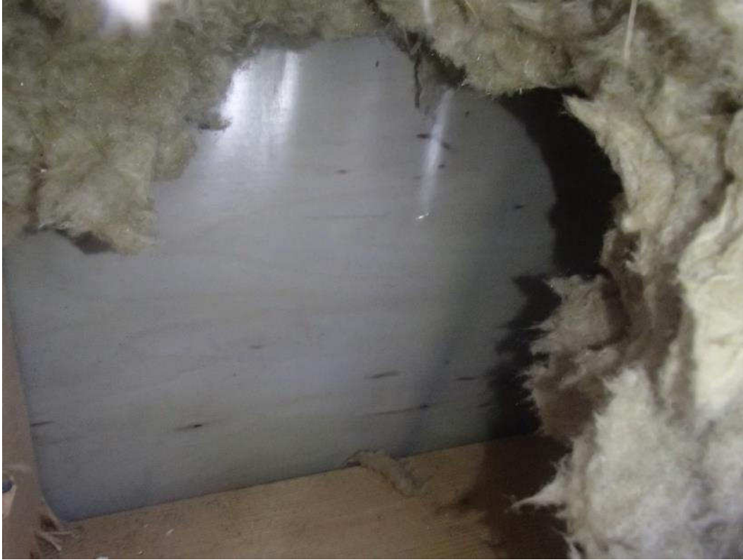
Kuva 5. Rakenneavausten yhteydessä rakenteissa ei havaittu vaurioita.
