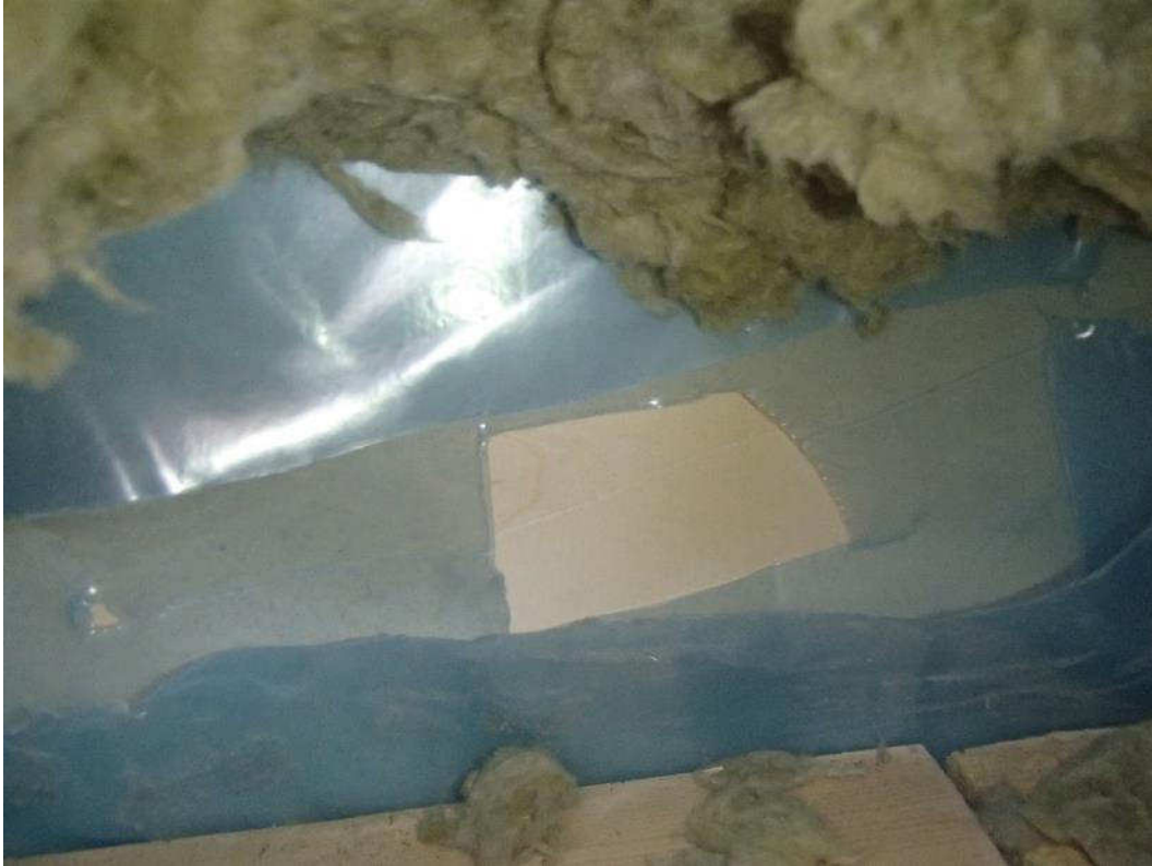
Kuva 7. Rakenneavausten yhteydessä rakenteissa ei havaittu vaurioita.
