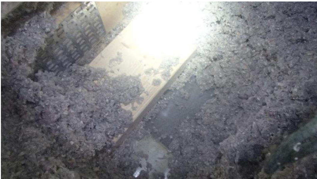
Kuva 14. Yläpohjan rakenteissa ei havaittu vaurioita pistokoeluontoisen tarkastuksen perusteella.
