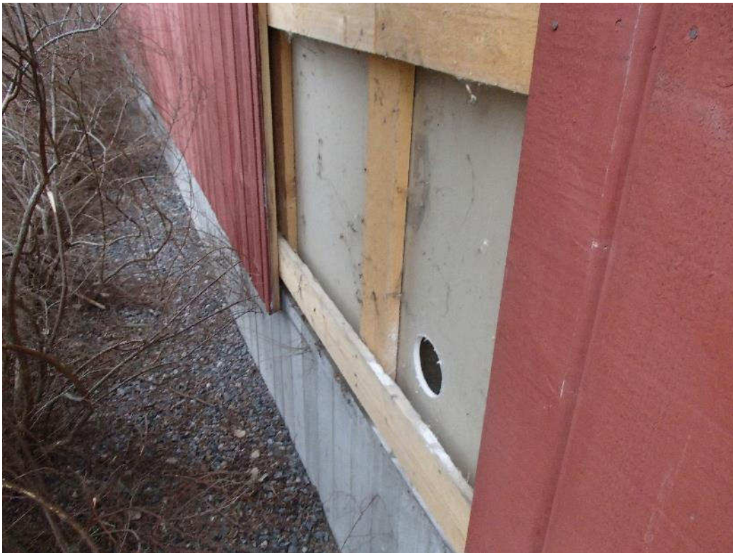
Kuva 2. Liikuntasalin ulkovaipan ristiinkoolaus ja tuulesuojalevy.
