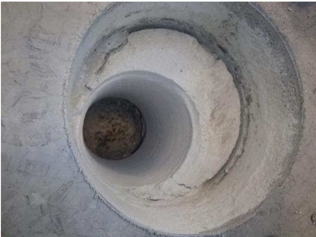
Kuva 61. Rakenneavaus alapohjaan luokkahuoneen keskiosalta.
