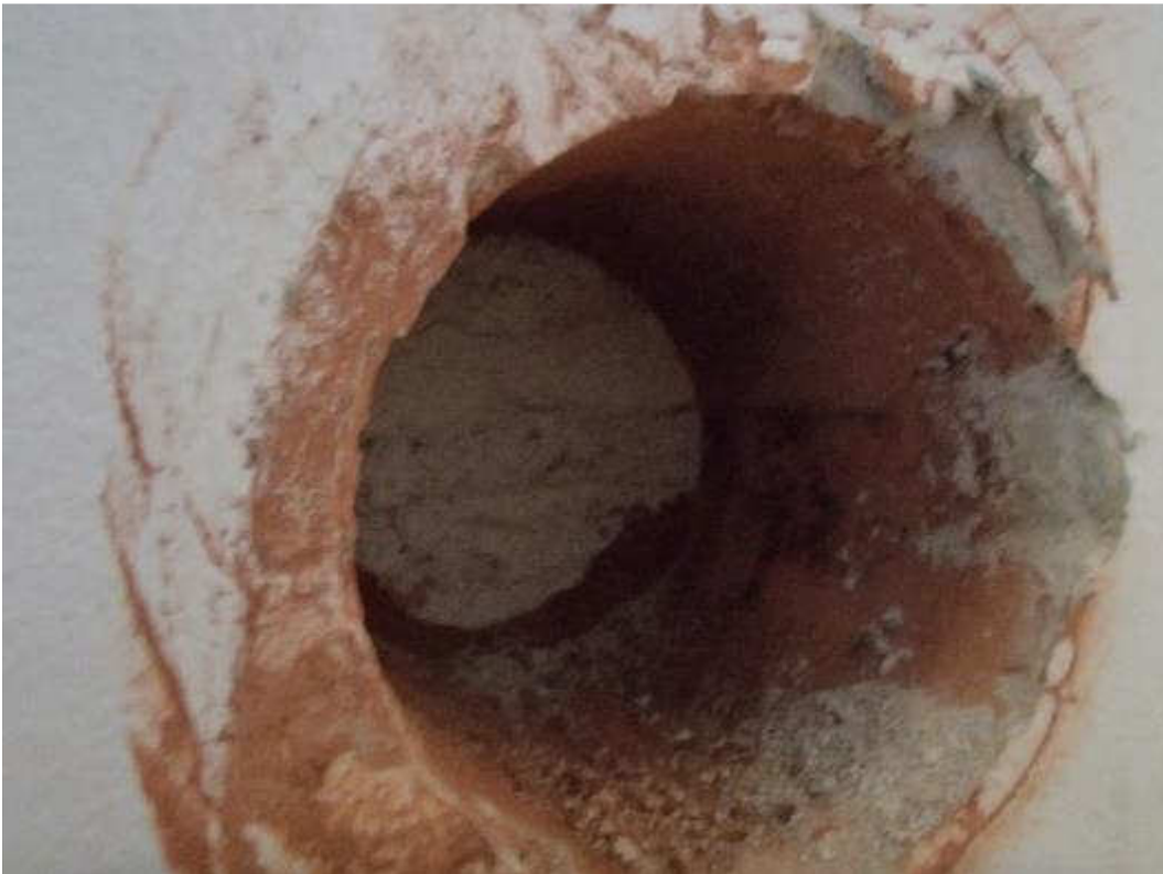
Kuva 4. Rakenneavaus ulkovaipparakenteeseen sisäkautta.
