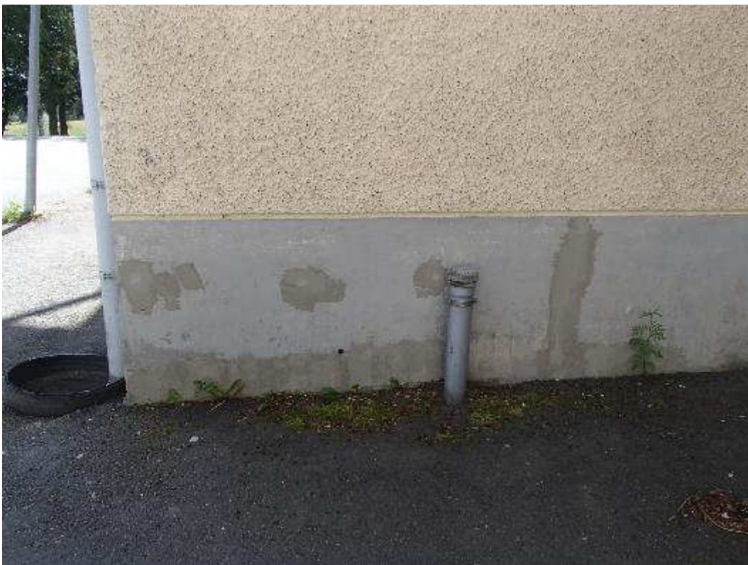
Kuva 16. Sokkelipintojen halkeamia on korjailtu laastilla.
