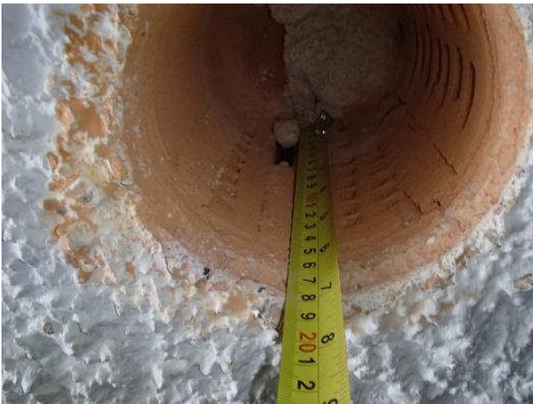
Kuva 2. Rakenneavaus julkisivuun ulkokautta.
