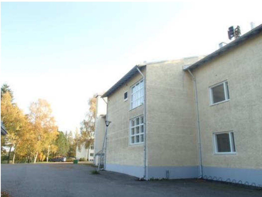
Kuva 18. Rakennuksen sokkelit on kesän aikana pinnoitettu.
