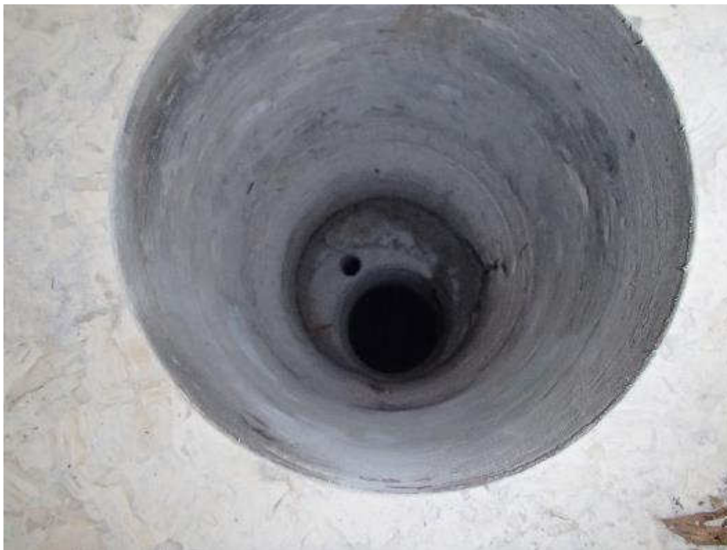
Kuva 59. Rakenneavaus esikoulun alapohjaan.
