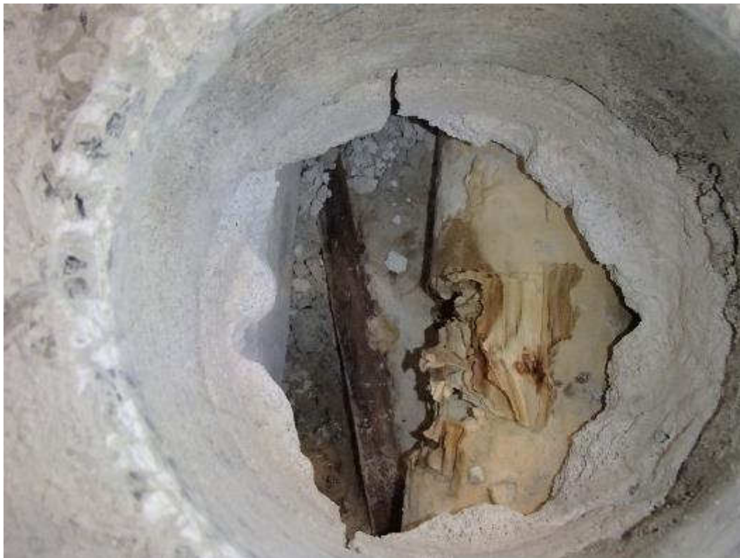
Kuva 64. Alapohjan rakenneavauksissa reuna-alueilla havaittiin eristetyt lämpöputkistot, jotka oli asennettu lankkujen päälle.
