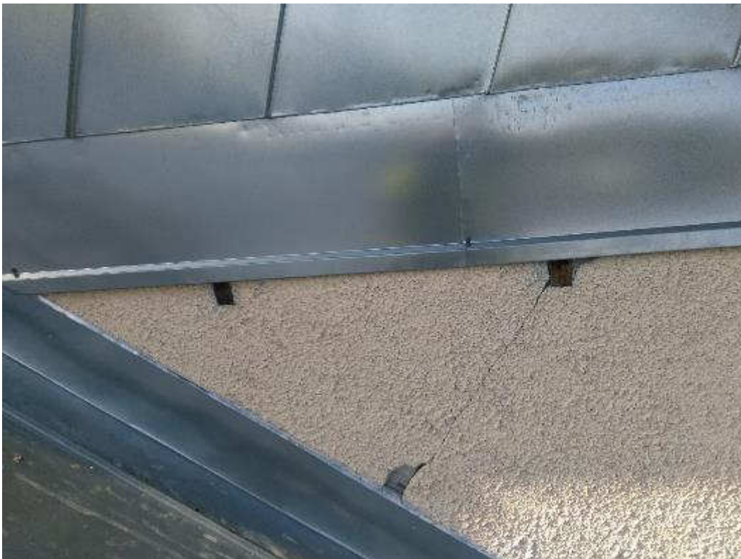
Kuva 28. Rakennuksen päädyssä on pellityksen alle jätetty vanhat vesikaton runkokuut esiin.
