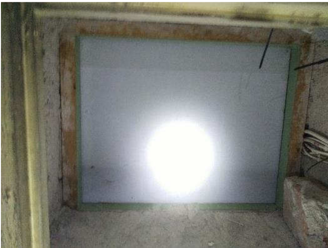
Kuva 33. Vanhan liikuntasalin yläpuoleisesta tuulettuvasta tilasta on suora yhteys tekstiilityöluokkaan.
