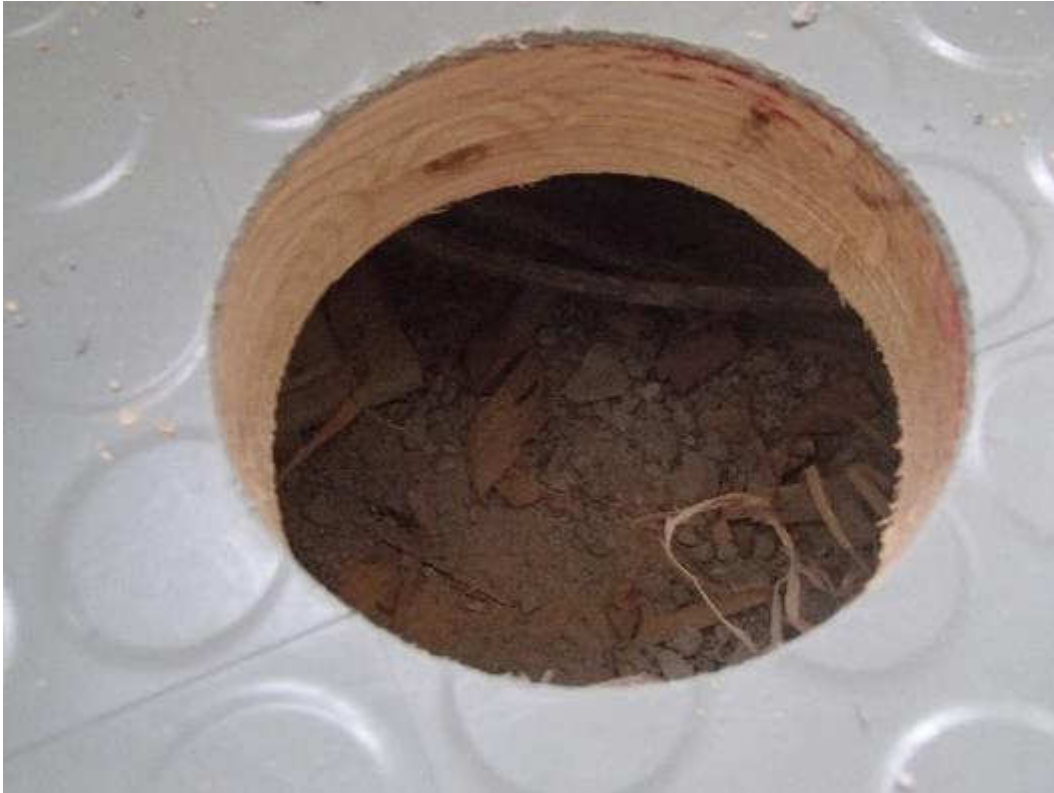
Kuva 52. Rakenneavaus puukäsityöluokan välipohjaan.
