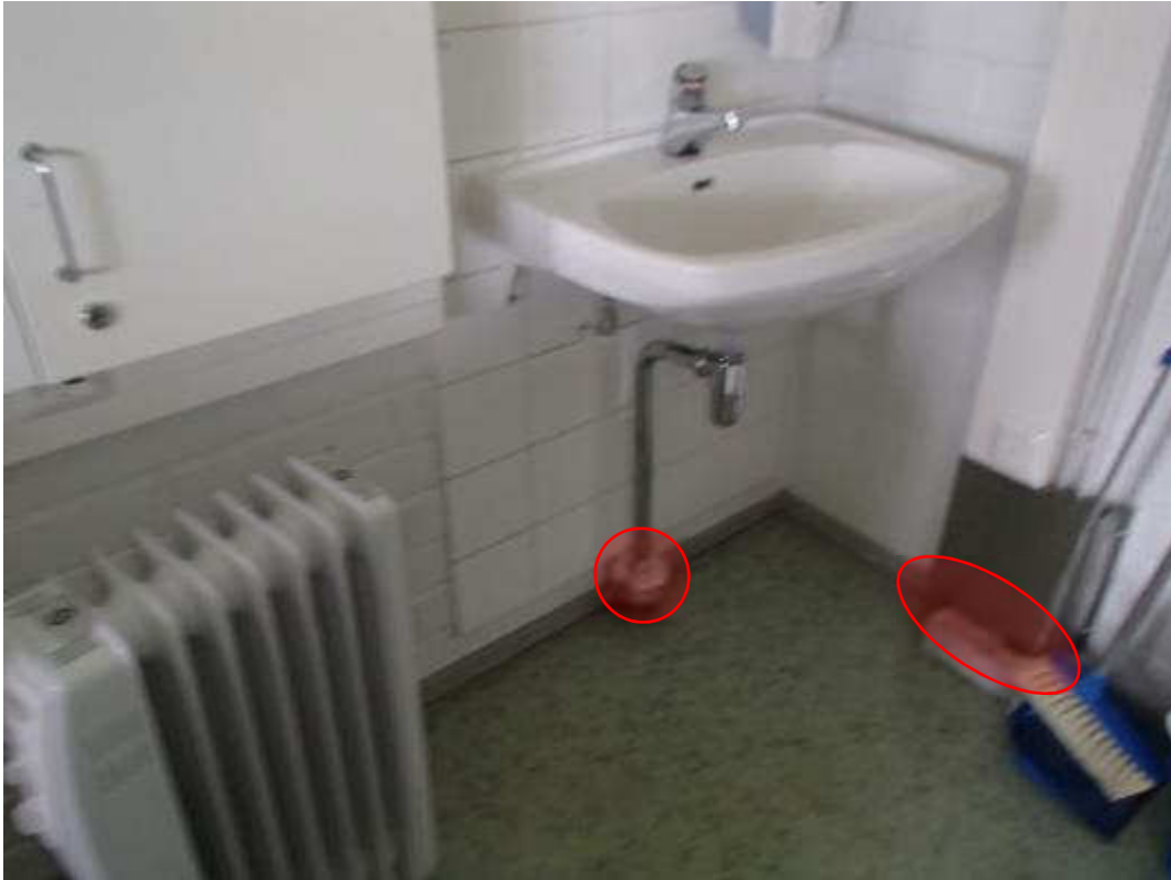
Kuva 140. Alapohjan tyypillisimmät epätiiveyskohdat.
