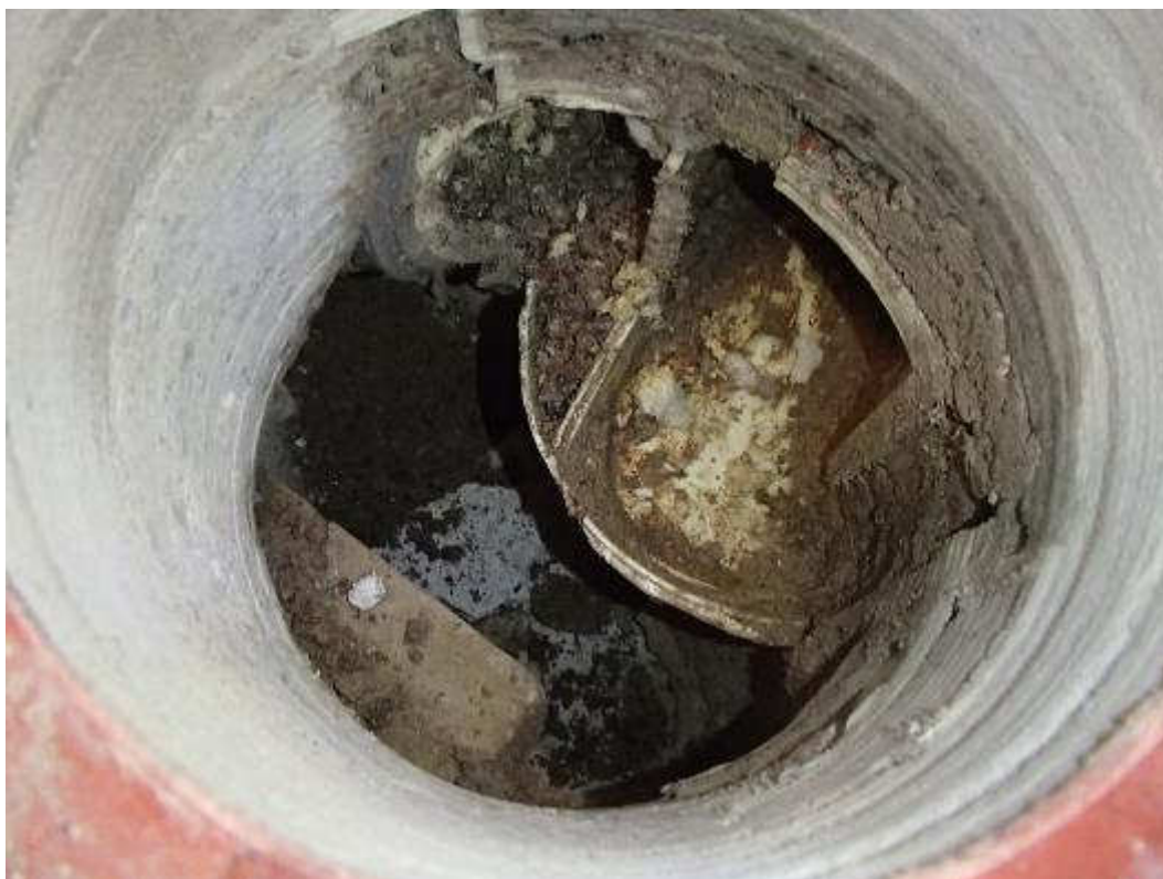
Kuva 40. Rakenneavaus esikoulun välipohjan entisen suihkutilan kohdalta.
