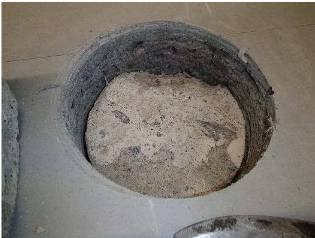
Kuva 48. Rakennevaus terveydenhoitajan huoneen kohdalta välipohjaan.
