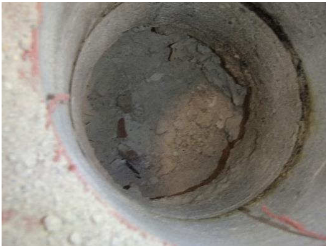
Kuva 41. Rakenneavaus esikoulun välipohjaan entisen suihkutilan kohdalta.
