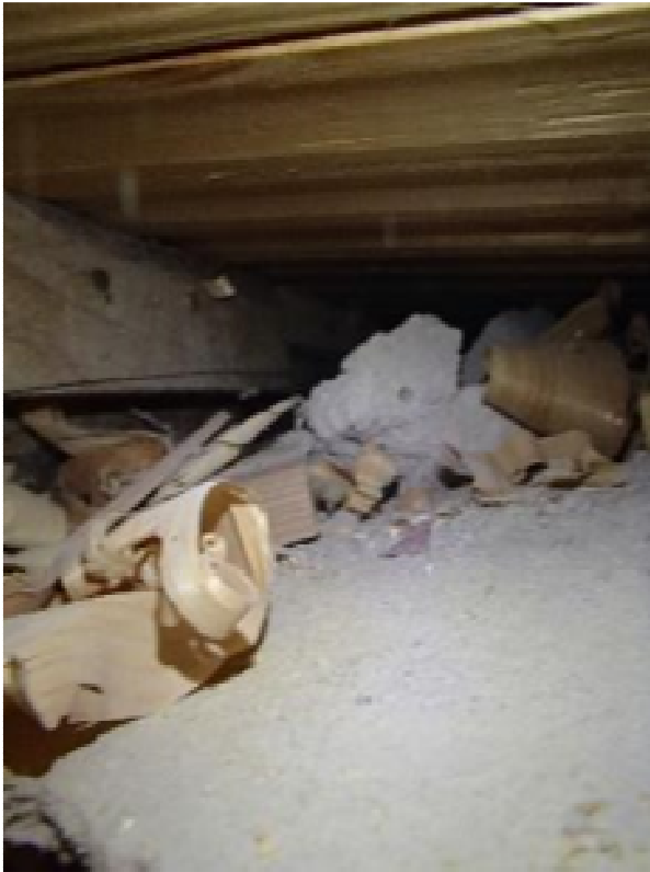
Kuva 46. Rakenneavaus entisen liikuntasalin välipohjaan.
