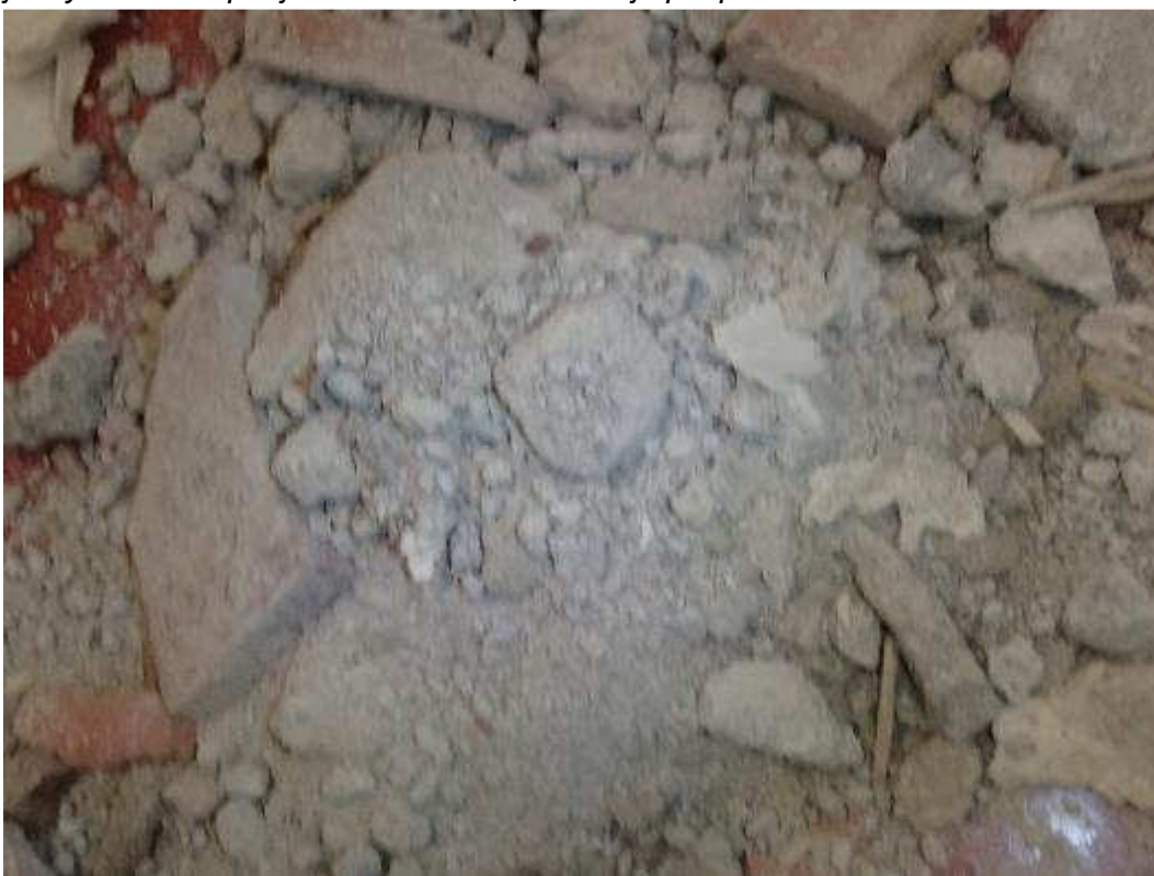
Kuva 56. Esikoulun välipohjan täyteenä on betonia, hiekka, tiilen palasia ja puupalasia.
