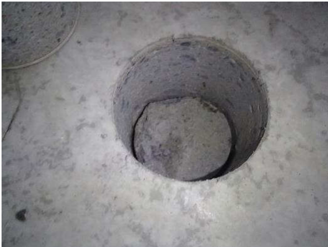
Kuva 109. Rakenneavaus alapohjarakenteeseen.
