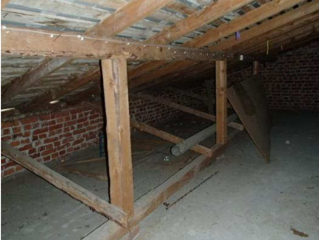
Kuva 22. Yleiskuva tuulettuvasta vintttilasta.
