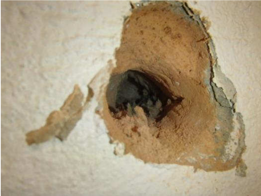
Kuva 63. Rakenneavaus maanvastaiseen seinään.
