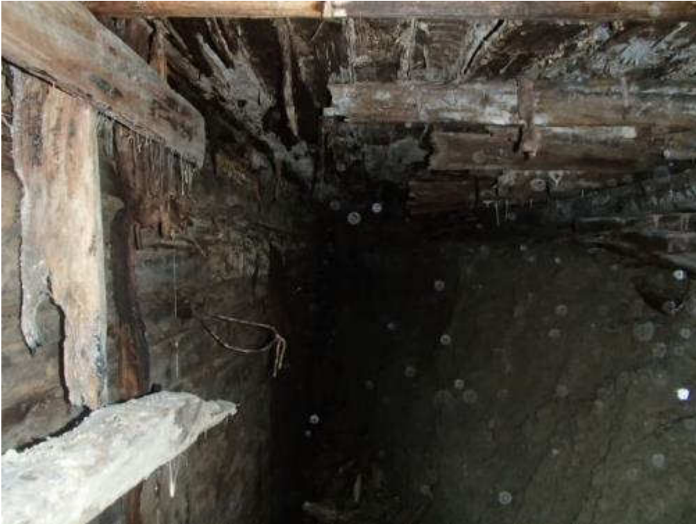
Kuva 70. Yleiskuva esikoulun alapuoleisesta ryömintätilasta.
