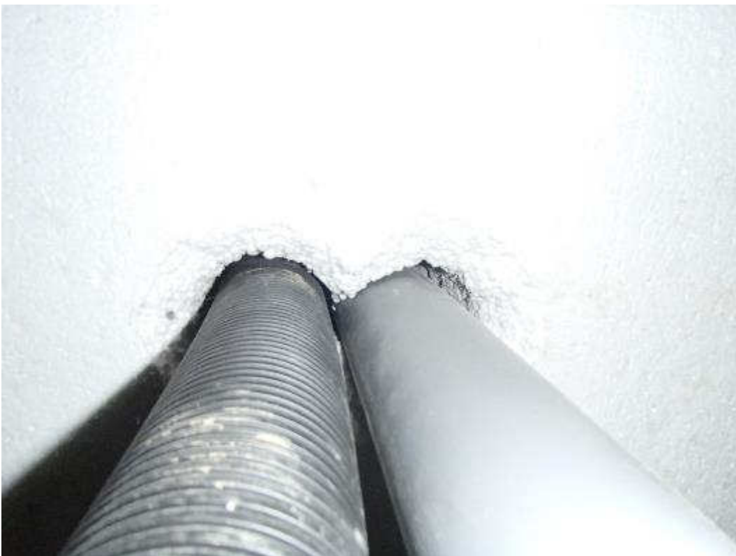
Kuva 122. Alapohjan läpiviennit eivät ole tiiviitä.
