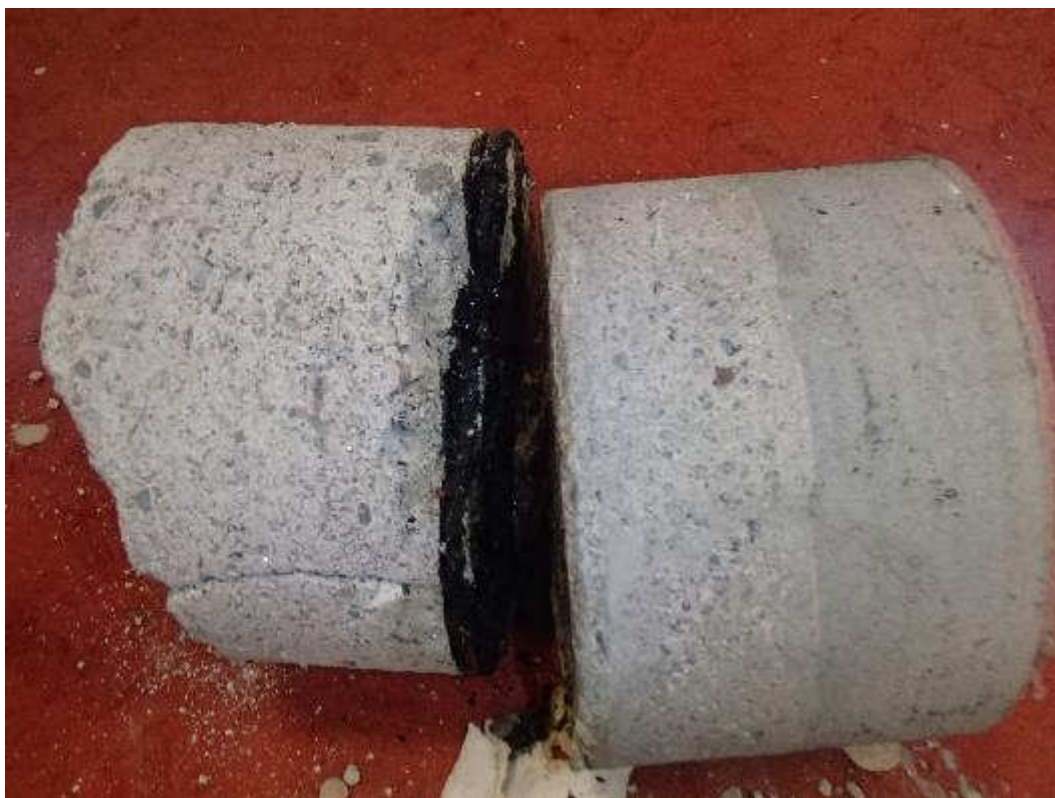
Kuva 42. Rakenneavaus esikoulun välipohjaan entisen suihkutilan kohdalta.
