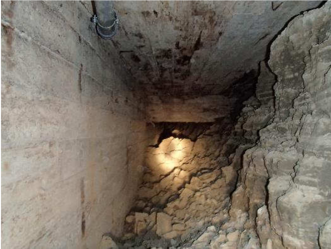
Kuva 68. Yleiskuva opettajienhuoneen alapuoleisesta ryömintätilasta.
