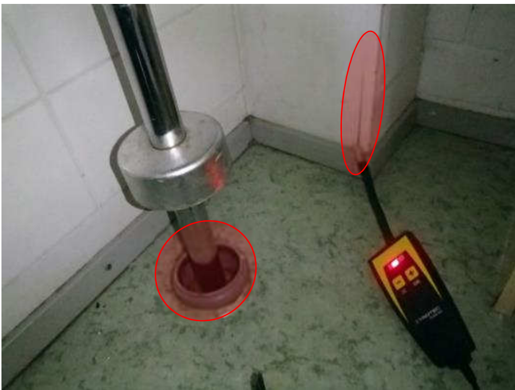
Kuva 141. Alapohjan tyypillisimmät epätiiveyskohdat.
