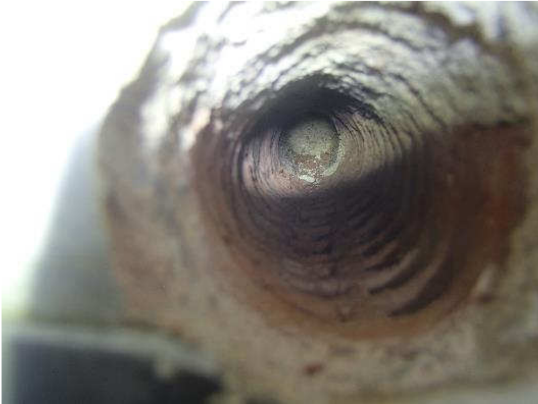
Kuva 5. Rakenneavaus ulkovaipparakenteeseen sisäkautta sokkelin taustalta.
