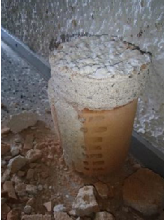
Kuva 3. Rakenneavaus julkisivuun ulkokautta.
