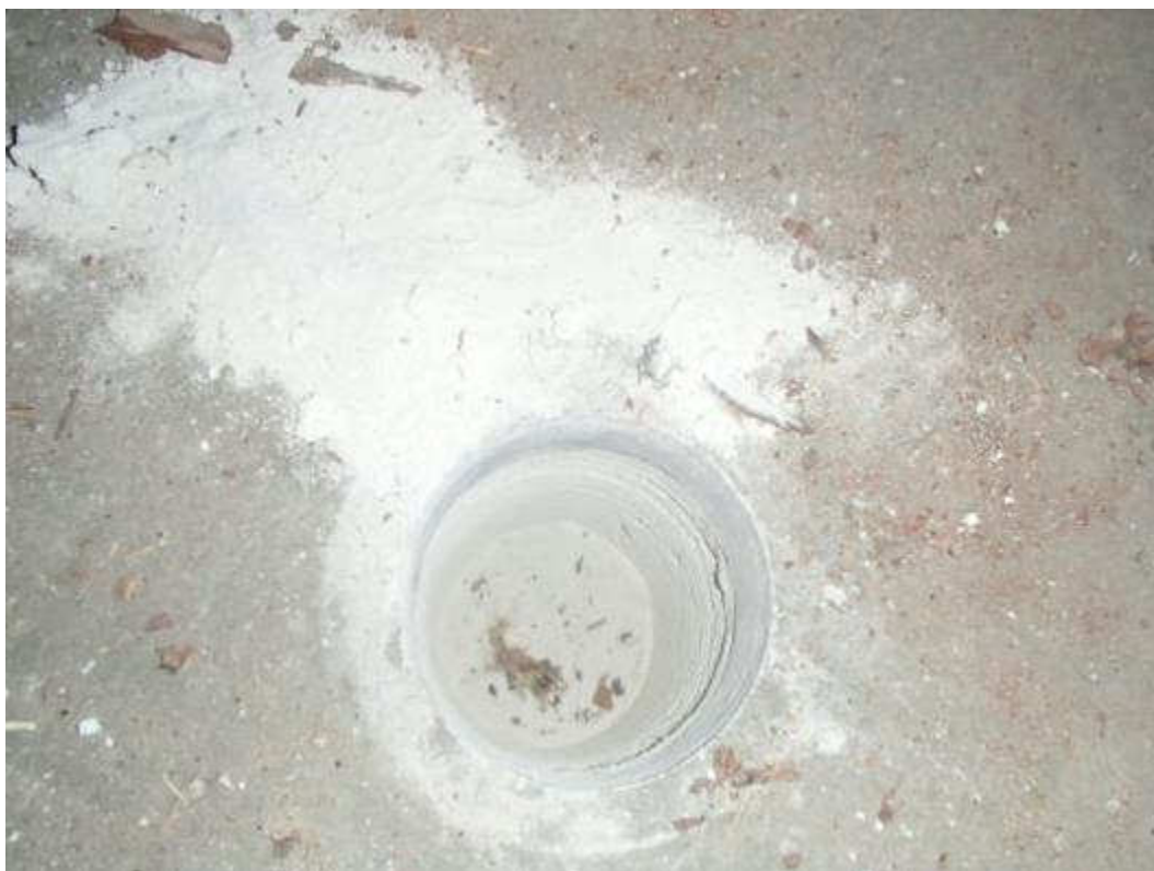
Kuva 23. Rakenneavaus yläpohjarakenteeseen.
