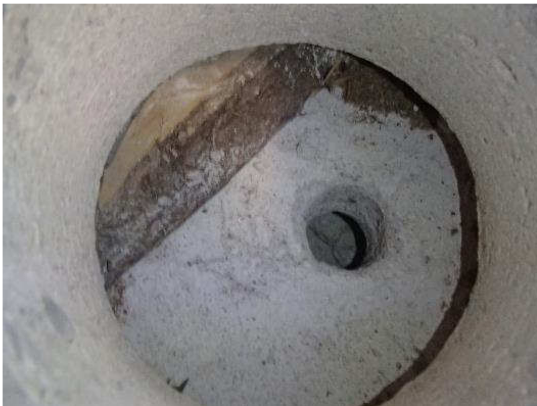
Kuva 43. Rakennearaus esikoulun välipohjaan entisen pukuhuoneen kohdalta.
