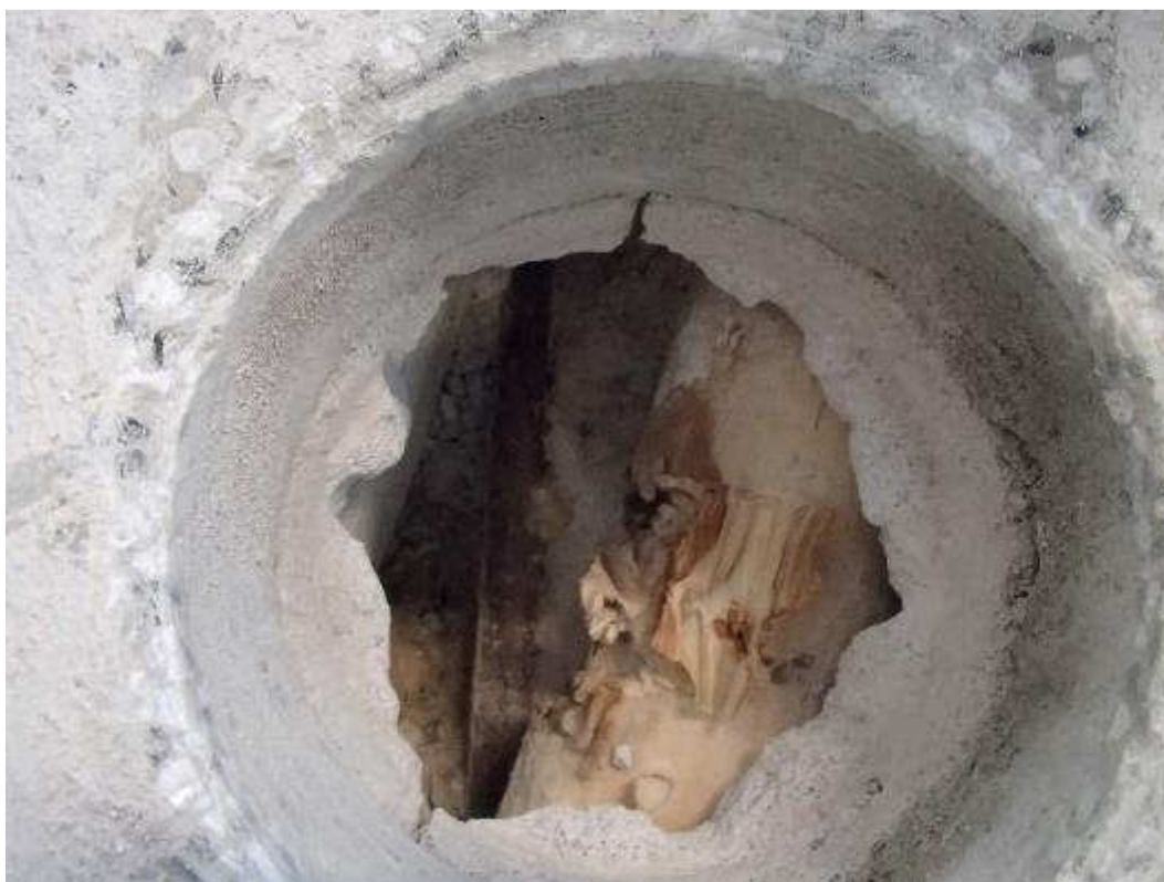
Kuva 62. Rakenneavaus 1.kerroksen käytävän alapohjaan.
