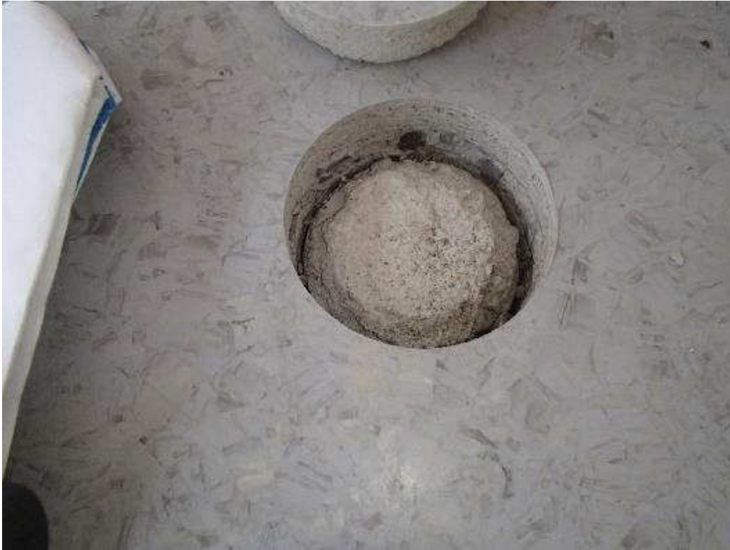
Kuva 50. Rakenneavaus luokan 8 kohdalta välipohjaan.
