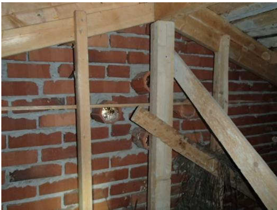
Kuva 97. Yleiskuva tuulettuvasta vinttitilasta.
