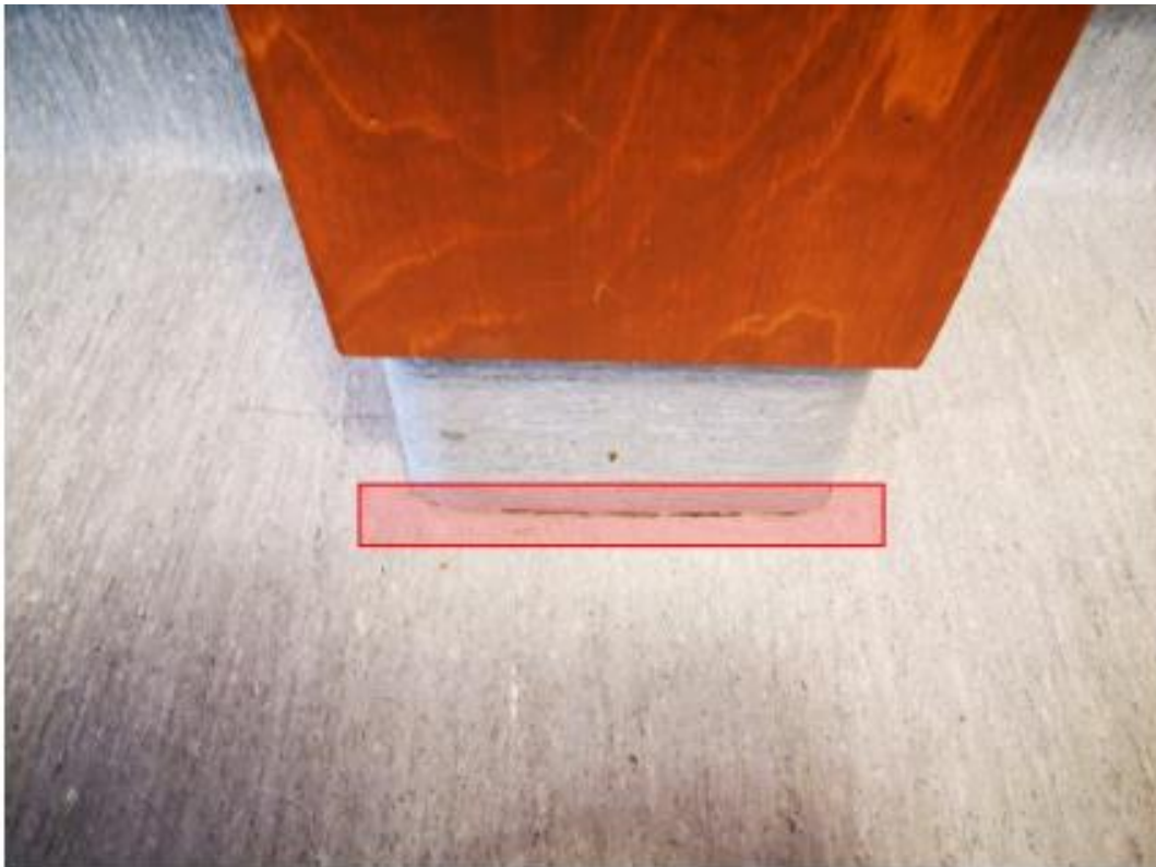
Kuva 17. Ilmavuotoja havaittiin avautuneiden mattosaumojen kautta.
