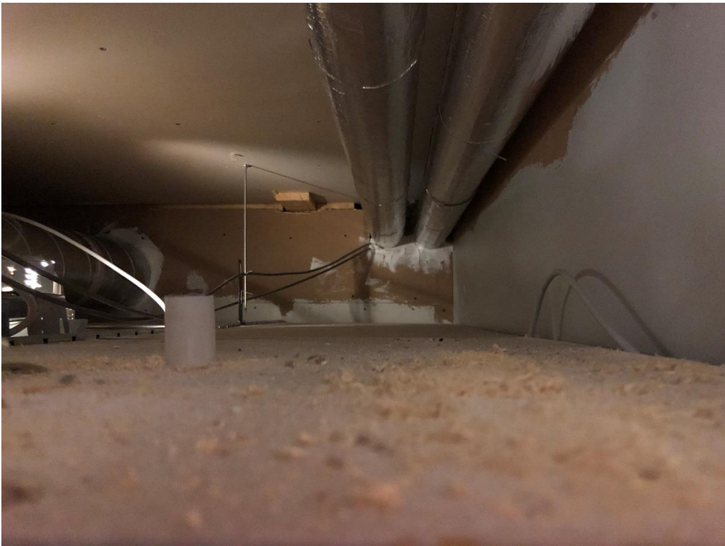
Kuva 23. Alakattolevyjen yläpuolella rakennuksen 2008 ja 2016 liittymäkohdalla ei havaittu vesijälkiä ja tulppaukset todettiin pitäviksi.
