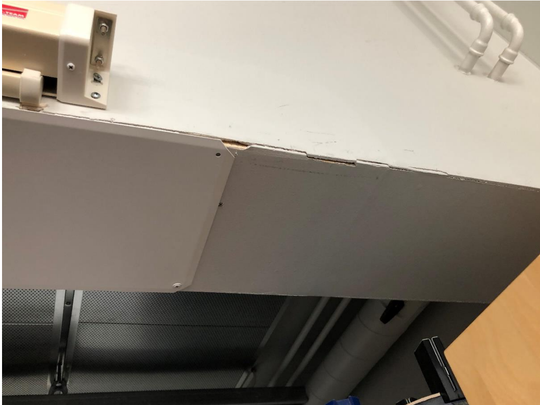
Kuva 20. Teknisen työn luokkaan asennettu tarkastusluukku.
