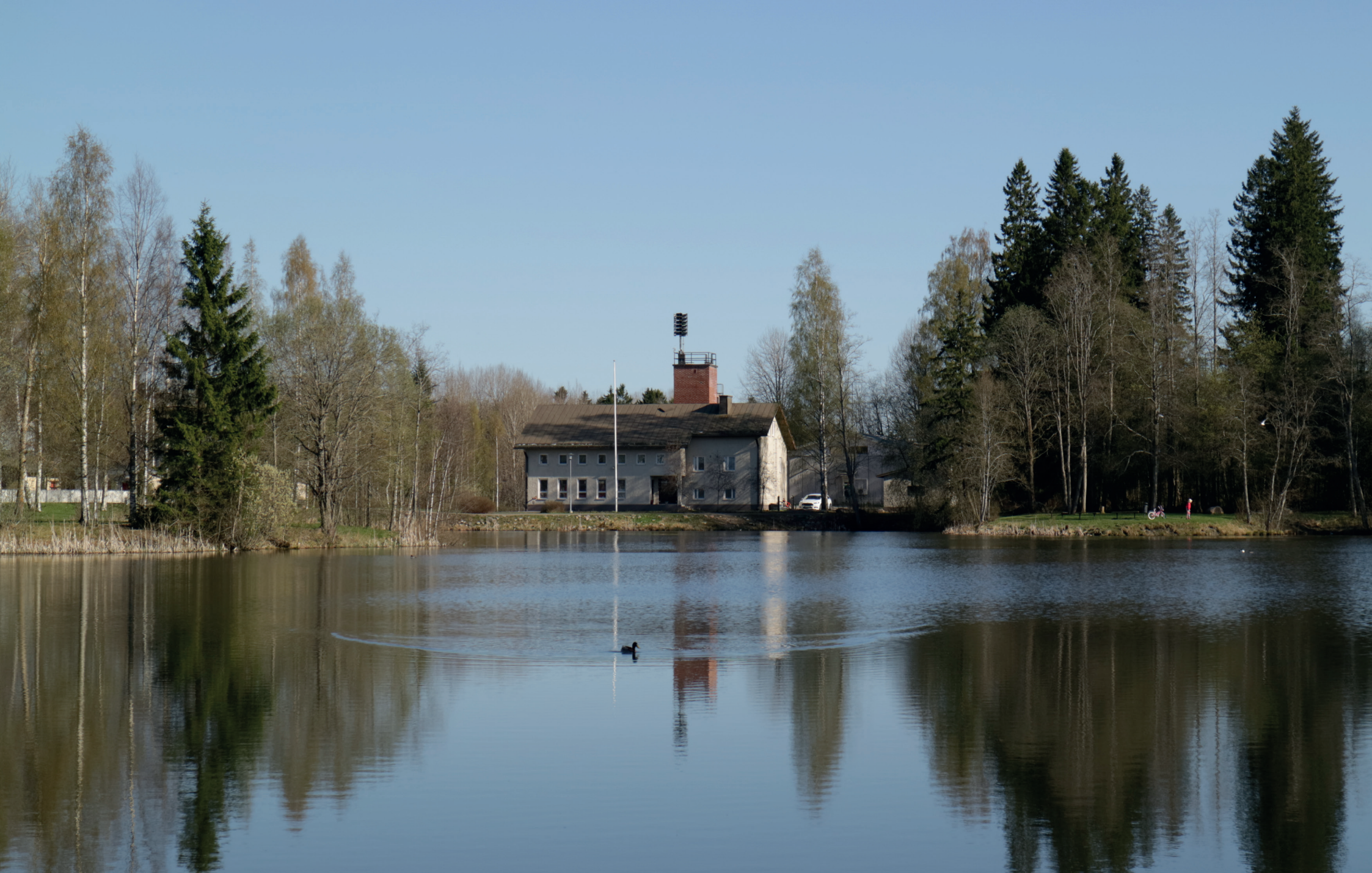
Jokelan paloasema Koululammen yli katsottuna
