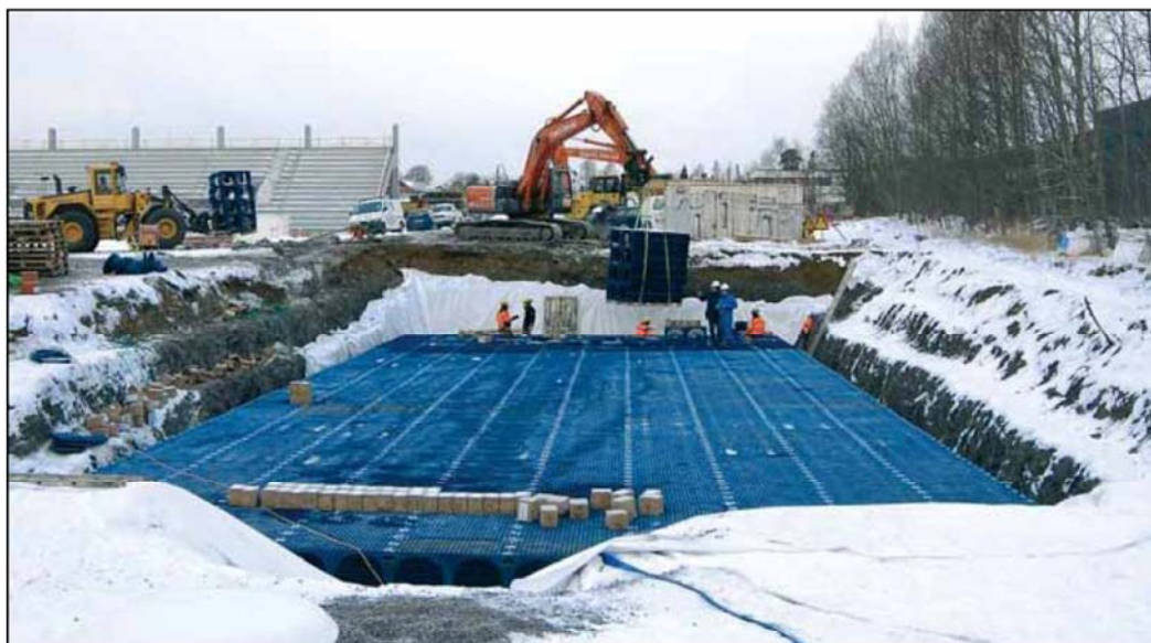
Kuva 11. Laaja-alaisen maanalaisen kennoston rakentaminen. Kohde sijaitsee Norjassa, Sandefjordissa. 11
