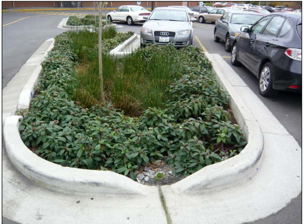
Kuva 9. Pysäköintialueen yhteydessä oleva biopidätysalue. 9
