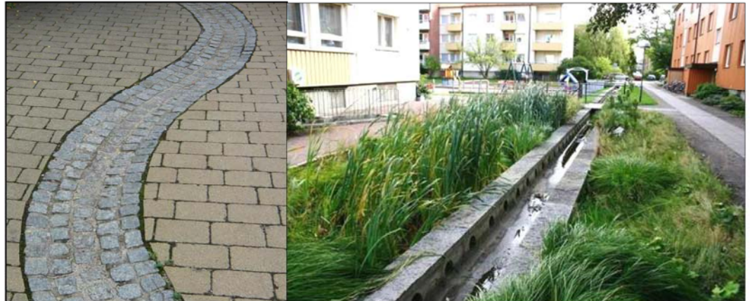
Kuva 7. Esimerkkejä hulevesien johtamisesta pintaratkaisuihin 6,7
