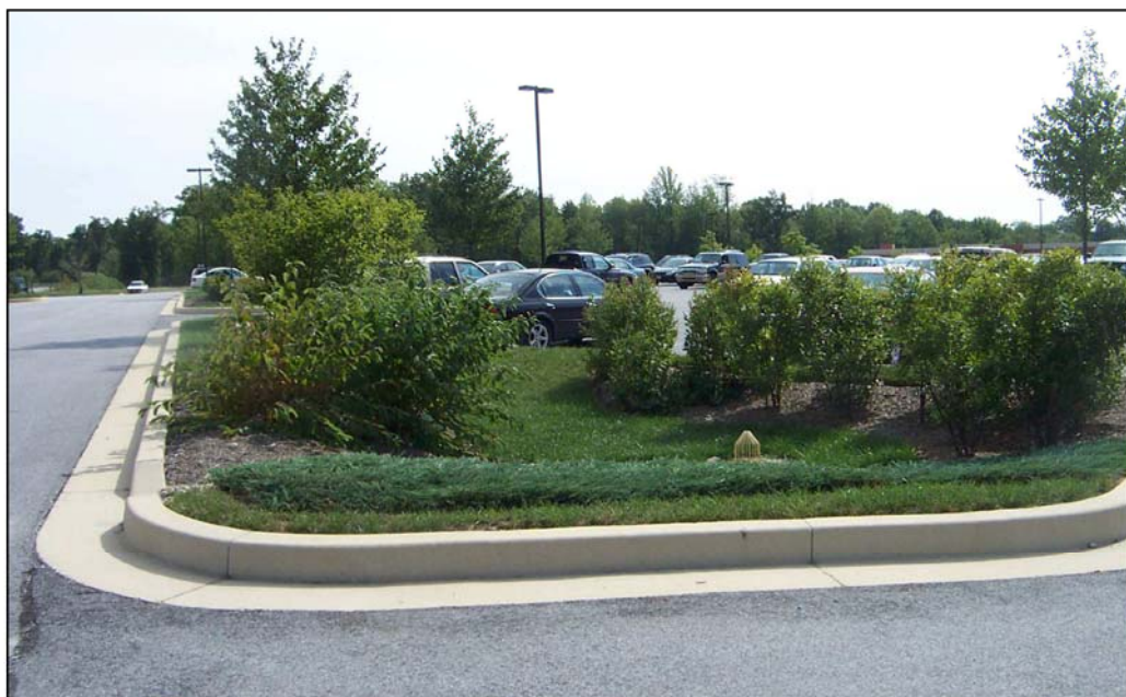
Kuva 10. Pysäköintialueen yhteydessä oleva biopidätysalue 10
