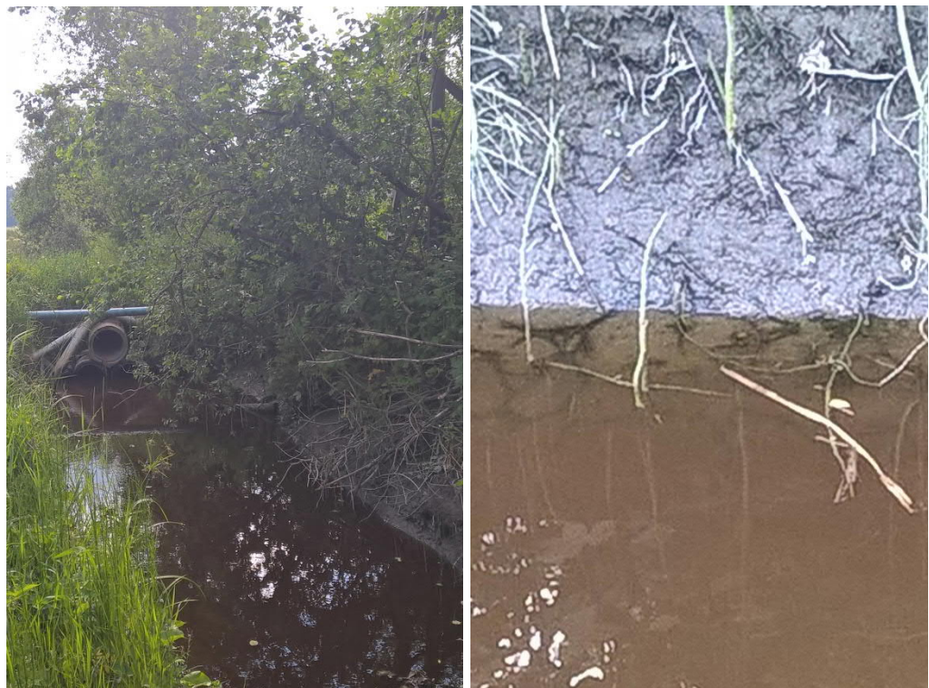
Kuva 5.26. a) Uomaan on asennettu liian pienet rummut, jotka ovat ylävirran puolelta täynnä roskaa. b) Uoman pohjassa on mustaa tuntematonta likaa ja veden väri on koko purosessa erikoinen.
