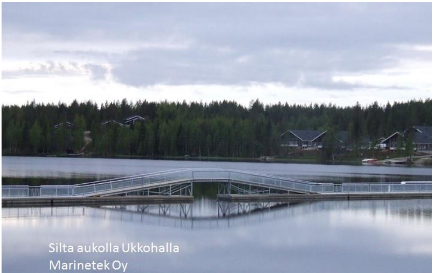
Silta aukolla, venepuomit ja levennys Ukkohalla Marinetek Oy
